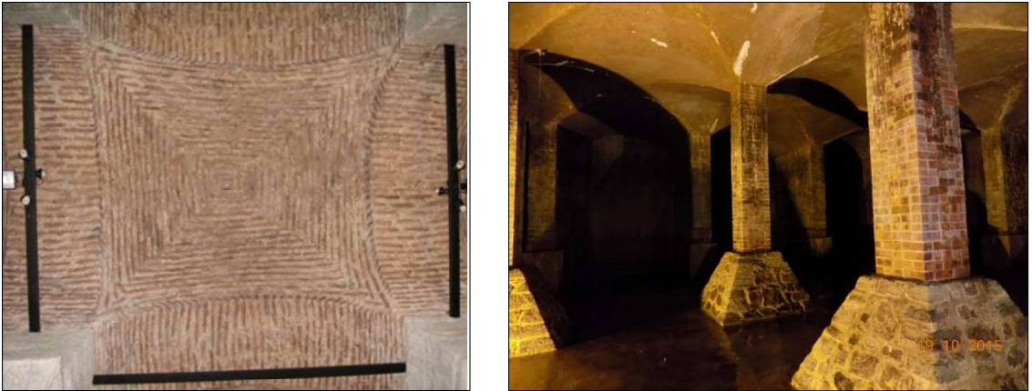
Şekil 3.22 Sultan Sarnıcı (Sol) [33] – Arnavutköy Su Deposu (Sağ) [31]
