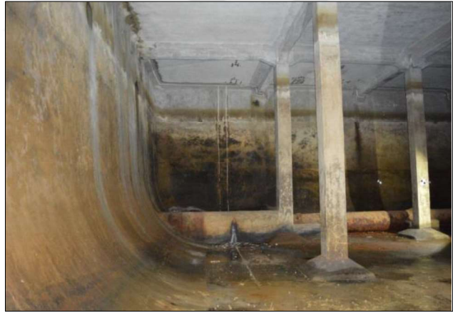
Şekil 3.19 Mokios (Altımermer) Sarnıcı köşe pahı (Sol) [32] - E2 su deposu eğimli iç yüzey (Sağ) [29]
