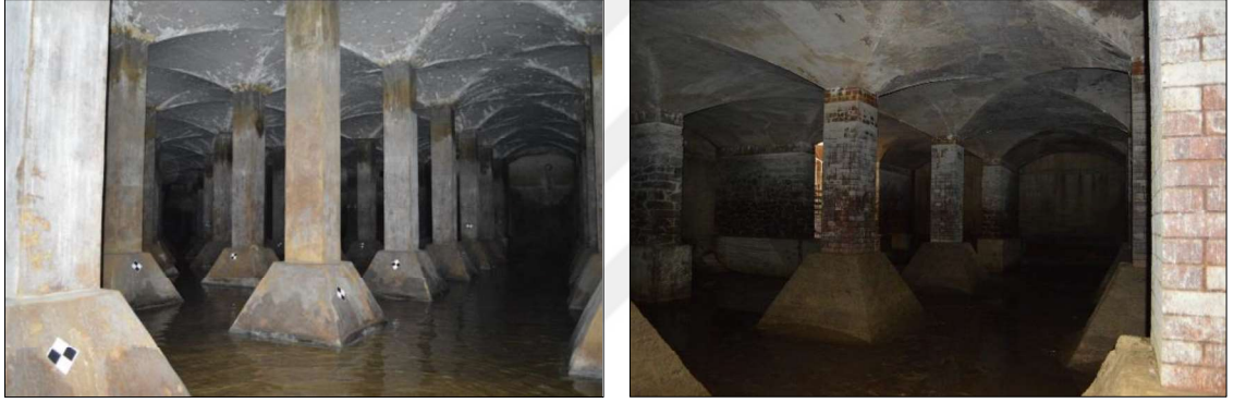
Şekil 3.21 Feriköy Su Deposu (Sol) [29] - Boyacıköy Su Deposu (Sağ) [31]
