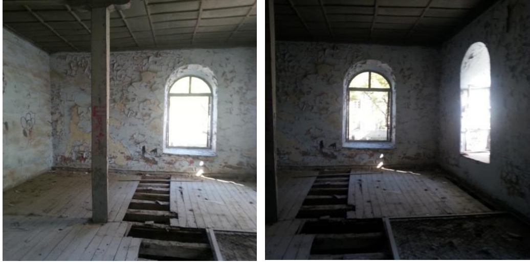
Fotoğraf 3.11 Redif Binası Zemin Kat-Z04 Mekanı (Oda), 2012
