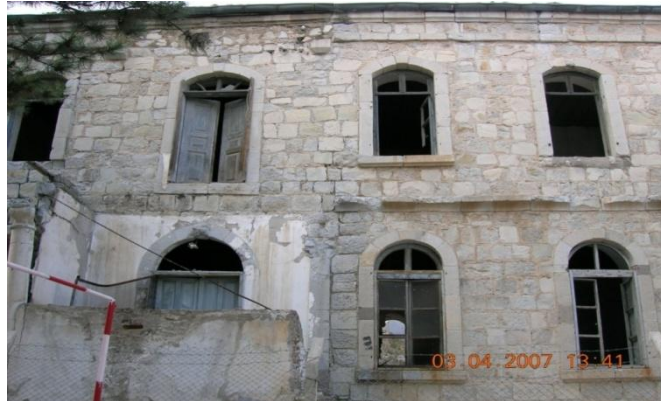
Fotoğraf 3.21 Redif Binası Doğu Cephesi, 2012
