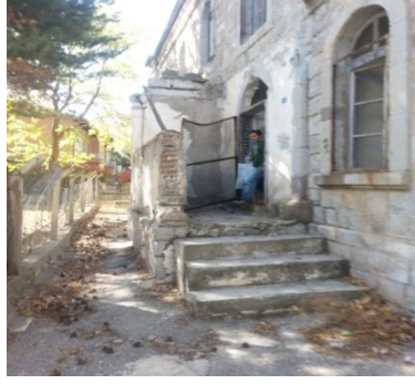
Fotoğraf 3.36 Redif Binası Giriş Merdiveni, 2012
