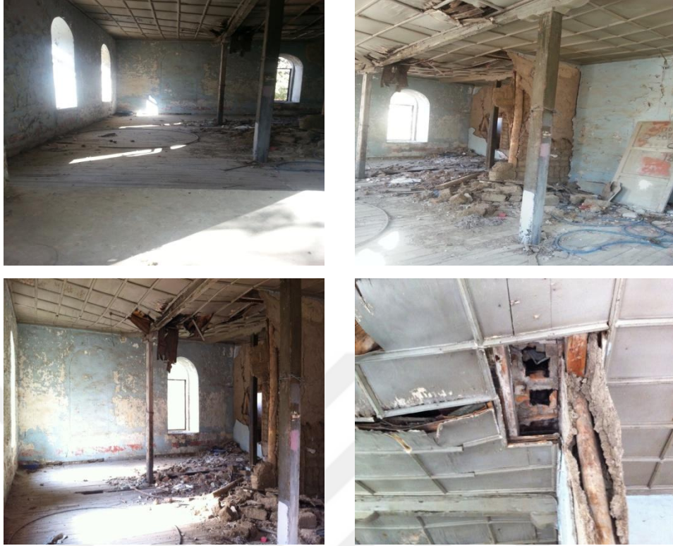
Fotoğraf 3.9 Redif Binası Zemin Kat-Z02 Mekanı (Oda), 2012
