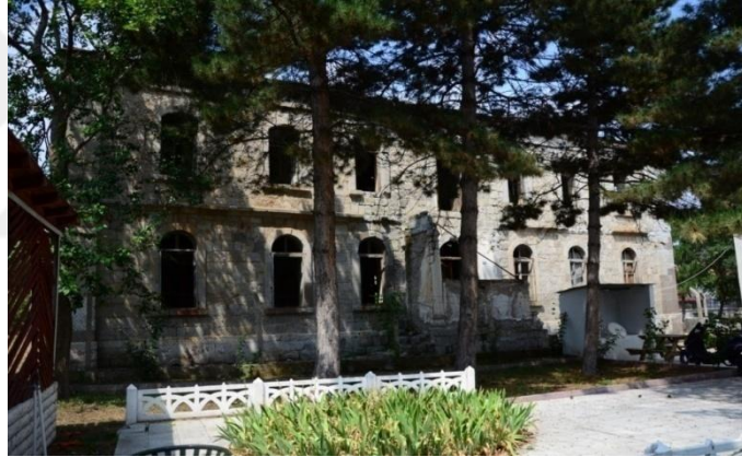
Fotoğraf 3.20 Redif Binası Doğu Cephesi, 2012
