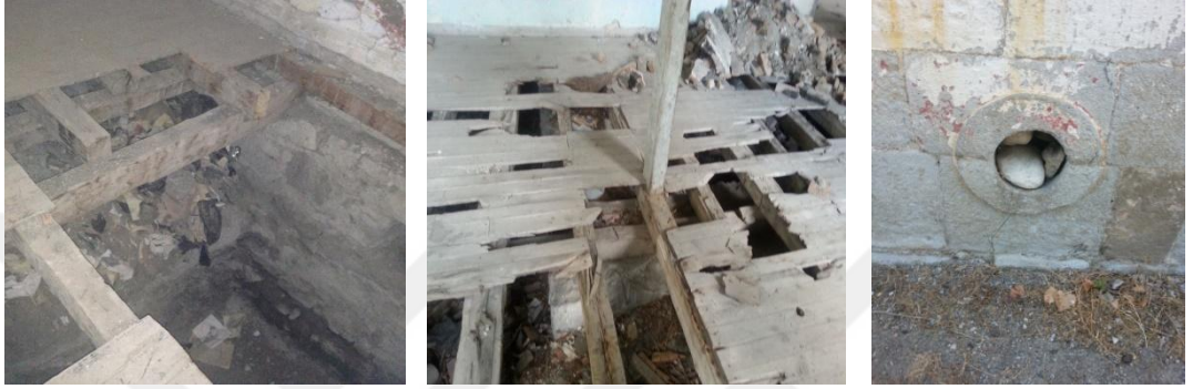
Fotoğraf 3.28 Redif Binası Temel Fotoğrafları,2012
