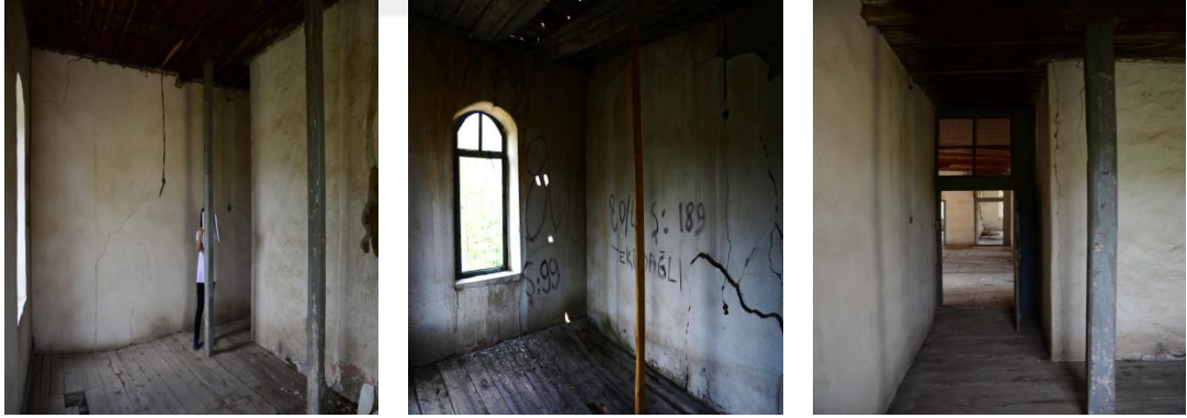
Fotoğraf 3.17 Redif Binası Birinci Kat-105 (Oda), 2012
