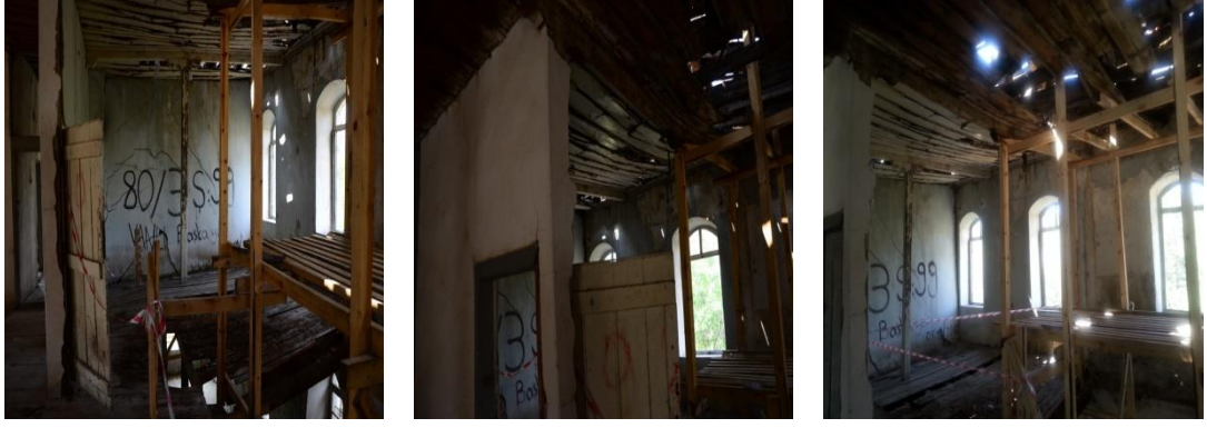
Fotoğraf 3.16 Redif Binası Birinci Kat-104 (Oda), 2012
