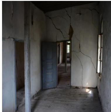
Fotoğraf 3.14 Redif Binası Birinci Kat-102 (Oda), 2012
