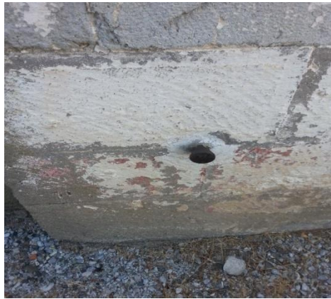
Fotoğraf 3.19 Redif Binası Cephesindeki Metal Çivi Detayı, 2012
