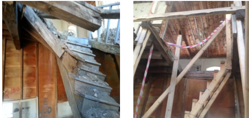
Fotoğraf 3.12 Redif Binası Zemin Kat-Z05 Mekanı (Merdiven Holü), 2012
