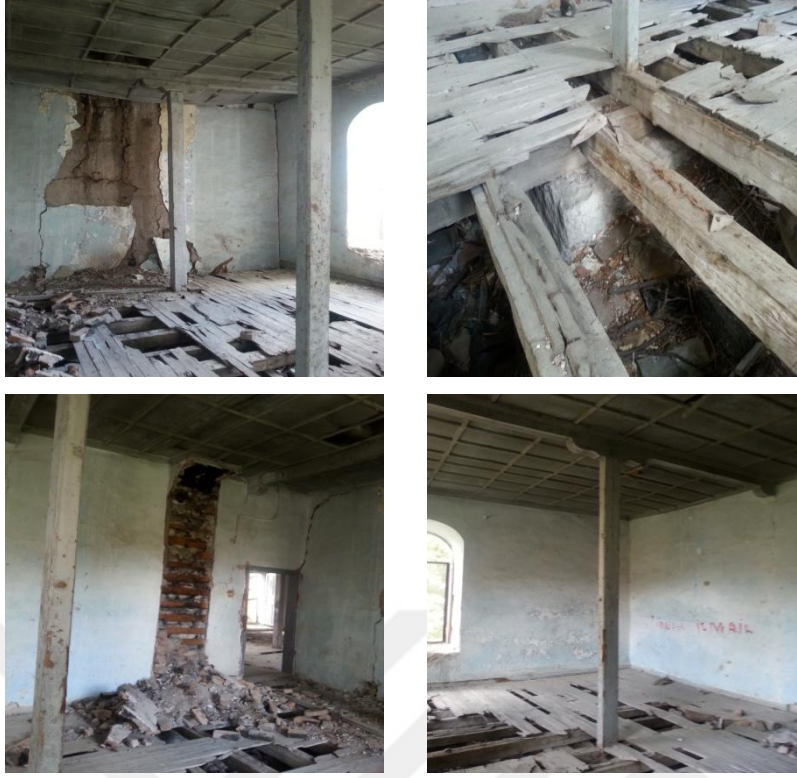
Fotoğraf 3.10 Redif Binası Zemin Kat-Z03 Mekanı (Oda), 2012
