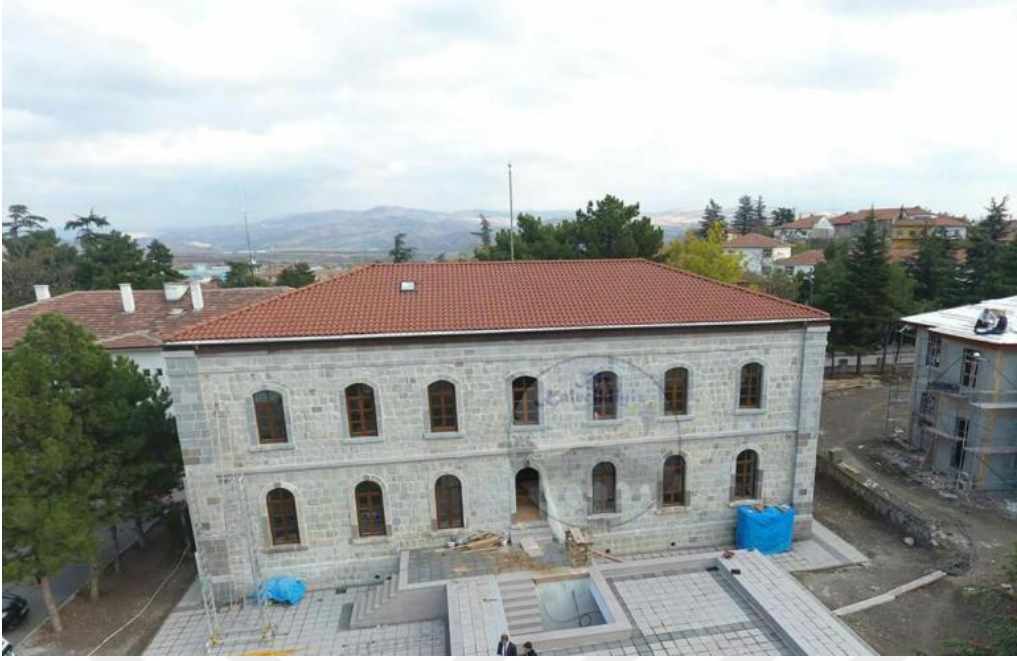
Fotoğraf 5.2 Kalecik Redif Binası Uygulama Süreci Fotoğrafları, Batı Cephesi
