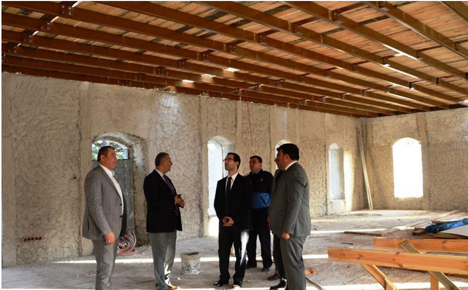
Fotoğraf 5.3 Kalecik Redif Binası Uygulama Süreci Fotoğrafları, Zemin
