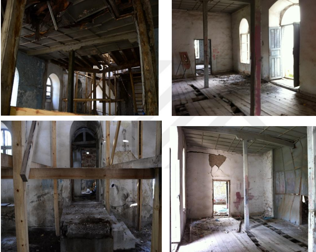
Fotoğraf 3.8 Redif Binası Zemin Kat-Kat Holü, 2012
