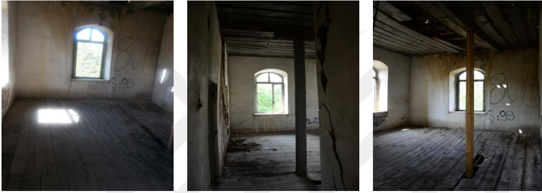
Fotoğraf 3.15 Redif Binası Birinci Kat-103 (Oda), 2012
