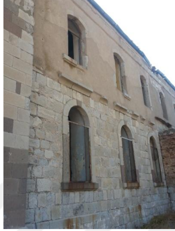
Fotoğraf 3.41 Cephedeki Parça Kopmaları, 2012
