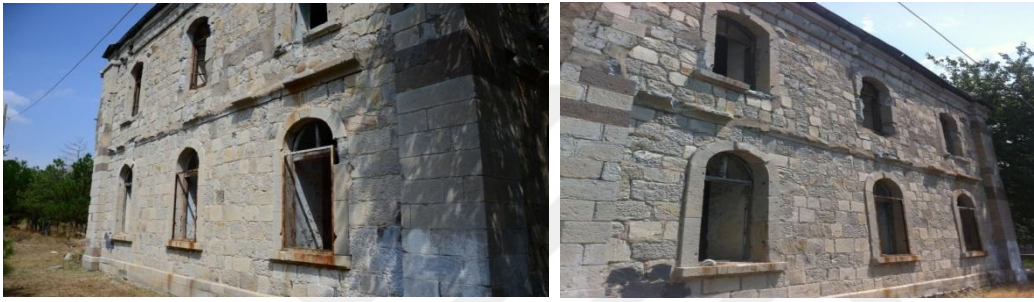
Fotoğraf 3.27 Redif Binası Güney Cephesi, 2012
