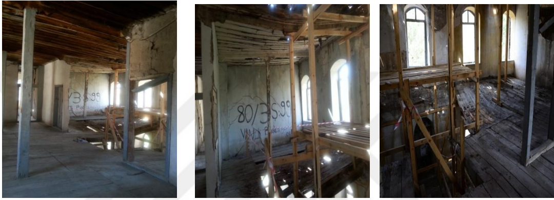
Fotoğraf 3.13 Redif Binası Birinci Kat-101 (Merdiven Holü,sofa ve oda), 2012
