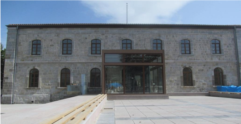
Fotoğraf 5.4 Kalecik Redif Binası Uygulama Sonrası Fotoğrafları
