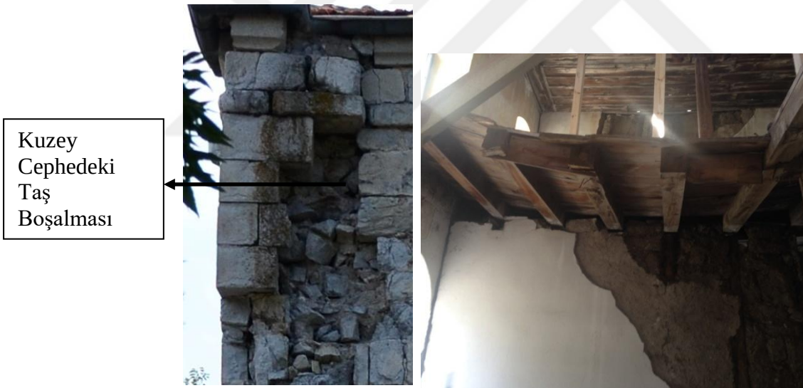
Fotoğraf 3.40 Kuzey Cephe'deki Taş Boşalması ve Ahşap Kirişlerdeki Bozulmalar,2012
