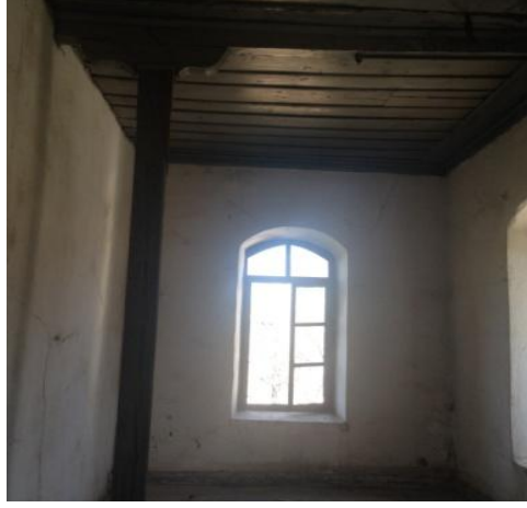
Fotoğraf 3.18 Redif Binası Birinci Kat-106 (Oda), 2012
