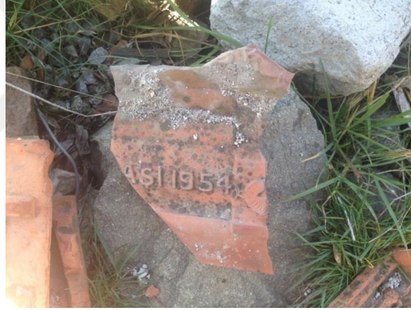
Fotoğraf 3.43 1950’li Yıllarda Yapılan Onarımdan Kalan Kiremit,2012
