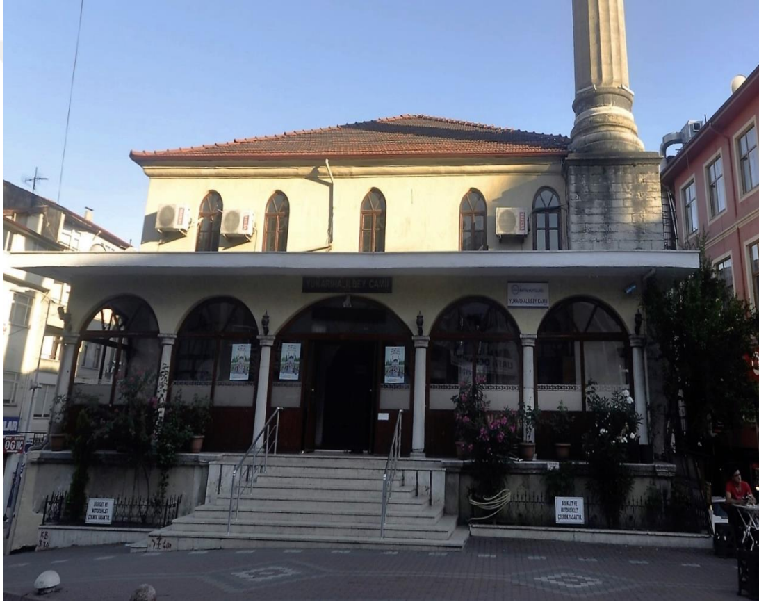
Foto 23: Yukarı Halil Bey Camii - Son Cemaat Bölümünün Dış Görünümü
