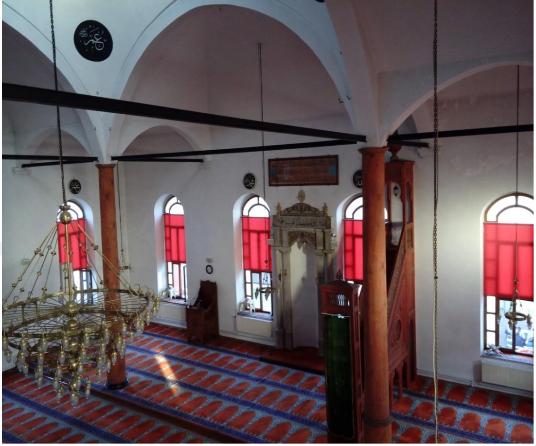
Foto 48: Orta İbrahim Paşa Camii - Üst Örtüyü Taşıyan Sistemden Bir Görünüm
