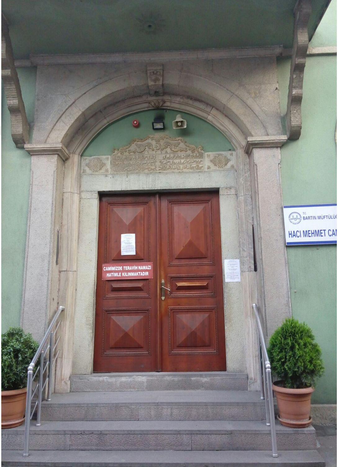
Foto 78: Hacı Mehmet Camii – Taç Kapısı
