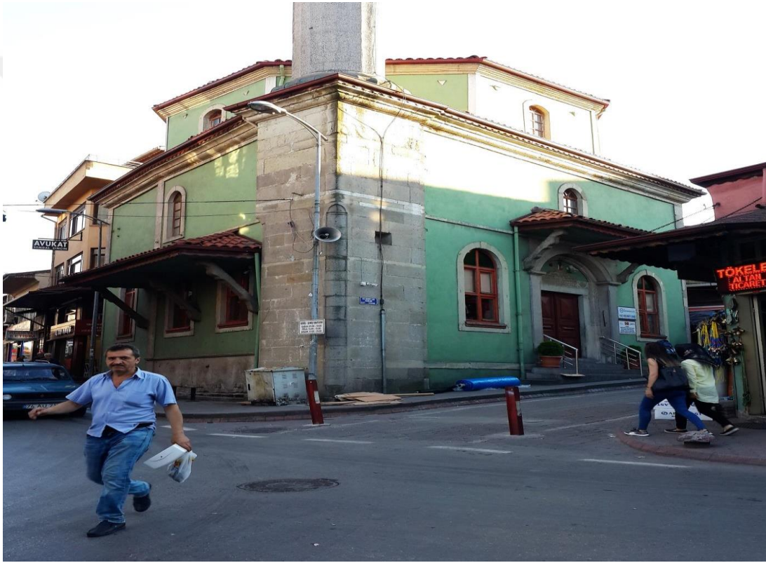
Foto 81: Hacı Mehmet Camii – Kuzeydoğu Cephesi
