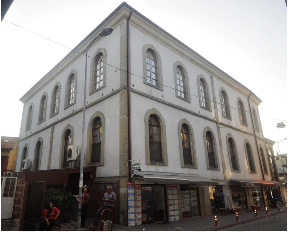
Foto 90: Aşağı Camii - Güneydoğu Cephesi
