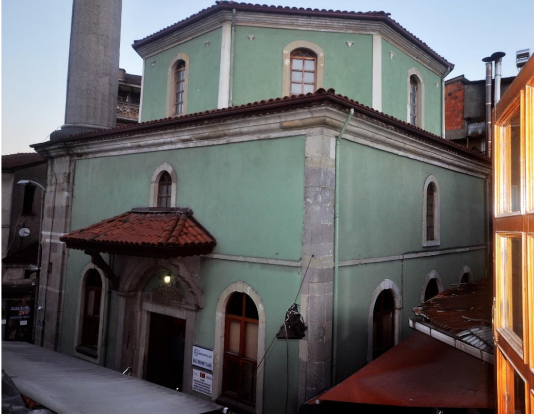
Foto 80: Hacı Mehmet Camii – Kuzeybatı Cephesi
