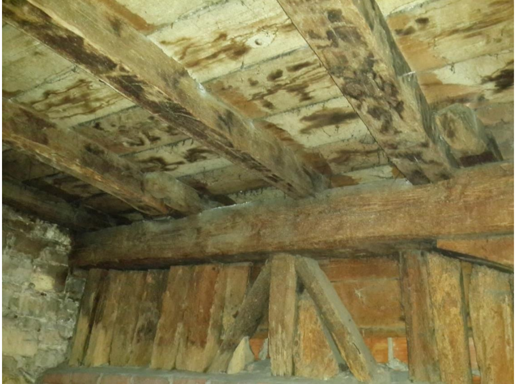
Foto 22: Yukarı Halil Bey Camii – Dükkanların Tavanındaki Ahşap Konstrüksiyon
