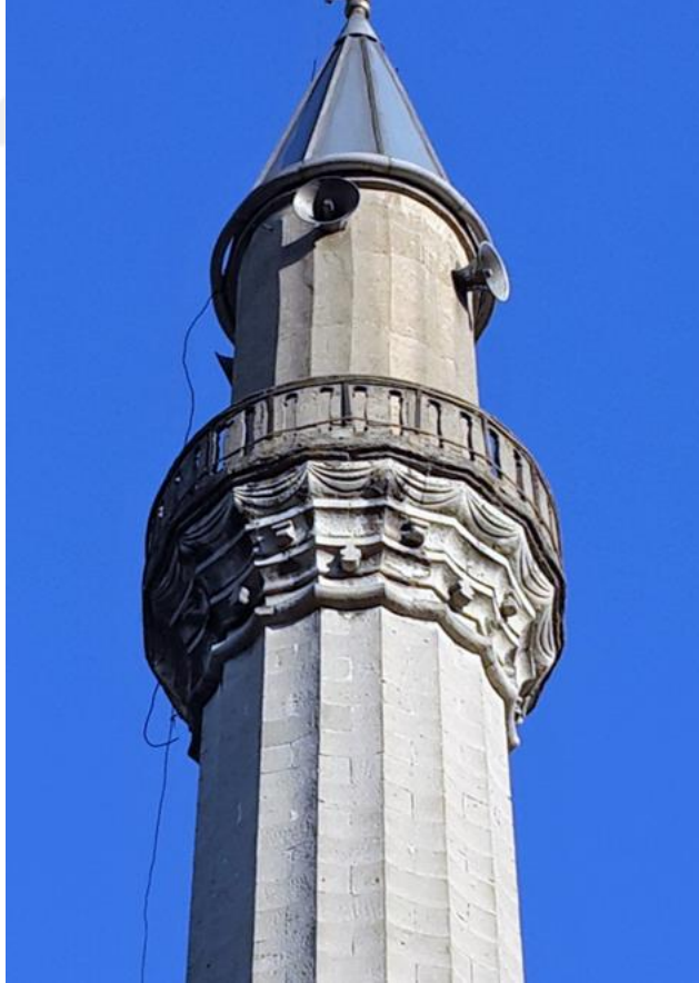
Foto 76: Kemer Köprü Camii - Minareden Detay
