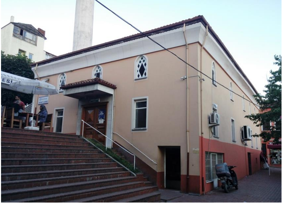
Foto 10: Arap Camii – Kuzeypatıdan Görünümü
