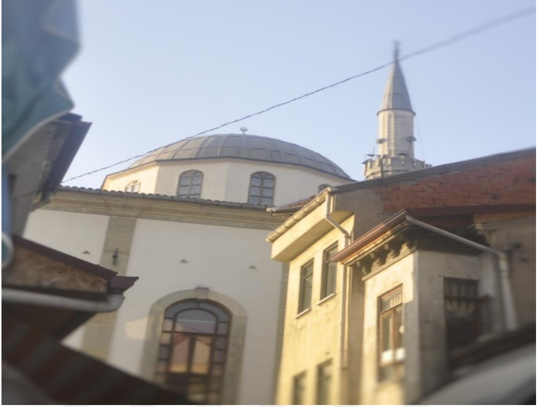
Foto 43: Orta İbrahim Paşa Camii - Üst Örtüden Görünüm
