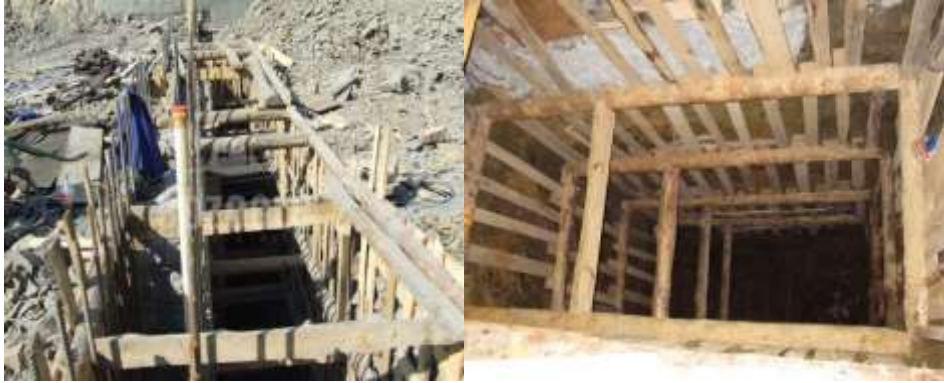
Şekil 2.9 Kuyu perde duvar
