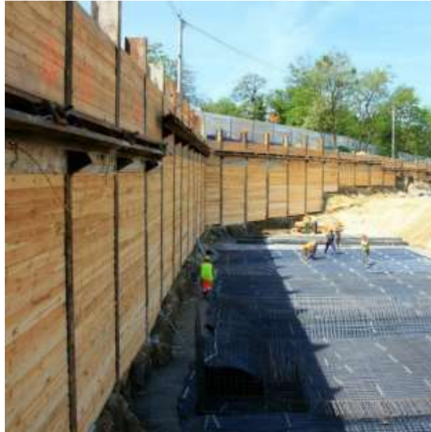
Şekil 2.13 Ahşap kaplamalı Berlin duvarı
