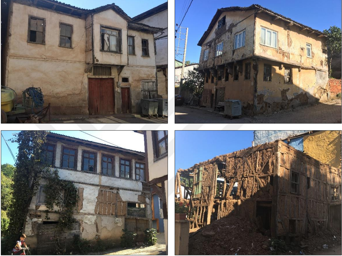
Şekil 3.50 Yeni Sölöz Mahallesi konut örnekleri
