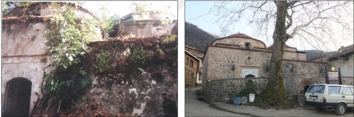
Şekil 3.22 Restorasyondan önce [60] ve sonra Gürle Mahallesi hamamı
