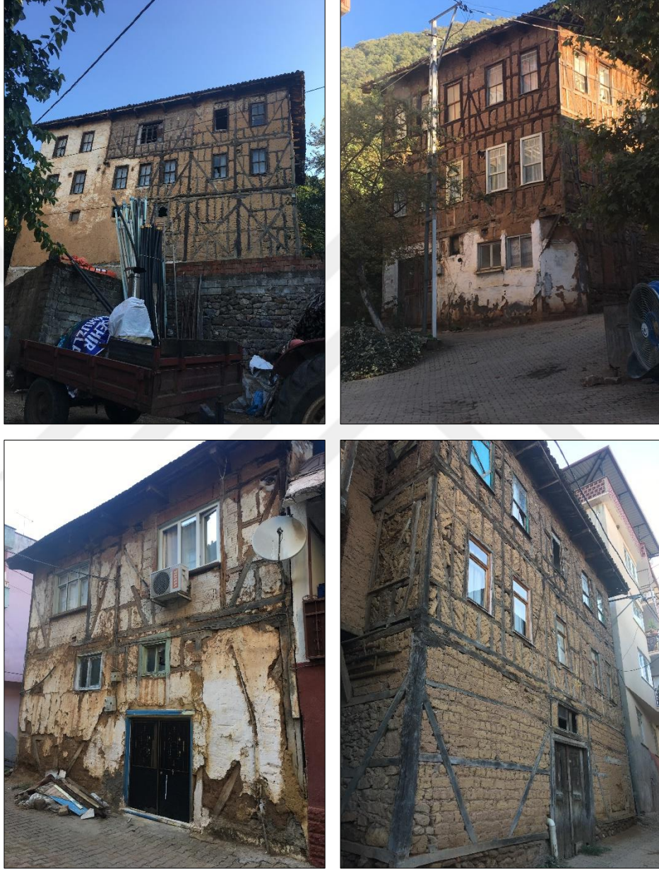
Şekil 3.59 Narlıca Mahallesi konut örnekleri
