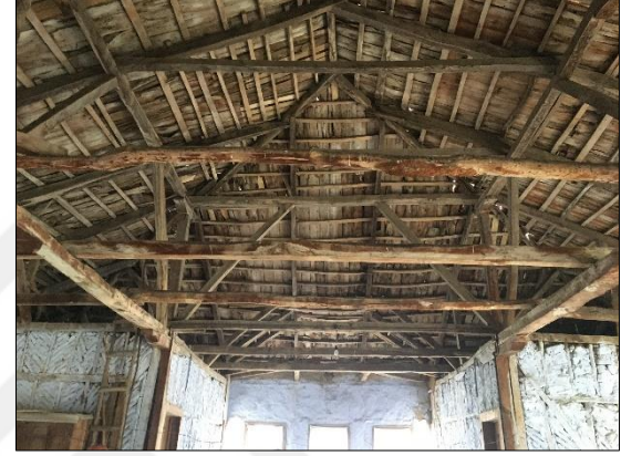
Şekil 3.70 Gürle’deki bir konutun ipek böcekçiliği için kullanılmış olan çardak 1 ve çatı konstrüksiyonu
