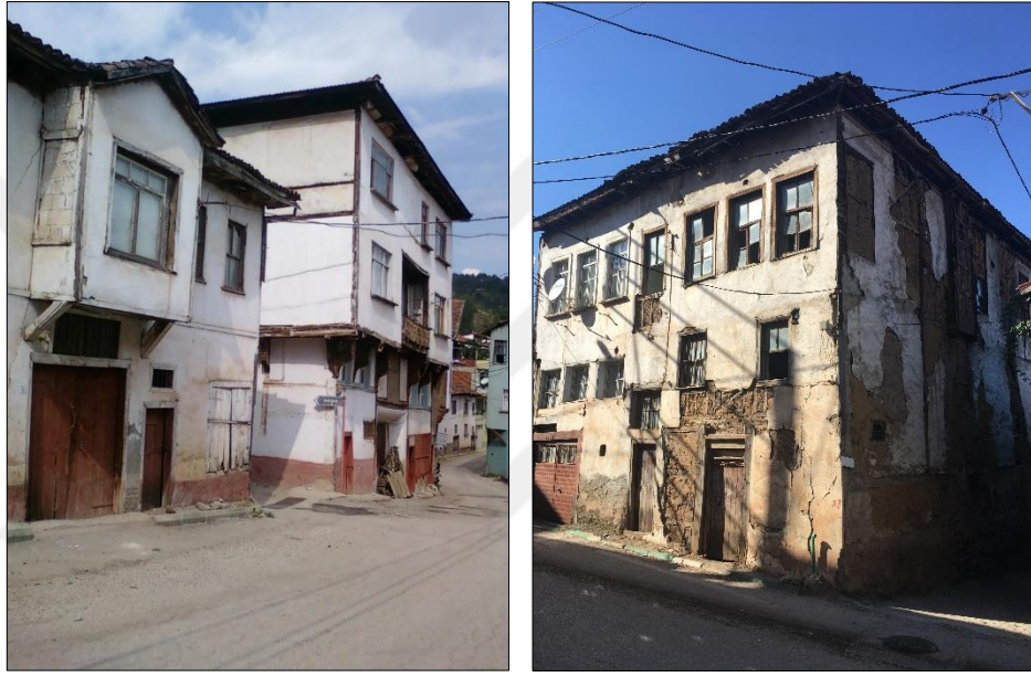
Şekil 3.49 Yeni Sölöz Mahallesi konut örnekleri
