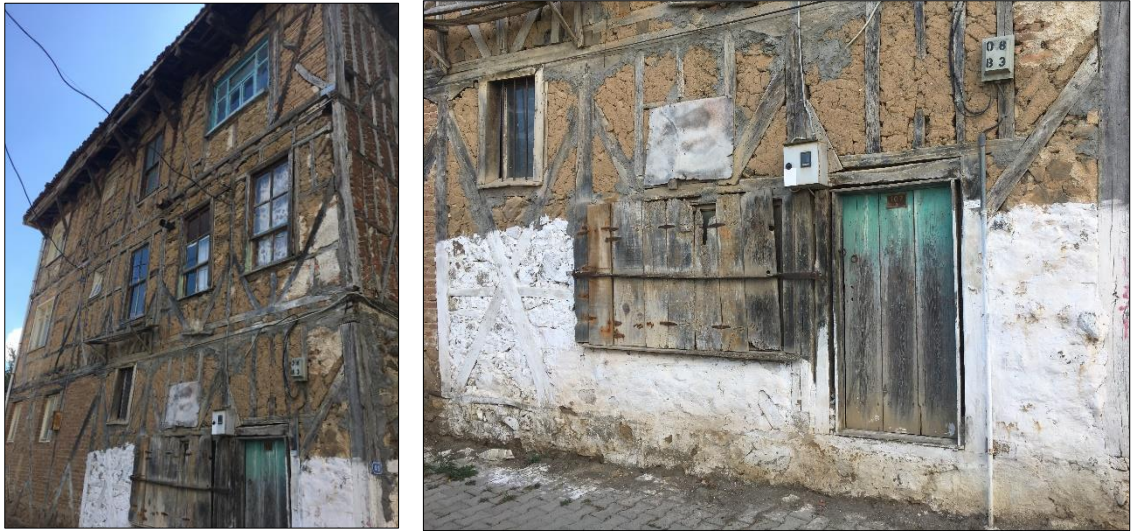
Şekil 3.20 Gürle Mahallesi'nde zemin katı bakkal olan konut örneği
