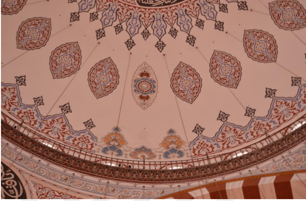
Fotoğraf 190: İstanbul ŞehzadeCami Restorasyon Öncesinde Kubbe İçinde Yer Alan Süsleme
