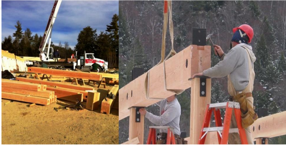
Şekil 1.26. Montaj yöntemi örnekleri ve ağır kiriş ayarı [33]
