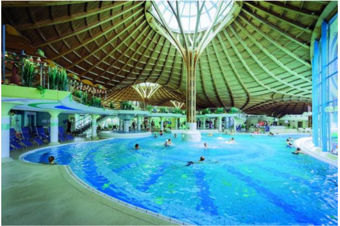
Şekil 1.55. Tutkalın ahşap kabuklarda uygulamasına örnek, (Termal havuz) Dürreim, Almanya yapım yılı:1987 [48]
