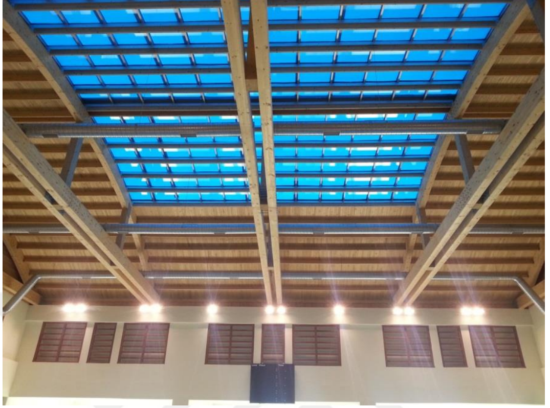
Şekil 3.10. Kocaeli- Körfez yüzme havuzu şantiye çatı içeriden görünüş (2013), [20]
