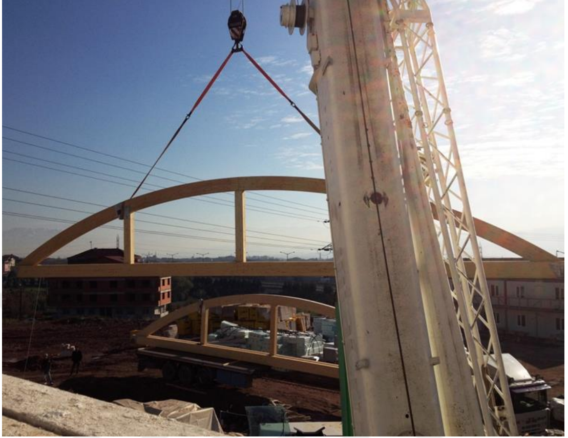
Şekil 3.8. Kocaeli- Körfez yüzme havuzu şantiye montaj fotoğrafları (2013), [20]
