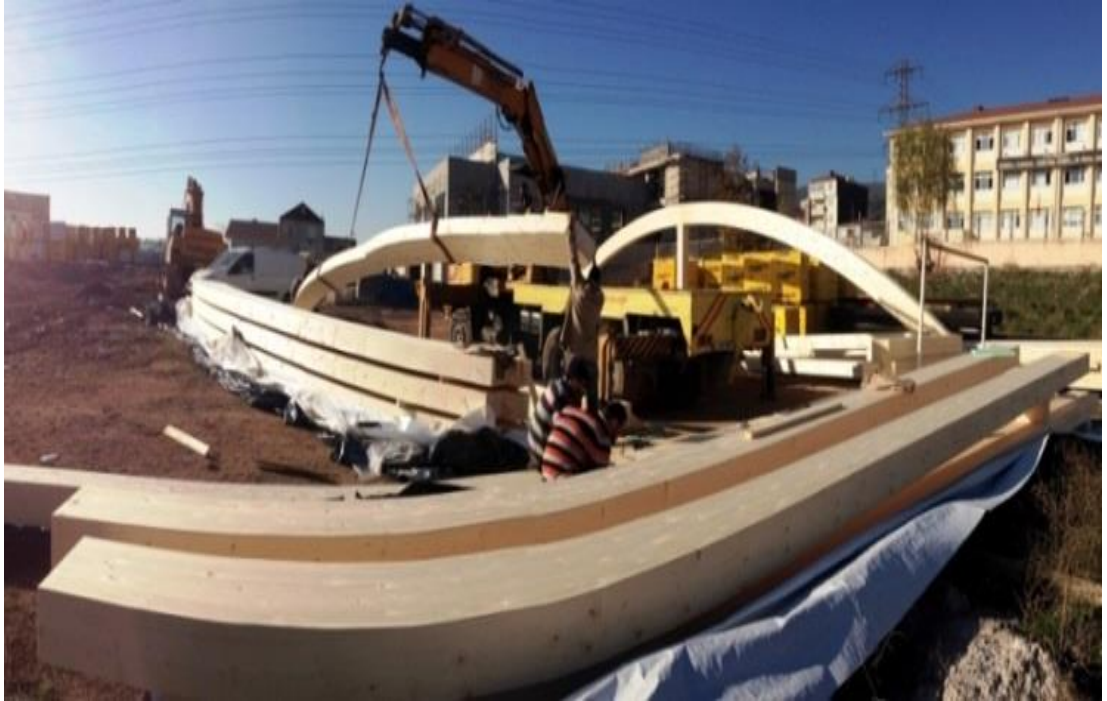
Şekil 3.7. Kocaeli- Körfez yüzme havuzu şantiye montaj fotoğrafları (2013), [20]
