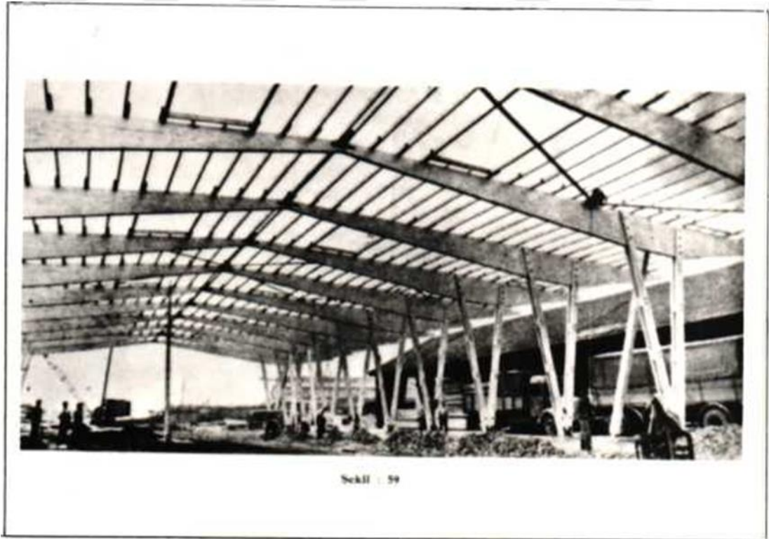
Şekil 1.37. Dikdörtgen kesitli hetzer sistemi ile uygulama örneği [1]
