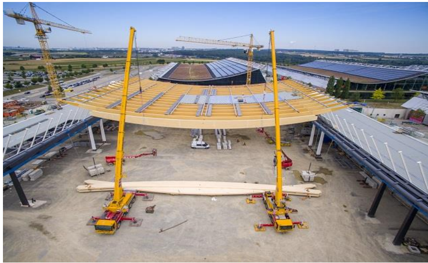
Şekil 2.1. Yurt dışı örnekler, yeni fuar binası (Salon 10) Messe Stuttgart, yapım yılı: 2016 [57]
