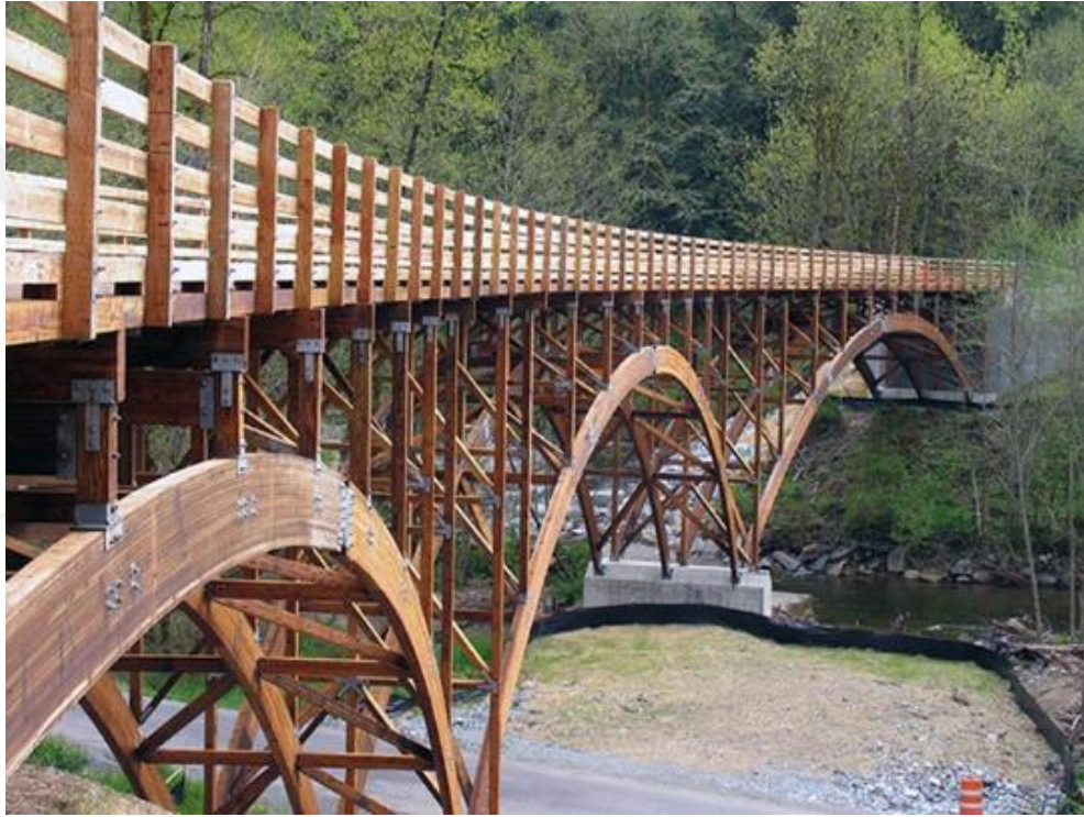
Şekil 2.7.Yurt dışı örnekler, üç açıklı demiryolu köprüsü Buckley, Washington (ABD), yapım yılı: 2008 [64]
