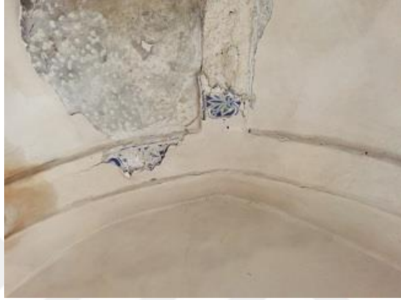
Şekil 3.98. Ahmed Beg Evin (B2) odası süsleme bozulması
