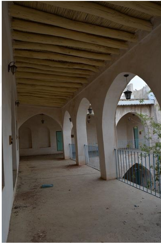
Şekil 3.43 K. H. Mecid evi Evin 1.kat Revakı
