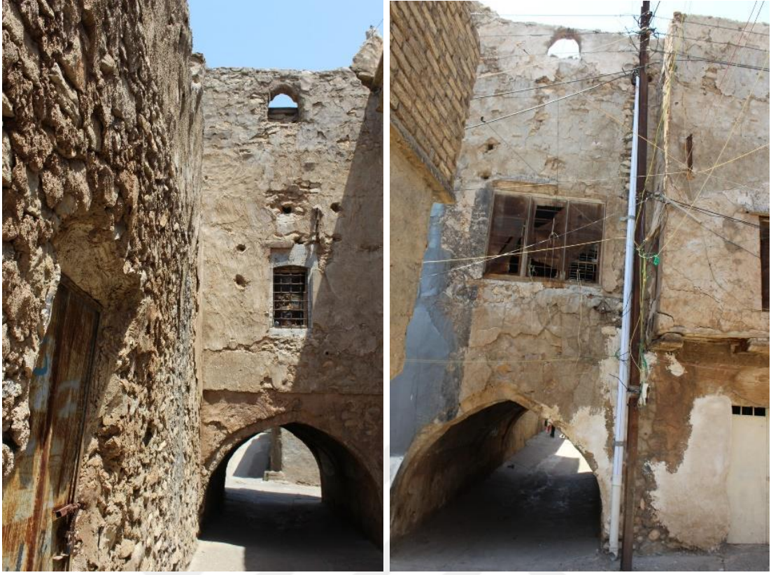
Şekil 3.77. , Şekil 3.78 Ahmed Beg Evin taklı sokağı
