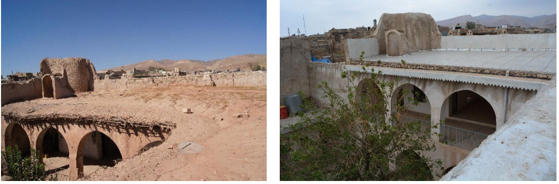
Şekil 4.18. Damlar (Restorasyon Öncesi ve Sonrası)
