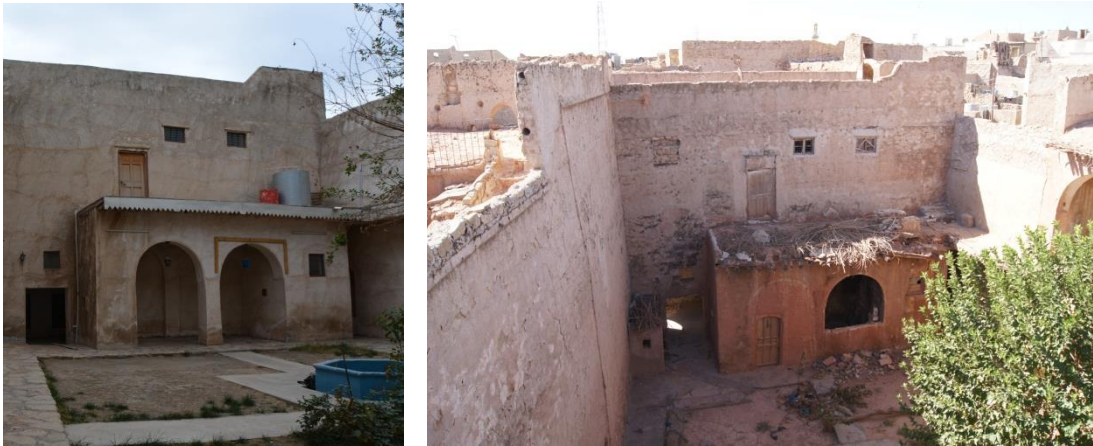
Şekil 3.33. , Şekil 3.34. K. H. Mecid evi Evin Mutfağı restorasyondan öncesi ve sonrası (Z3)
