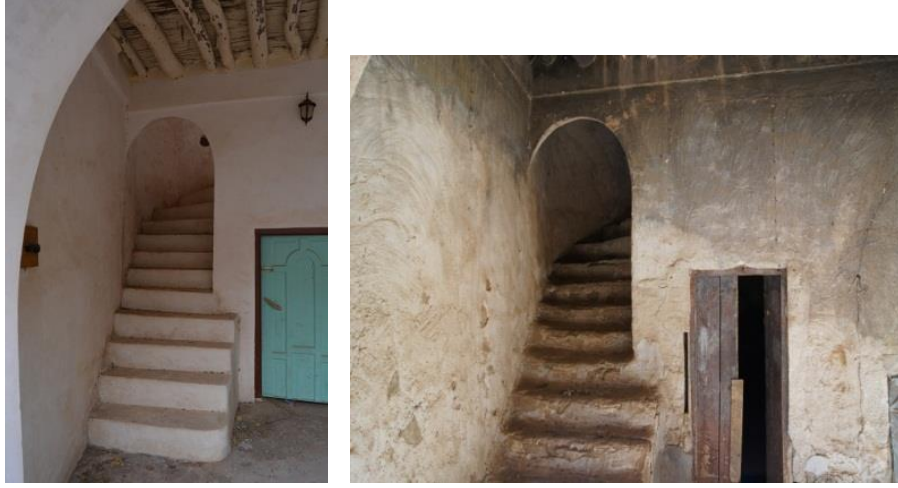
Şekil 3.41. K. H. Mecid evi Evin zemin kat merdiveni
