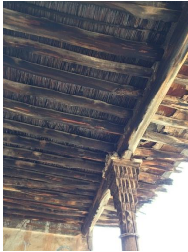
Şekil 4.11. Eyvanda Kullanılan Ahşap Döşeme ve Kolon
