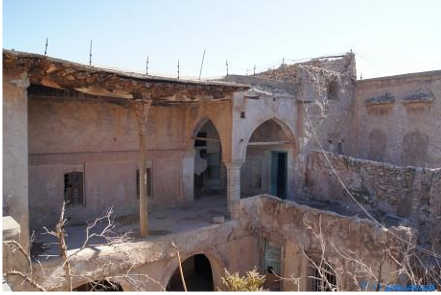
Şekil 3. 89. Ahmed Beg Evin avludan birinci kat görünüşü
