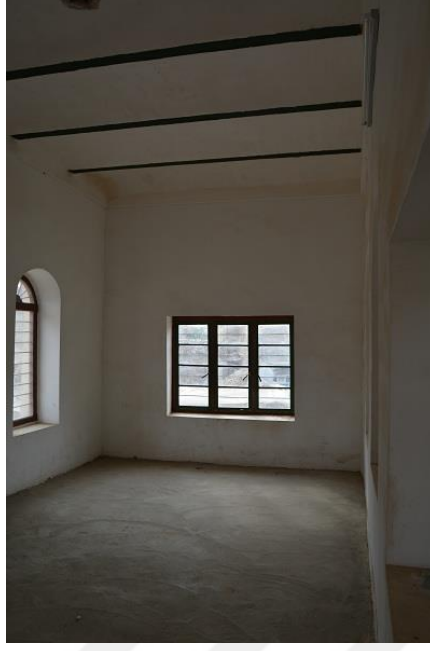
Şekil 4.9. Koye evlerinde kullanılan Volta tavan sistemi
