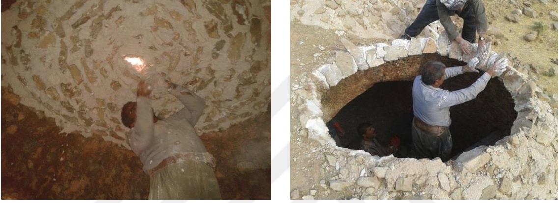
Şekil 2.40. Han Mira'nın kubbe restorasyonu
