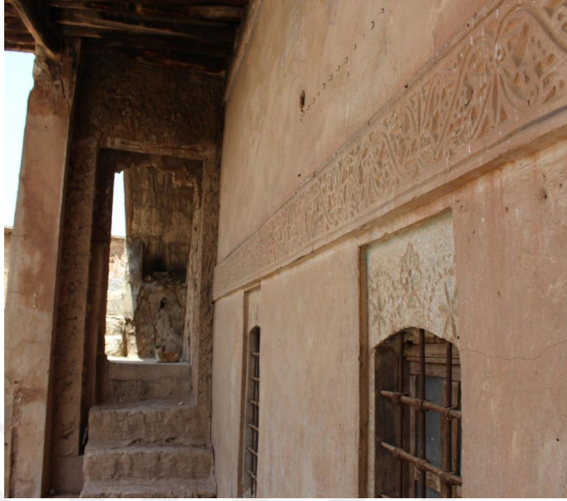
Şekil 3.103. Ahmet Beg evi 1. kat Eyvan ve 2. kata çıkan merdiven görünüşü
