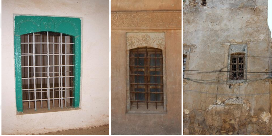
Şekil 4.19. Pencere ve Korkuluk Demirleri
