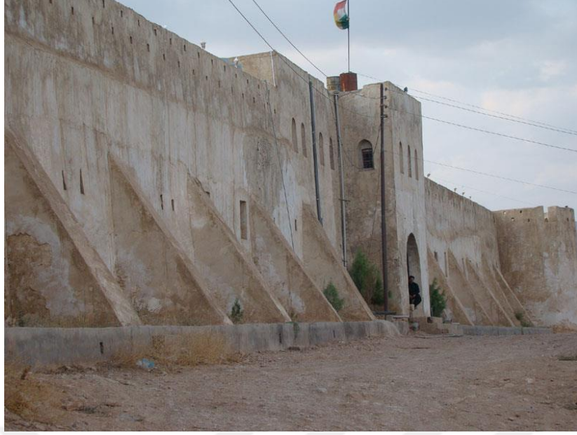
Şekil 2.18. Kışlanın ön cephesi
