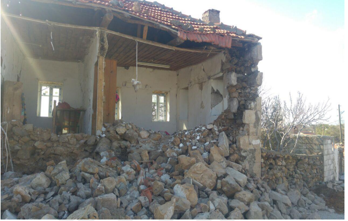
Şekil 1.30. Bölgedeki genel hasar gören yapı kesiti (İ.M.O.Ç.Ş., 2017, s. 5)
