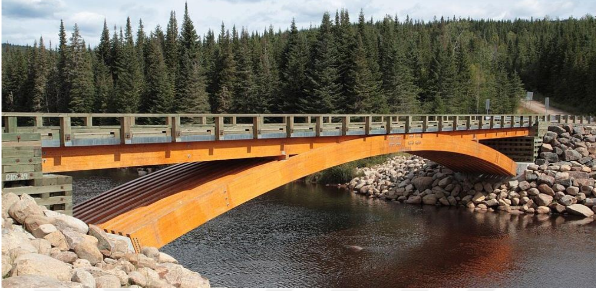
Şekil 2.1. Montmorency Nehri üzerinde bulunan tutkallanmış lamine kereste köprü uygulaması (“Wood bridge Montmorency”, 2015)
