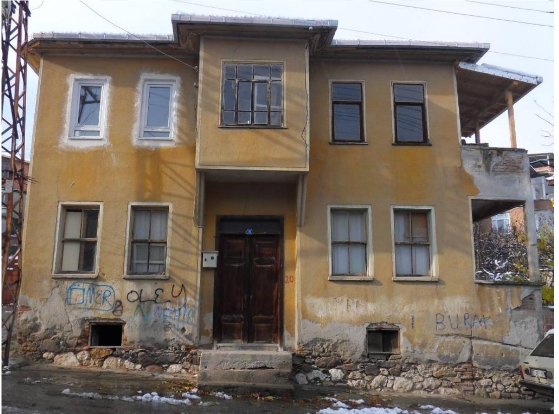
Şekil 3.48 Su Basman Kotunun Bodrum Kat Olarak Kullanıldığı Yapı Örneği (3 Numaralı yapının Bayram Caddesi'nden görünüşü)
