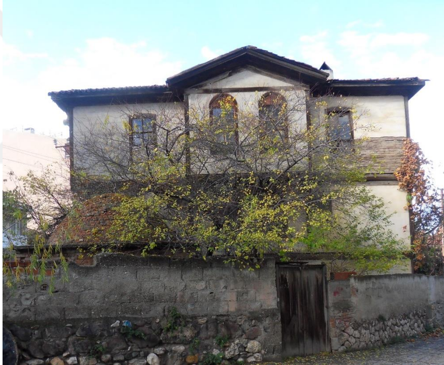
Şekil F.1 75. Yıl Caddesi ile Telgrafçı Sokak Kesişimindeki Yapı (Camii Kebir Mahallesi, 102 Ada, 2 Parsel) Kaynak: S. Erbey Arşivi, 2015
