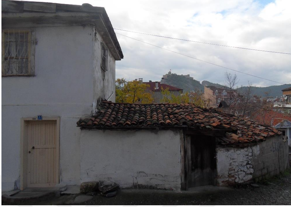
Şekil F.2 Baklacı Sokak'ta Bahçesinde Ocak Bulunan Yapı (Camii Kebir Mahallesi, 97 Ada, 9 Parsel) Kaynak: S. Erbey Arşivi, 2015
