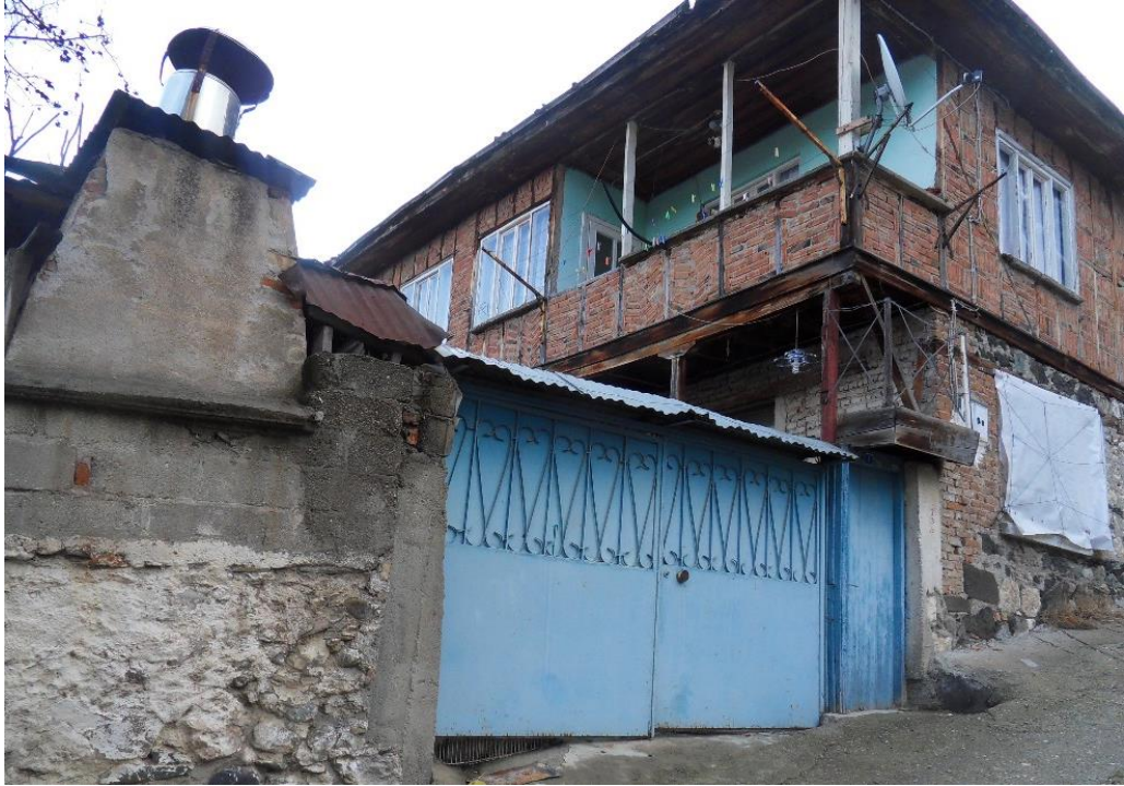
Şekil F.3 Oluk Sokak'ta Bahçesinde Ocak Bulunan Yapı (Zincirli Kuyu Mahallesi 394 ada 24 parsel) Kaynak: S. Erbey Arşivi, 2015
