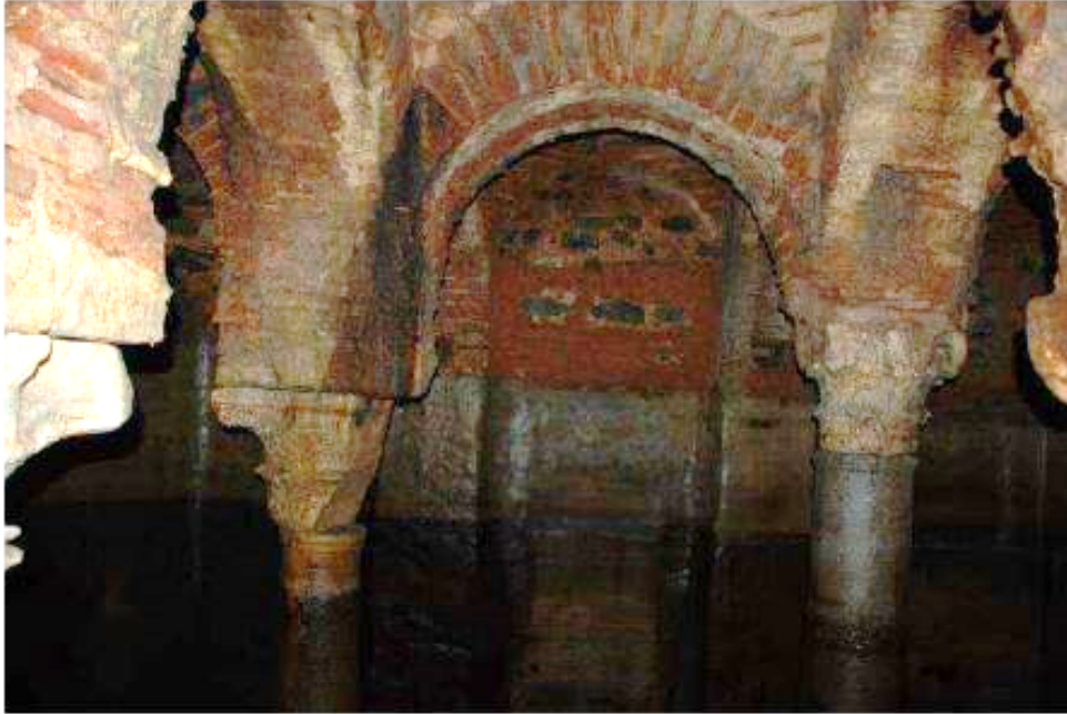
Şekil 9: Sarıncılı Hidrolik Sıvalı Duvarları (Temizer, T., Nemli, N. ve Arkadaşları, 2012)
