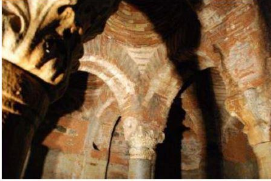
Şekil 10: Kubbeyi Destekleyen Kemerli Tuğla (Temizer, T., Nemli, N. ve Arkadaşları, 2012)
