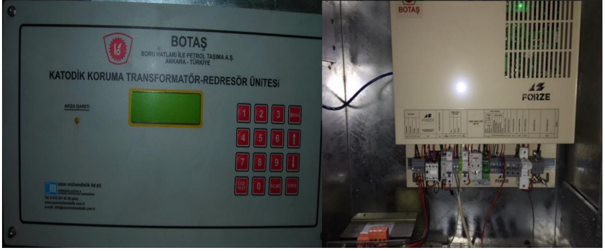
Şekil 5.5. Katodik koruma redresör ünitesi ekran modülü (a) güç modülü (b)
