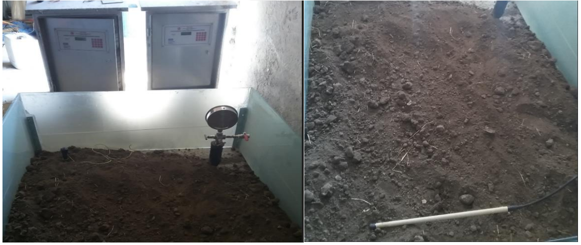
Şekil 5.6. Katodik koruma redresör üniteleri (a), titanyum tüp anot (b)
