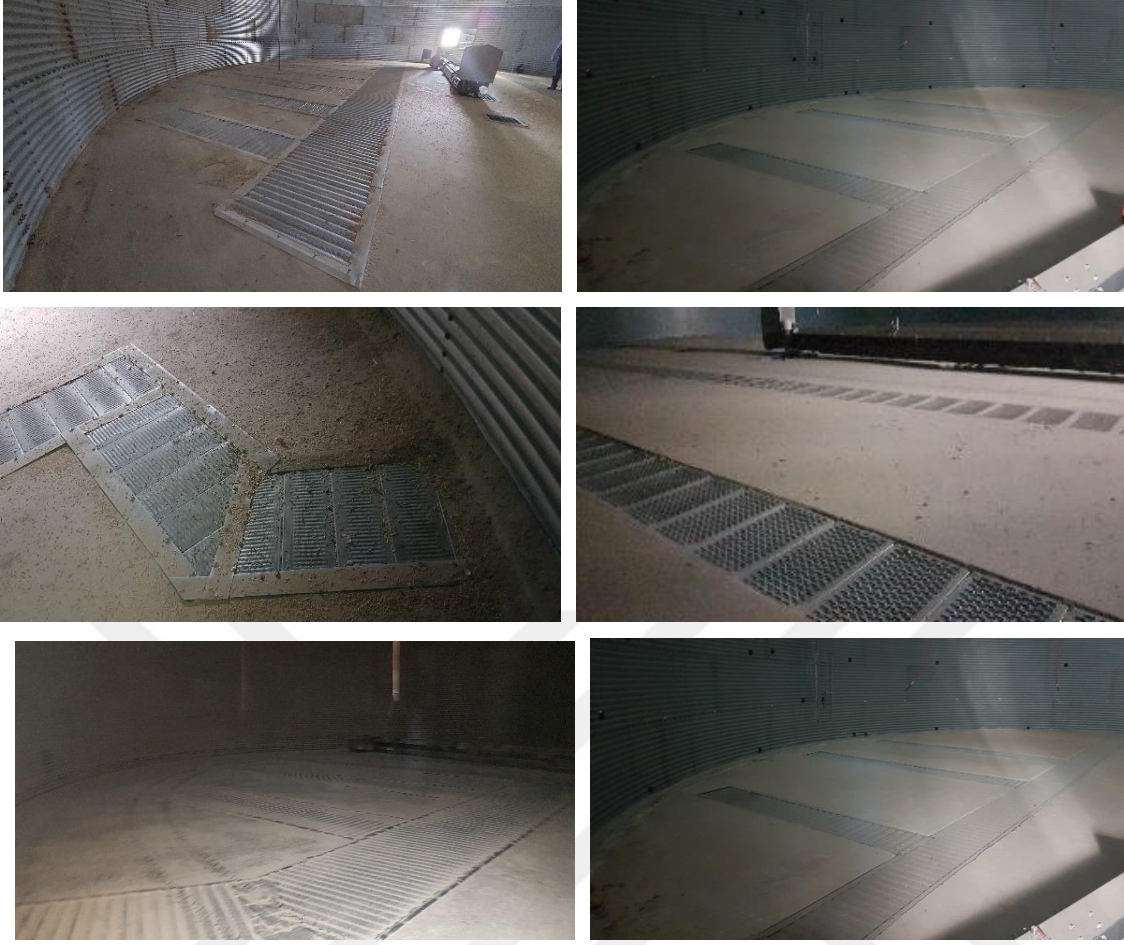
Ek Şekil 18. Düz tabanlı çelik silolarda kullanılan havalandırma sistemleri
