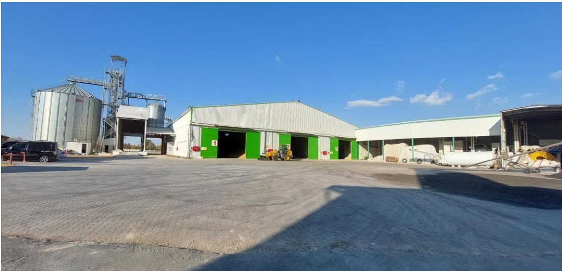
Şekil 3.7. Araştırmanın yürütüldüğü yatay betonarme ve çelik siloya ait bir görüntü
