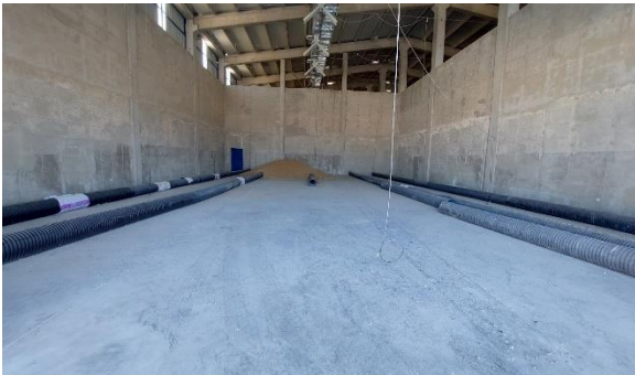
Şekil 4.27. Yatay betonarme hububat depolarında kullanılan havalandırma sistemlerine ait görüntüler
