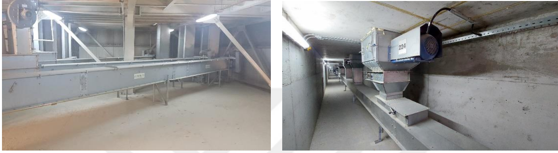
Ek Şekil 10. Depolardan ürünlerin boşaltılması ve konveyörlerle iletimi
