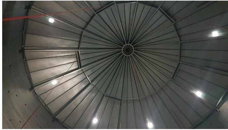
Ek Şekil 13. Sıcaklık ölçüm halatlarının çatı kirişine aplikasyonu
