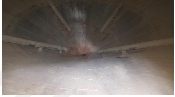
Şekil 4.26. Çelik silolarda kullanılan havalandırma sistemlerinin depo içerisinde yerleşimine ait görüntüler
