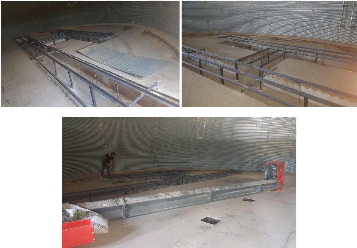
Şekil 4.24. Havalandırma kanallarının açılması ile ilgili görüntüler
