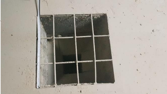
Ek Şekil 9. Silolarda ürünlerin boşlatılmasını sağlayan boşaltım kapakları
