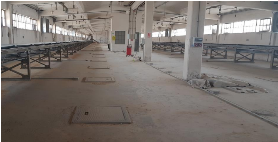
Şekil 4.32. Üzerinde ilave kat bulunan beton silo
