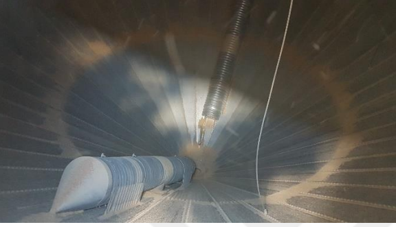
Şekil 4.26. Çelik silolarda kullanılan havalandırma sistemlerinin depo içerisinde yerleşimine ait görüntüler
