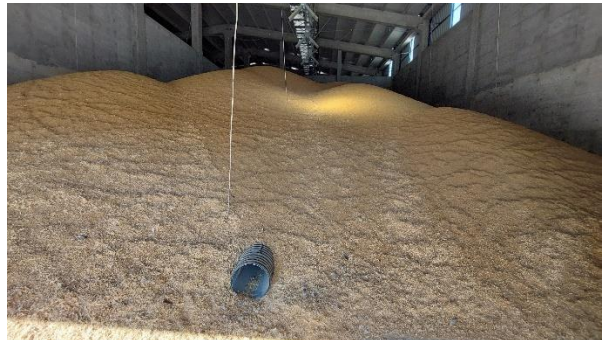
Şekil 4.27. Yatay betonarme hububat depolarında kullanılan havalandırma sistemlerine ait görüntüler
