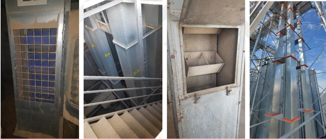
Ek Şekil 2. Tremilerden alınan ürünün elevatörlere yükseltilmesi
