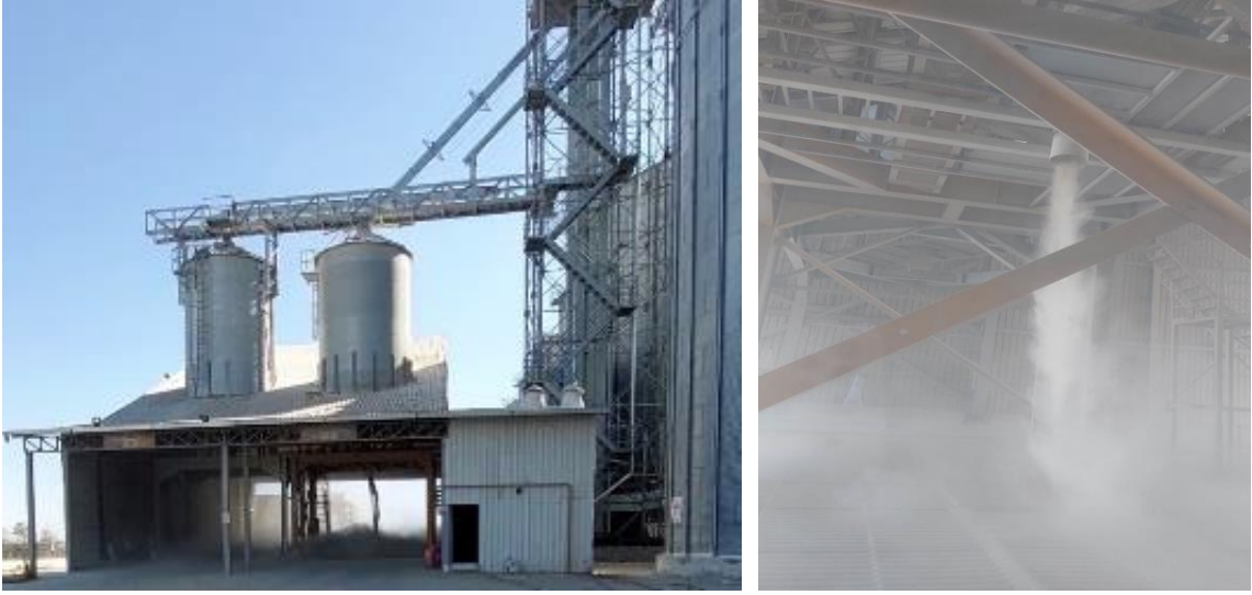
Şekil 4.28. Depo içerisinde ısınan ürünün soğutulması ve neminin azaltılması amacıyla ürünün depolardan tremiye ve tekrar depolara aktarılması
