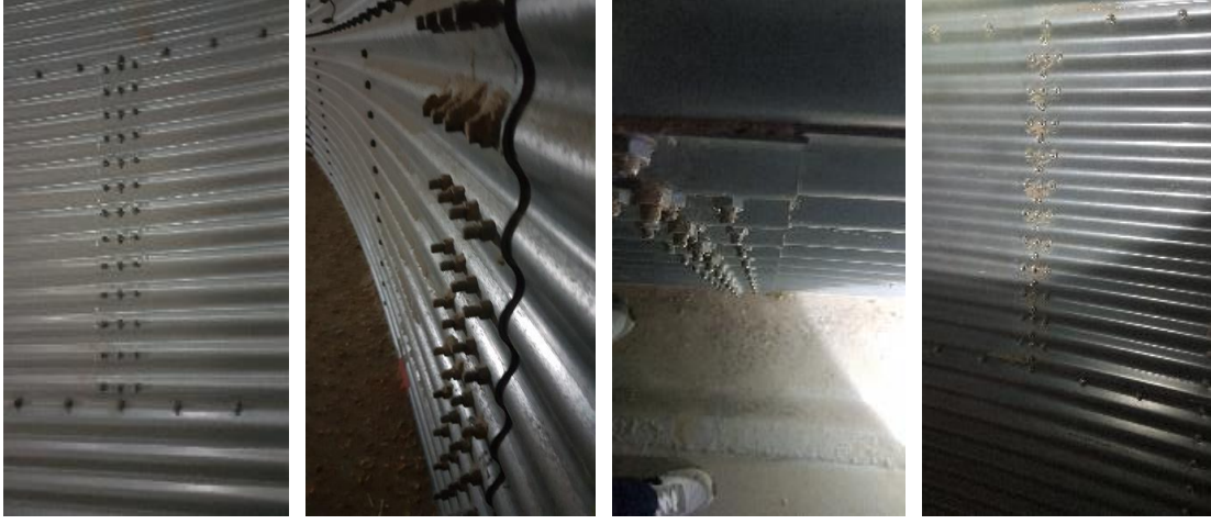
Ek Şekil 16. Çelik silolarda gövde saclarının cıvatayla birbirine bağlanması
