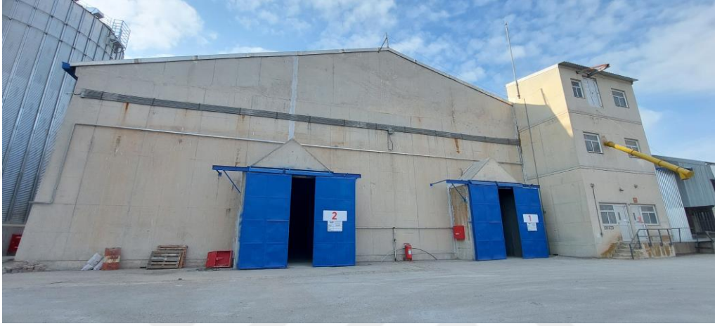
Şekil 3.3. Araştırmanın yürütüldüğü yatay betonarme depolara ait bir görüntü
