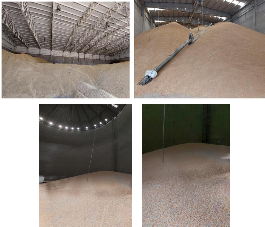
Şekil 4.39. Sıcaklık ölçüm halatlarının ürün içerisindeki görünümü
