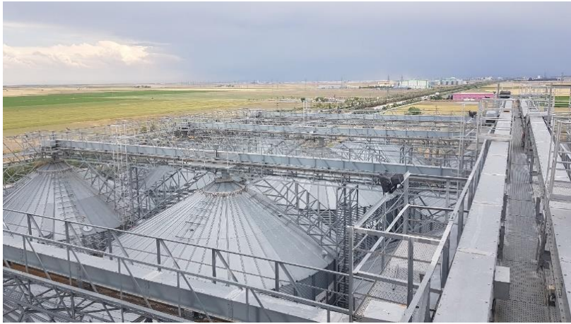
Ek Şekil 5. Elevatörle yükseltlen ürünlerin konveyörlerle silolara alınması
