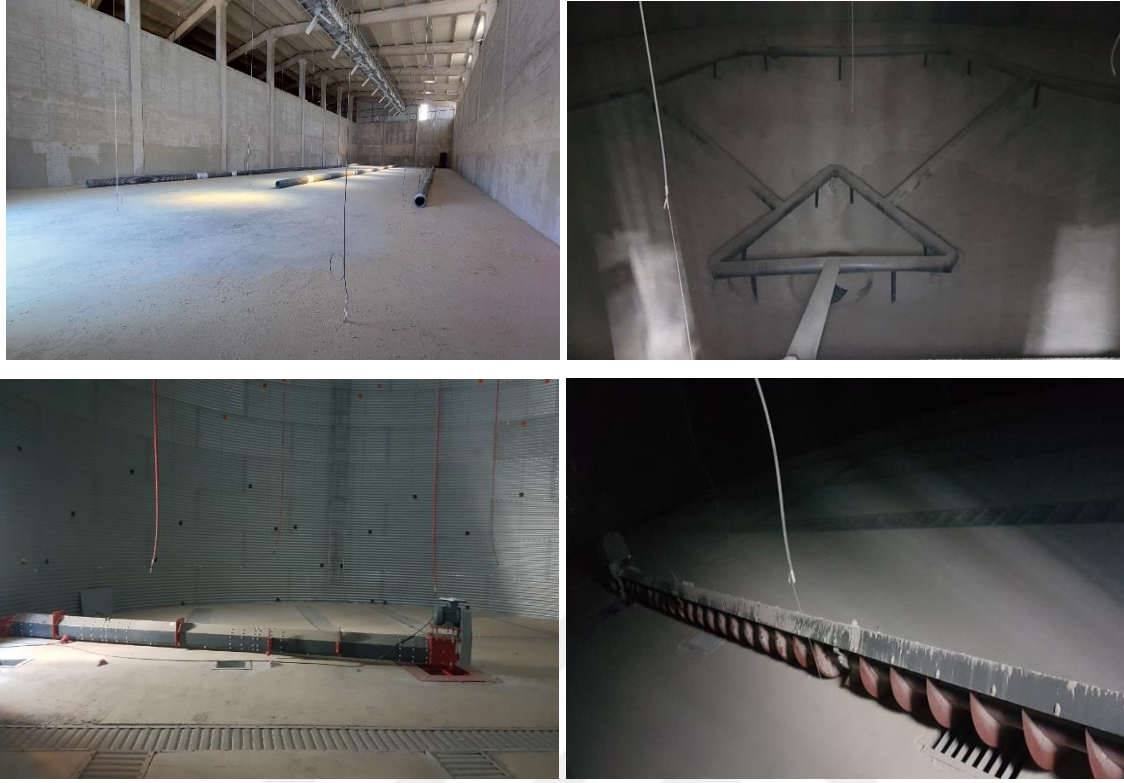
Şekil 4.40. Sıcaklık ölçüm halatlarının depo içerisinde yerleşim düzeni
