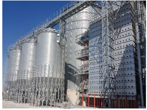
Şekil 4.12. Dikdörtgen kesitli kurutma tesisi
