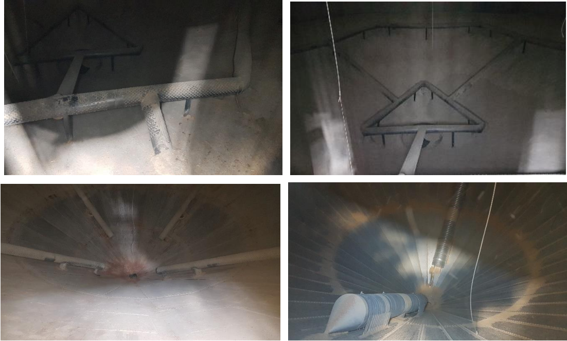
Ek Şekil 19. Konik tabanlı çelik silolarda kullanılan havalandırma sistemleri
