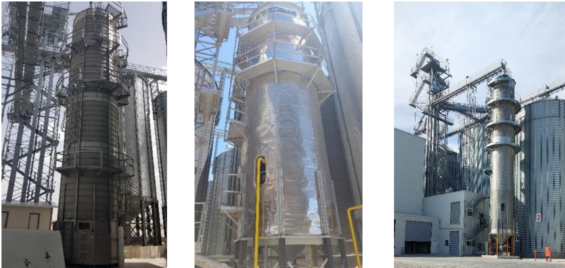
Şekil 4.11. Dairesel kesitli düşey kurutma tesisi
