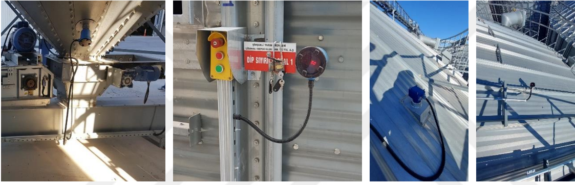
Ek Şekil 17. Silolarda doluluk sensörleri
