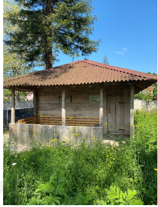
Şekil 3.60. Dağdıralı Köyü türbesinin doğu girişi
