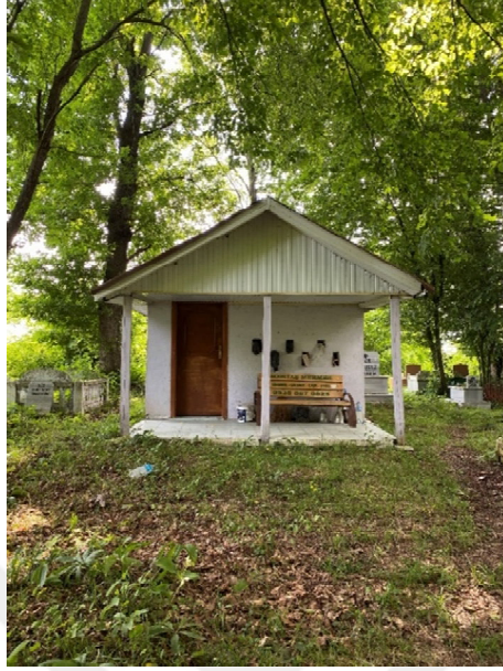
Şekil 3.164. İnebel Türbesi batı giriş cephesi
