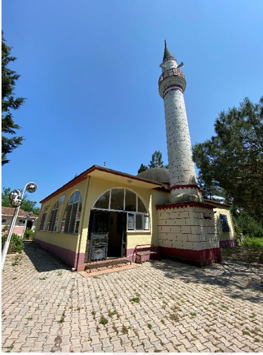
Şekil 3.116. Mescitli Köyü Camii
