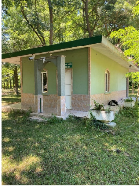
Şekil 3.129. Türbenin kuzeybatı cephesi
