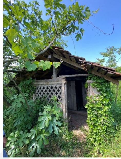
Şekil 3.78. Üfû Türbesi doğu giriş cephesi
