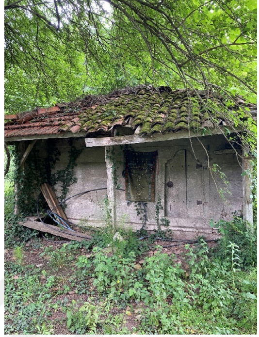
Şekil 3.40. Dalbahçe Türbesi doğu cephe
