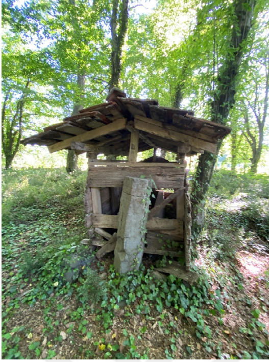
Şekil 3.70. Hacı Aliko Türbesi batı cephesi
