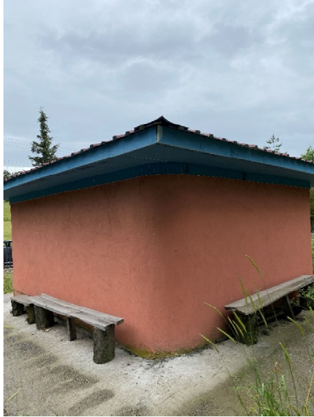
Şekil 3.133. Akalan Türbesi batı cephesi
