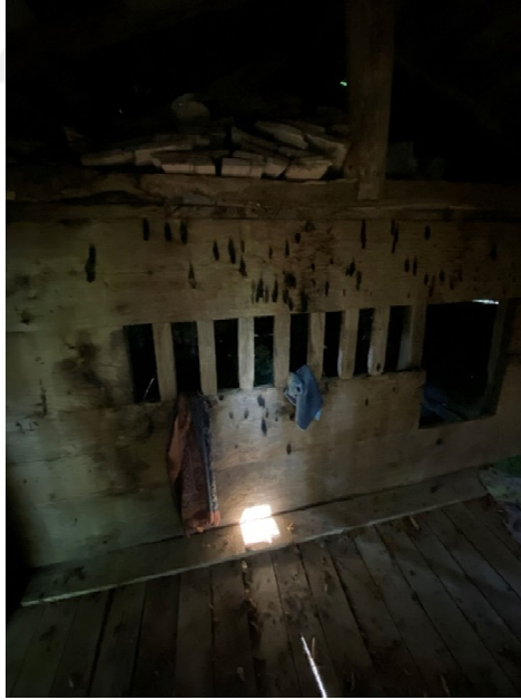
Şekil 3.65. Türbe içindeki ahşap bölme
