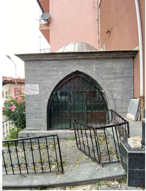
Şekil 3.103. Şeyh Hamza Türbesi kuzey cephe
