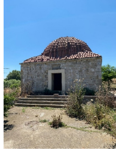
Şekil 3.12. Hızır Bey Türbe girişi güney cephesi
