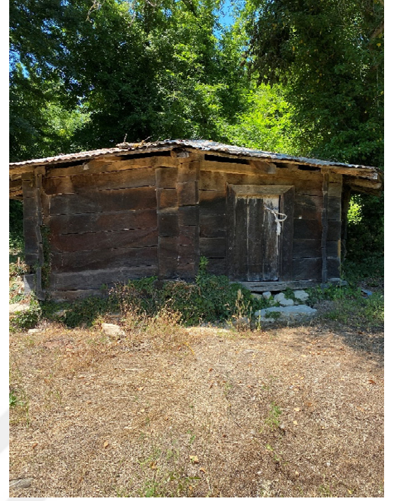
Şekil 3.29. Soğukçam Türbesi doğu cephesi
