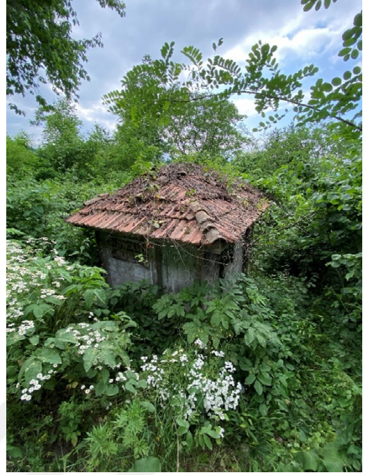
Şekil 3.52. Ahmet Dede Türbesi kuzey giriş
