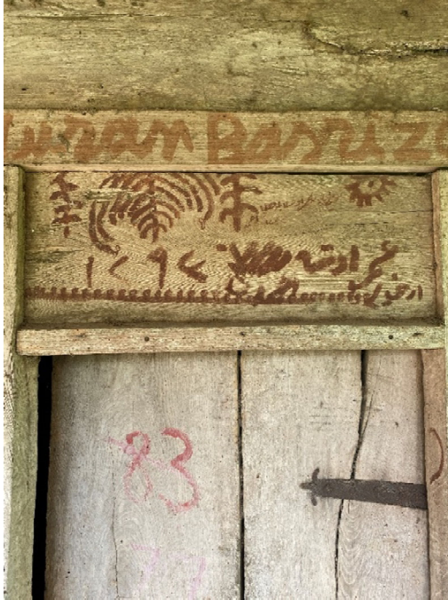
Şekil 3.61. Türbenin ahşap kapı sövesinden detay
