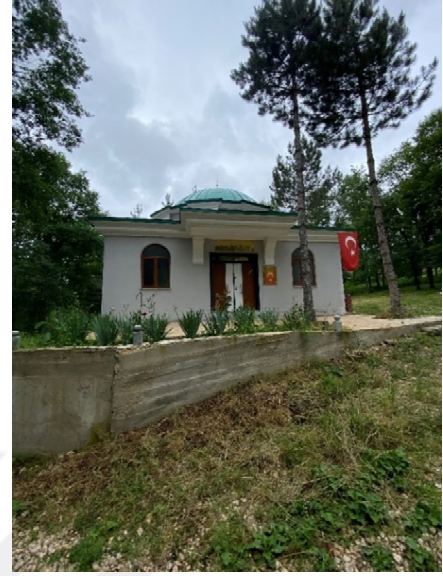
Şekil 3.113. Karaabdal Türbesi doğu cephesi
