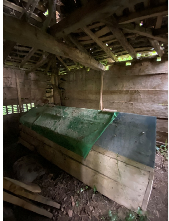
Şekil 3.42. İç mekan sandukanın görünümü
