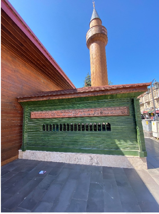
Şekil 3.74. Türbe güney cephe
