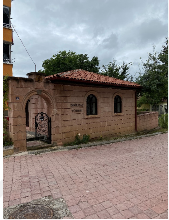
Şekil 3.183. Dikilitaş Türbesi batı cephesi
