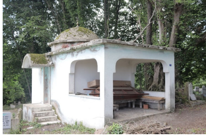
Şekil 3.120. Akçagün Şeyh Abdullah Türbesi kuzey batı cephesi
