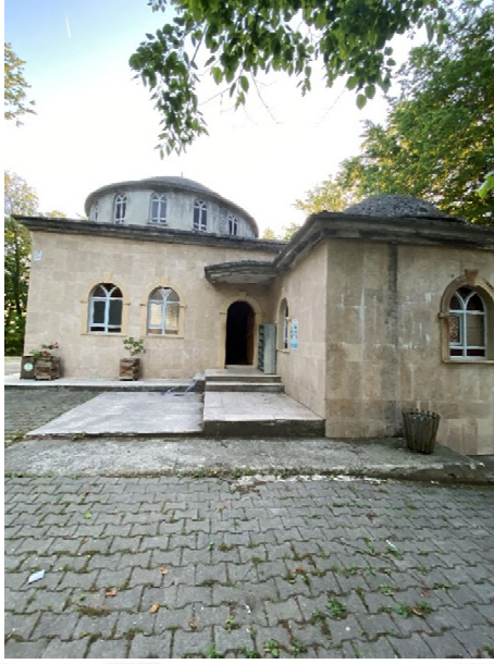
Şekil 3.100. Türbenin Kuzeydoğu cephesi
