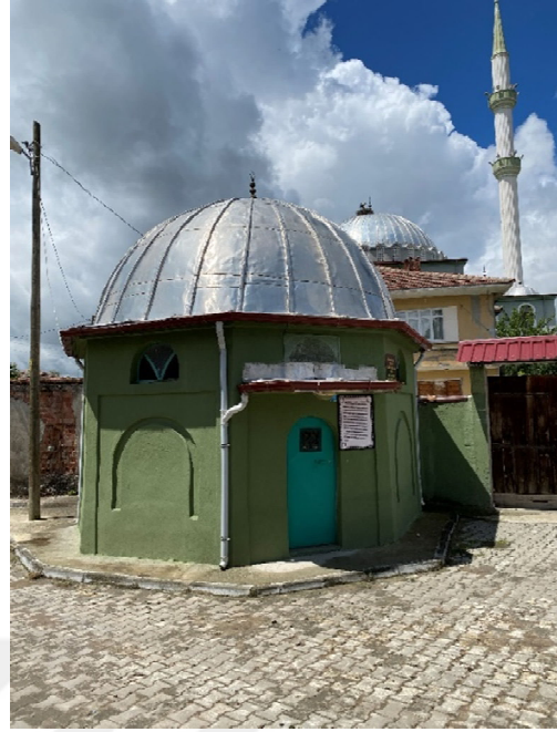
Şekil 3.154. Şeyh Savcı Türbesi kuzey cephesi
