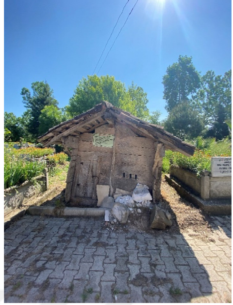
Şekil 3.56. Şakircuk Türbesi batı giriş cephesi
