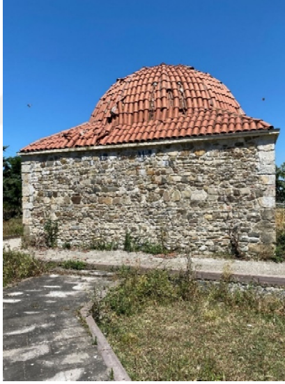
Şekil 3.13. Hızır Bey Türbesi batı cephesi
