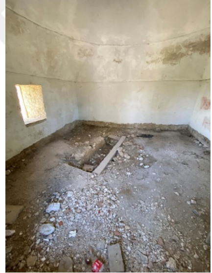
Şekil 3.14. Türbe iç mekan
