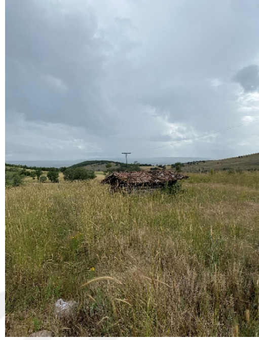
Şekil 3.44. Havza Sarılık Türbesi uzaktan görünümü
