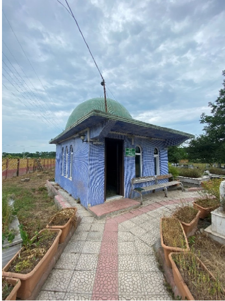
Şekil 3.148. Türbenin güney doğu cephesi
