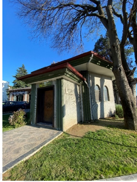
Şekil 3.136. Türbenin kuzeybatı cephesi
