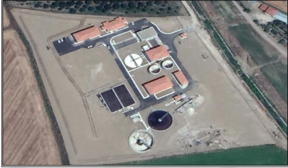
Şekil 4.9 Atık Su Arıtma Tesisi görünümü
