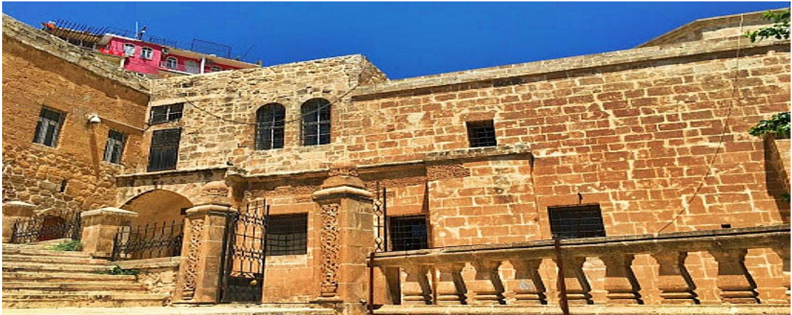
Şekil 16. Mardin Hatuniye (Sitti Razviyye) Medresesi güney cephesinden genel görünüm. 238
