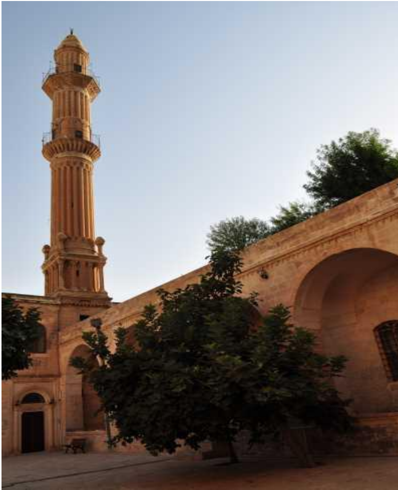
Şekil 13. Şehidiye Cami ve Medresesi ile minare yapısının görünümü. 218
