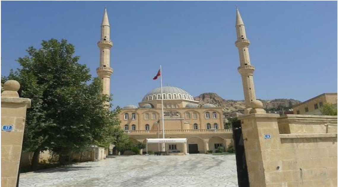
Şekil 18. Mardin İli Kabala Mahallesinde bulunan Şakir Nuhoğlu Yatılı Erkek Kur'ân Kursu/Medresesi/Külliyesi'nin güney cephesinden genel bir görünümü.
