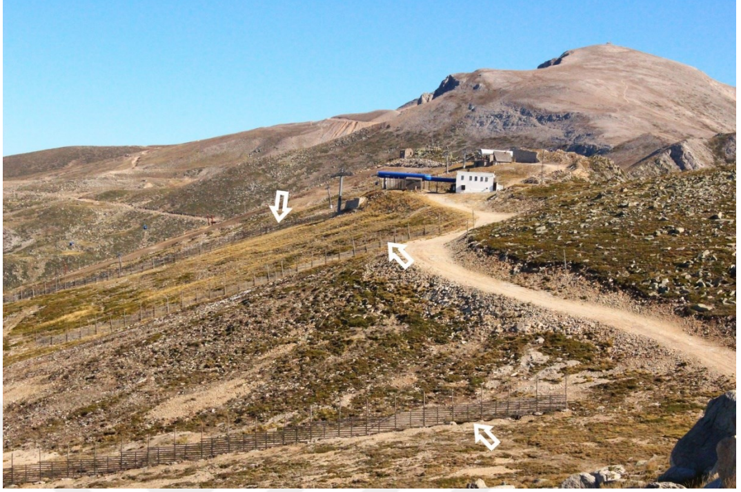
Şekil 4.8. Şahinkaya tepesinde yağın karın sürüklemesini engellemek için tahtadan yapılan rüzgar kırıcılar.
