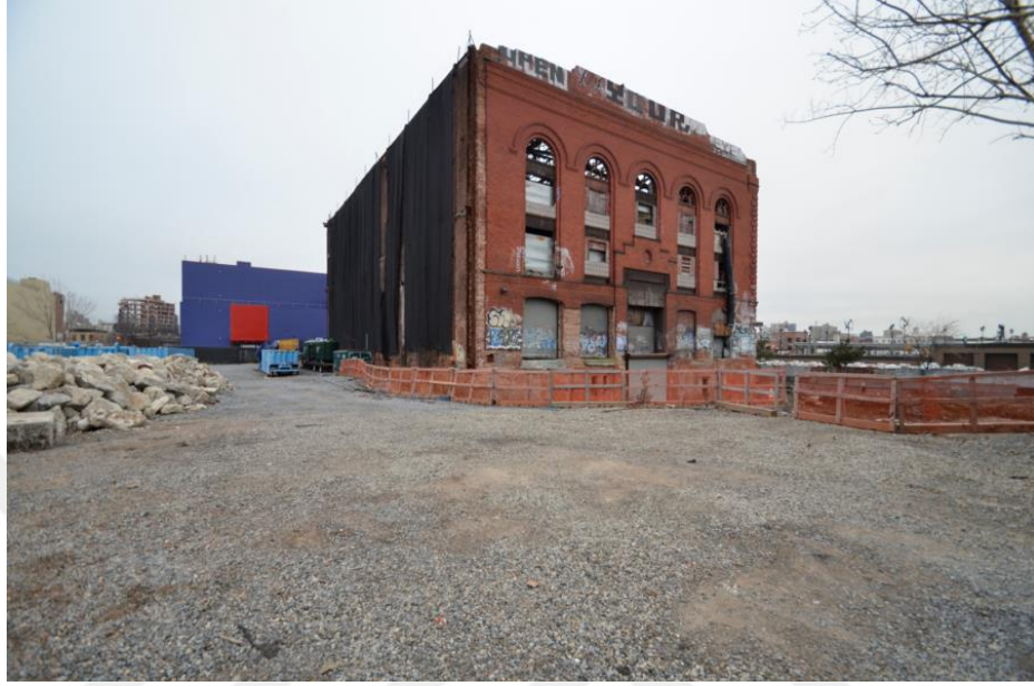
Şekil 60.Powerhouse Sanat Üretim Merkezi Yeniden İşlevlendirme Öncesi Türbin Dairesi
