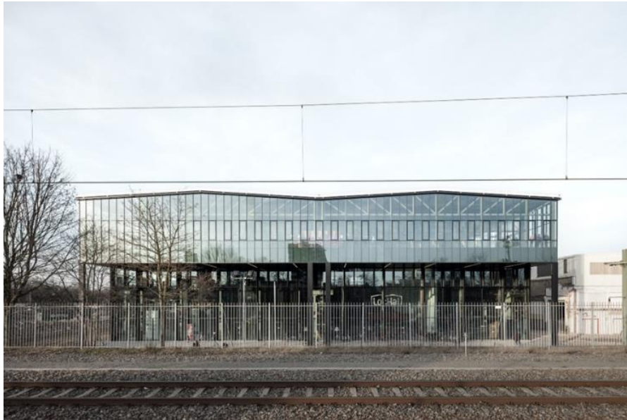
Şekil 13. LocHal Kütüphanesi, Güney Cephesi. (Kaynak: Civic Architects, 2022)
