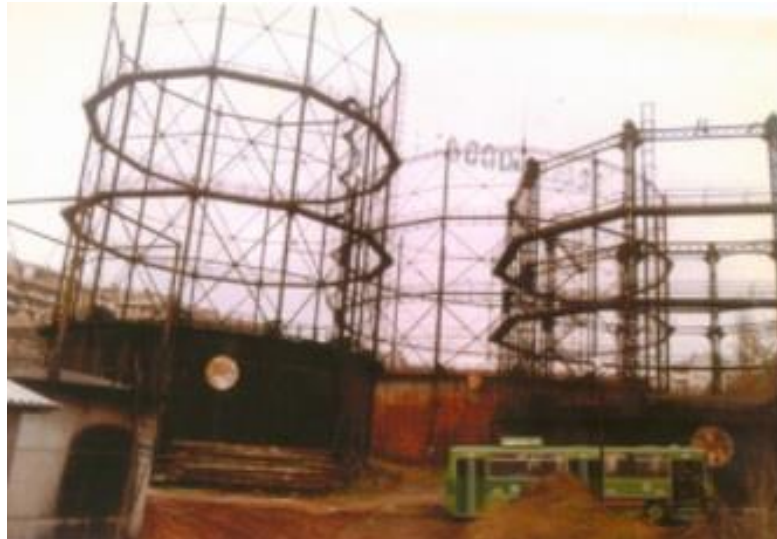
Şekil 6. Hasanpaşa Gazhanesi Kapatıldıktan Hemen Sonra (1993)
