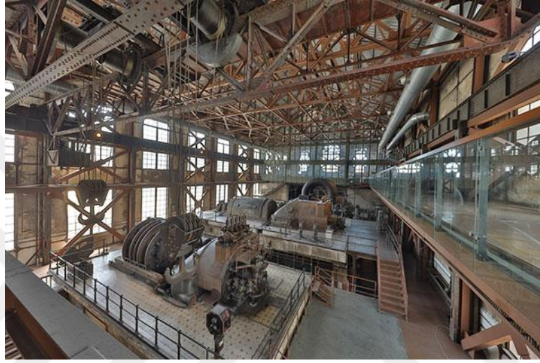
Şekil 113.Santral İstanbul Enerji Müzesi Korunan Ekipmanlar (Kaynak: https://www.santralistanbul.org/tr , 2023)
