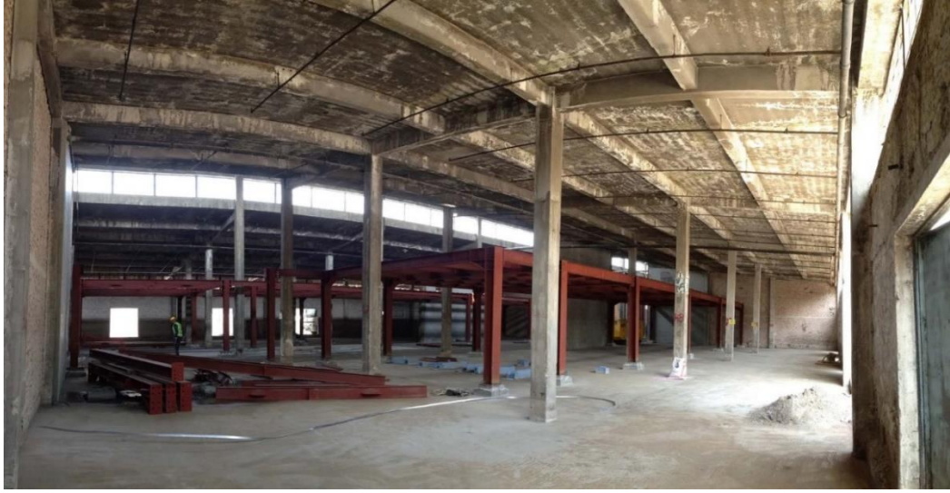
Şekil 69. Abdullah Gül Üniversitesi Çelik Asma Kat Yapım Aşaması (Kaynak: https://www.arkiv.com.tr , 2023)
