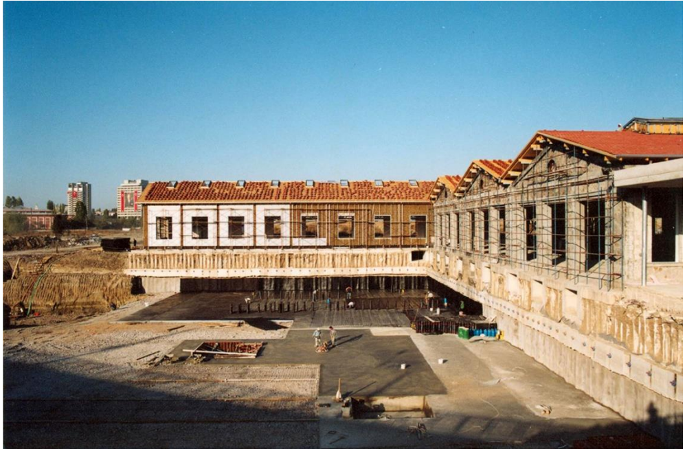
Şekil 95.Cer Modern İnşaat Süreci (Kaynak: https://www.santiye.com.tr , 2023)
