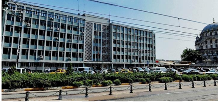
Şekil 100.İstanbul Karaköy 5 No’lu Antrepo Eski Cephesi (Kaynak: https://www.arkitera.com/ , 2023)
