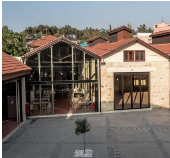
Şekil 89.Tarsus Çırçır Fabrikası Yenileme Sonrası Dış Cephe Çelik ve Çatı Uygulaması (Kaynak: https://www.naturadergi.com , 2023)
