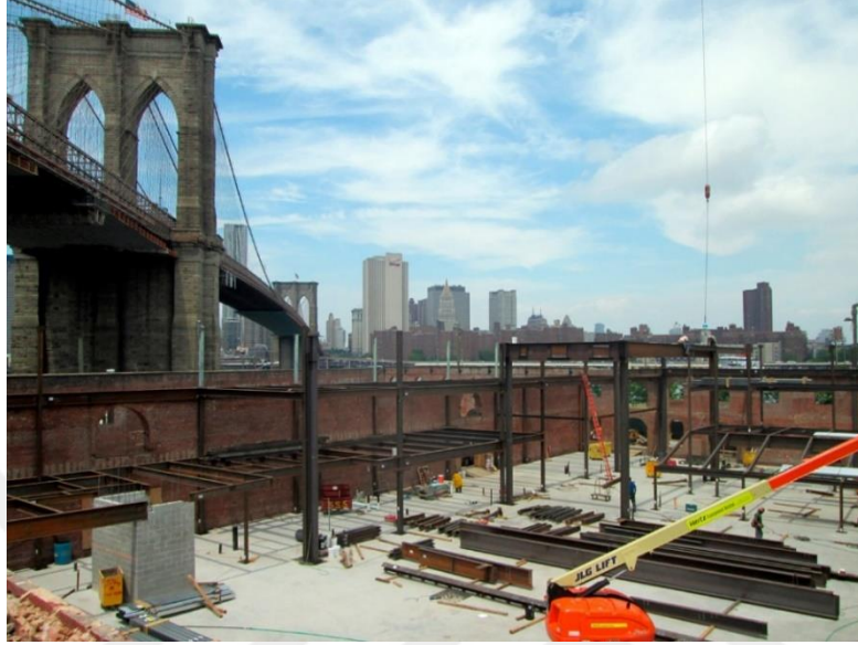
Şekil 52.Yeniden İşlevlendirme Çelik Taşıyıcı Sistem Uygulaması (Kaynak: https://www.archdaily.com/ , 2023)
