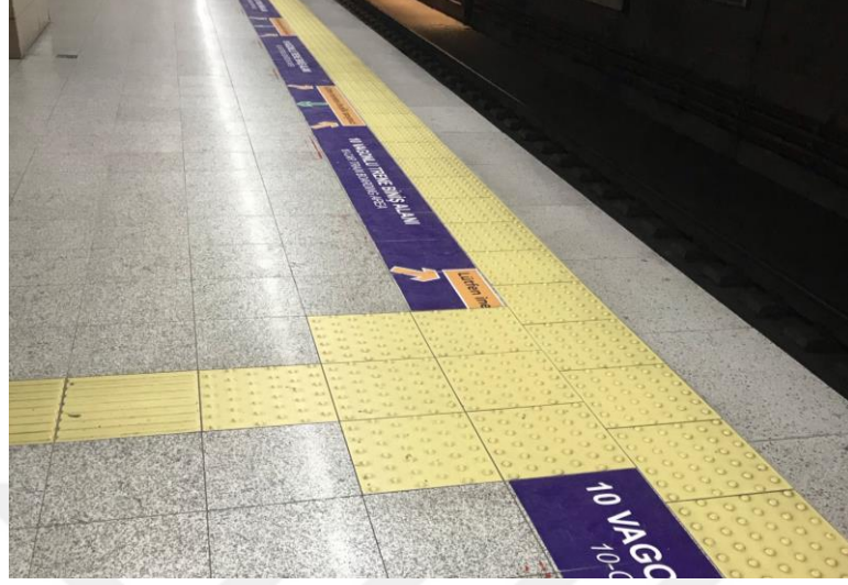
Şekil 30: Raylı sistem peronu şaşırtmalı dizilimli uyarıcı yüzey uygulamasına İstanbul Yenikapı Marmaray İstasyonundan bir örnek (Kılınçoğlu, 2023).
