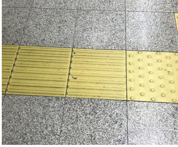
Şekil 33: Karolar ile düzenlenmiş hissedilebilir yüzeyler uygulamasına İstanbul Gayrettepe Metro İstasyonundan bir örnek (Kılınçoğlu, 2023).
