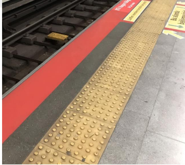
Şekil 31: Raylı sistem peronu şaşırtmalı dizilimli olmayan uyarıcı yüzey uygulamasına İstanbul Gayrettepe Metro İstasyonundan bir örnek (Kılınçoğlu, 2023).
