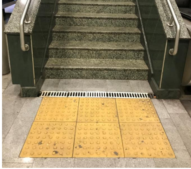
Şekil 19: Merdiven başlangıcında hissedilebilir yüzeylere ilişkin, İstanbul Gayrettepe Metro İstasyonundan bir örnek (Kılınçoğlu, 2023).
