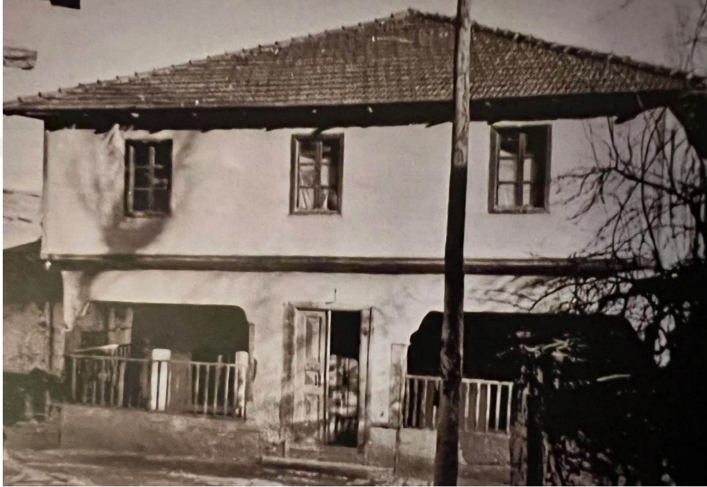
Şekil 110. Kütük Camii kuzey cephesi, 1968
