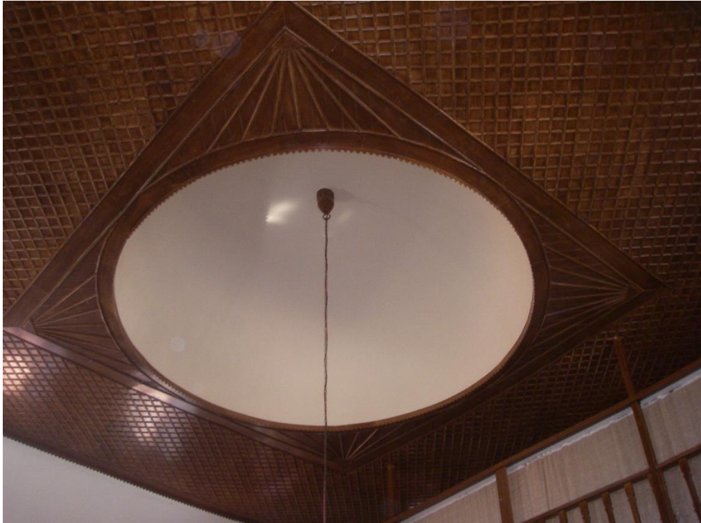
Şekil 122. Onarım sonrası kubbe görünümü, 2005
