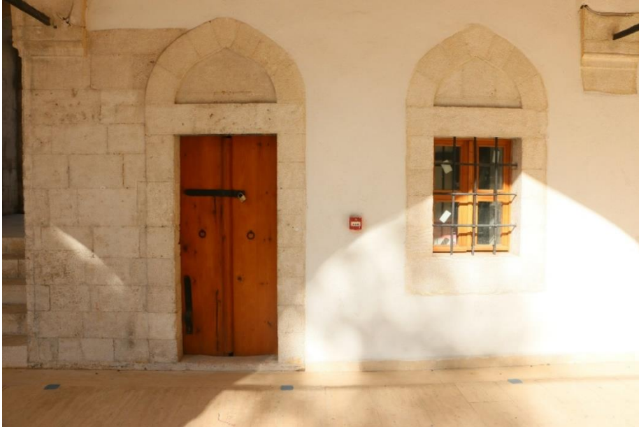
Şekil 68. Hücre odalarının sivri kemer alınlıklı çift kanatlı ahşap kapı ve penceresi.
