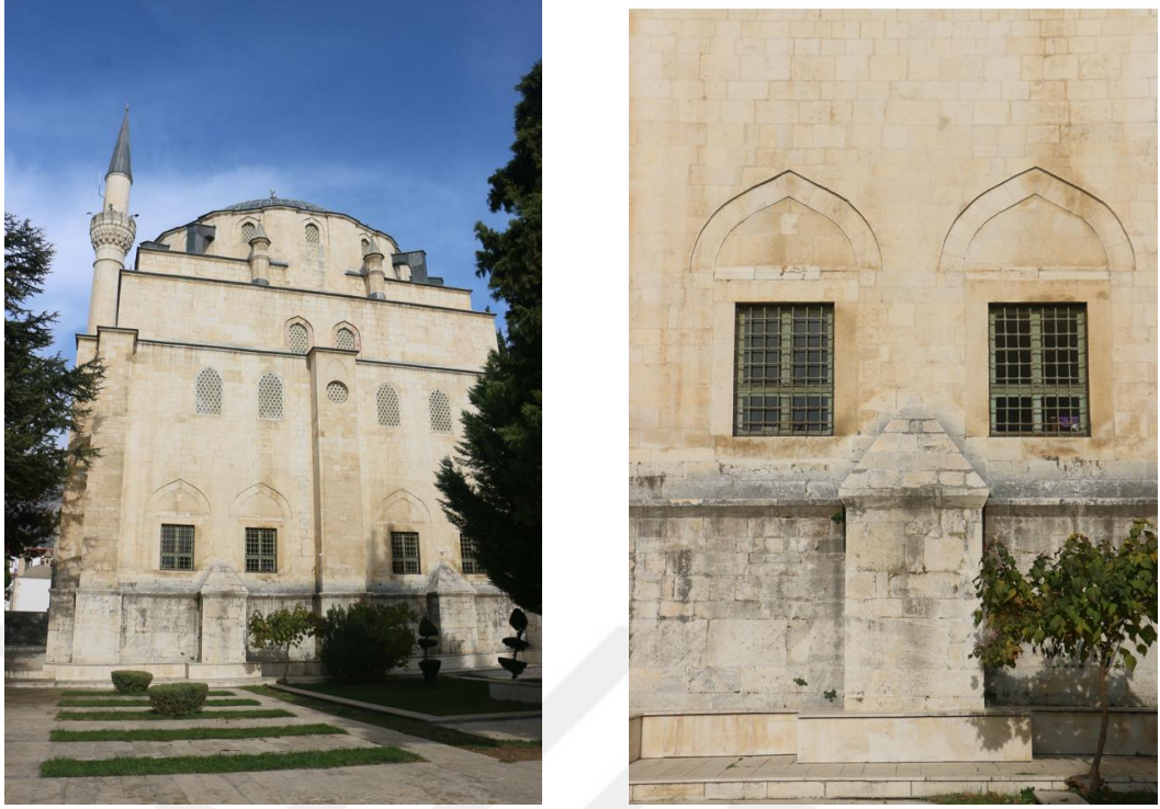
Şekil 33. a; b) Ömer Paşa Camii güney cephesi
