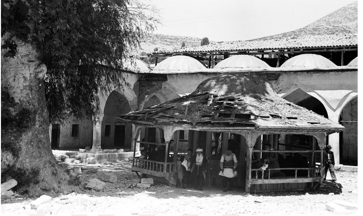
Şekil 56. Ömer Paşa Camii Şadırvanı, 1938
