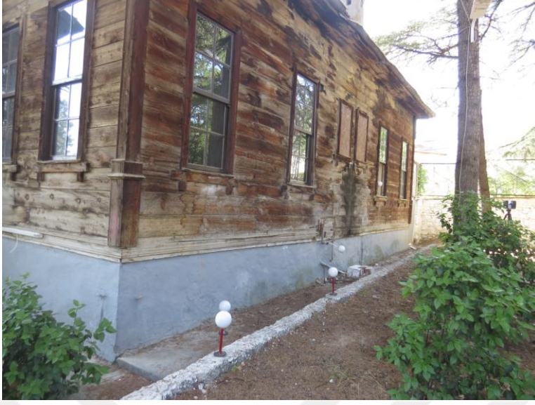
Şekil 163. Askerlik lojmanı kuzey cephesi
