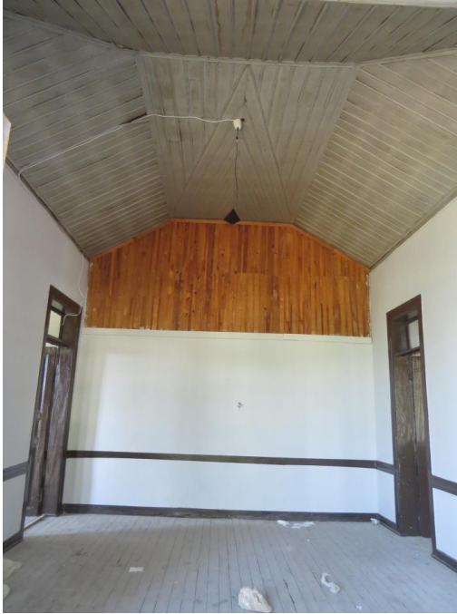
Şekil 164. Zemin katta bulunan iç sofaya örülen ahşap duvar
