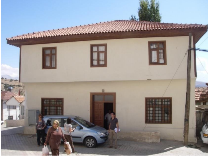
Şekil 119. Kütük Camii onarım sonrası kuzey cephe, 2005
