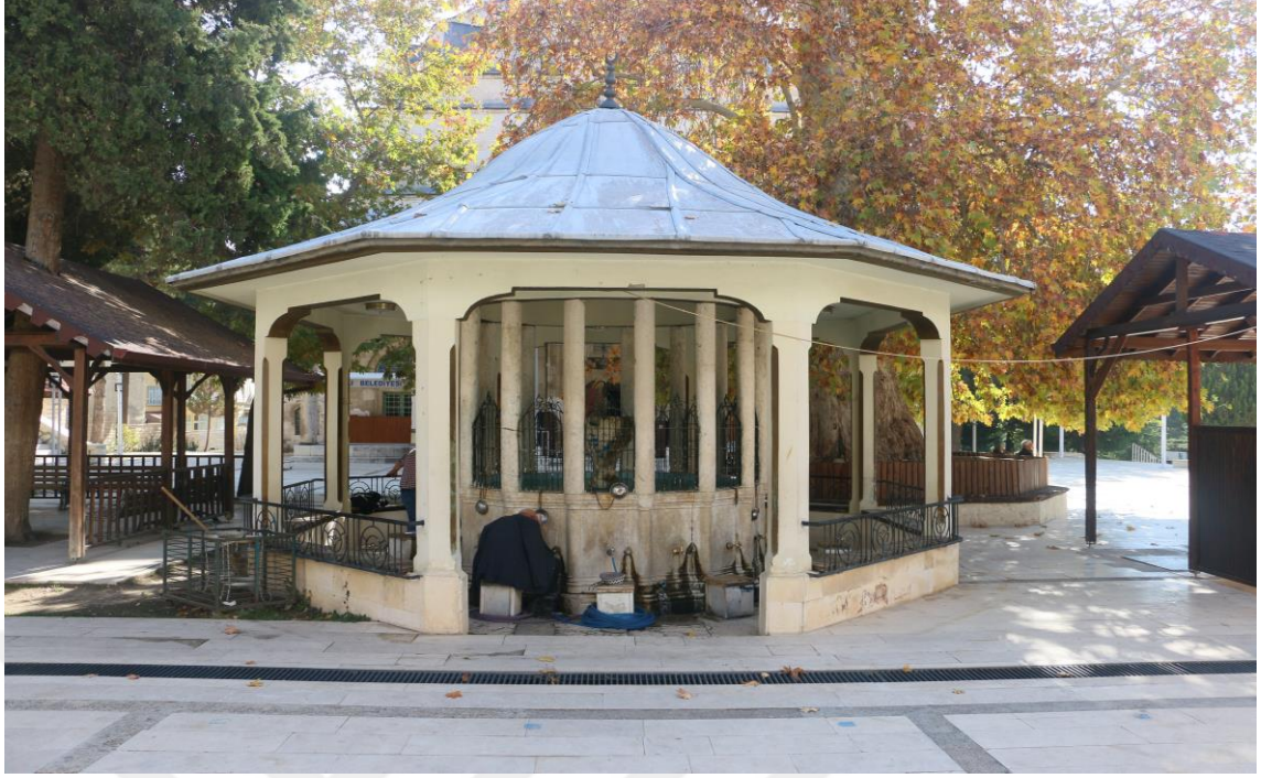
Şekil 55. Ömer Paşa Camii Şadırvanı
