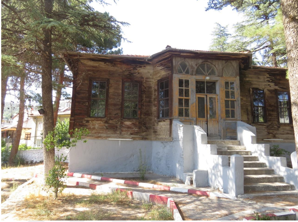
Şekil 160. Askerlik lojmanı doğu cephesi
