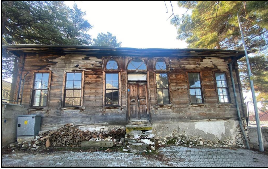
Şekil 167. Batı cephesinde meydana gelen bozulmalar; ahşap kaplamada renk değişimi, sıvalarda dökülme, taşlarda aşınma ve malzeme kaybı, bitkilenme, yosunlanma
