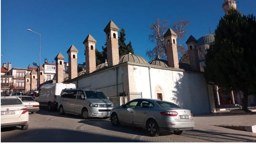
Şekil 71. Ömer Paşa Medresesi Batı Cephesi
