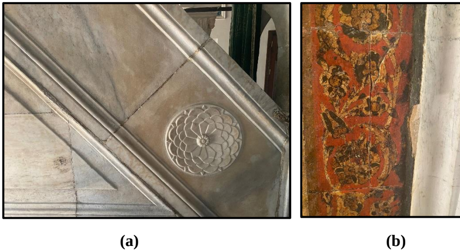
Şekil 51. a) Minberin mermerlerinin birleşim yerlerinde kullanılan harçlarda aşınma; b) Mihrap profilinde meydana gelen ayrılma ve kaleminde kirlenme
