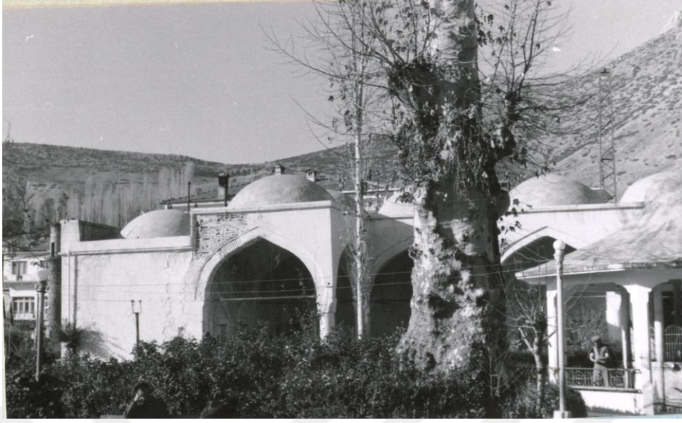
Şekil 75. Ömer Paşa Medresesi Güney Cephe, 1968
