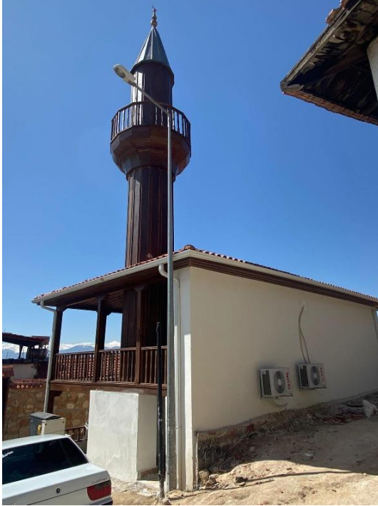
Şekil 88. Toklular Camii kuzey cephe
