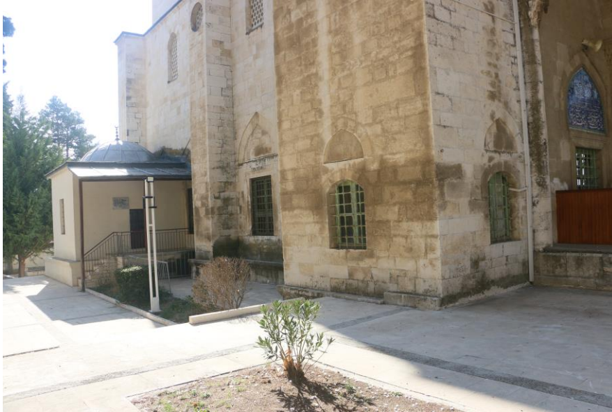
Şekil 52. Ömer Paşa Camii'nin doğu cephesi ve Ahi Baba Türbesi
