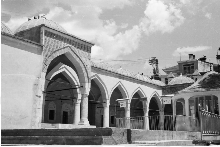
Şekil 77. Ömer Paşa Medresesi güney cephe, 1969
