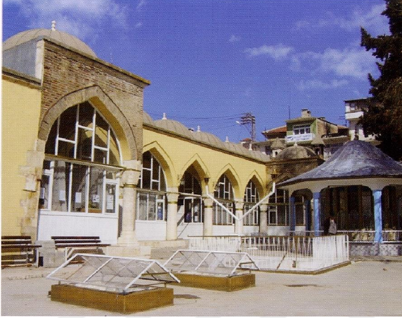
Şekil 79. Ömer Paşa Medresesi güney cephe, 2005
