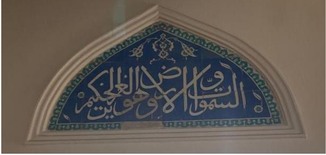
Şekil 22. Doğu iç duvarında sağdan beşinci pano (D5).
