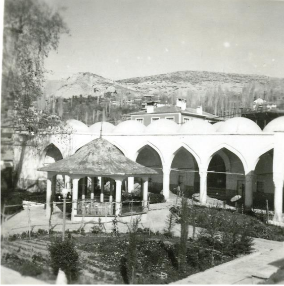
Şekil 57. Ömer Paşa Camii Şadırvanı, 1968
