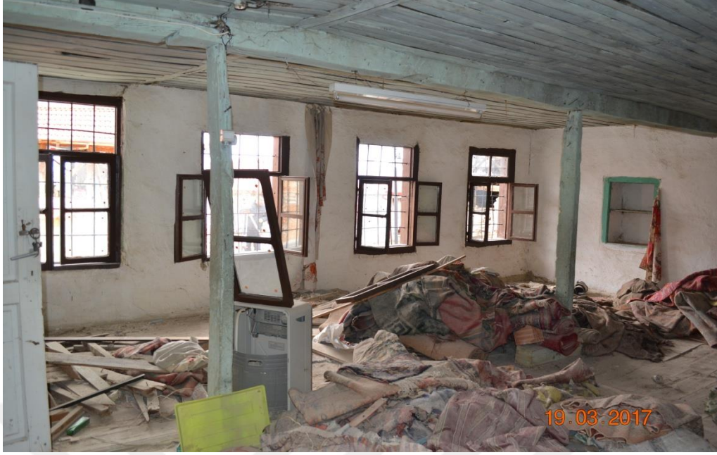
Şekil 97. Zemin katta bulunan ibadet mekanı, 2017
