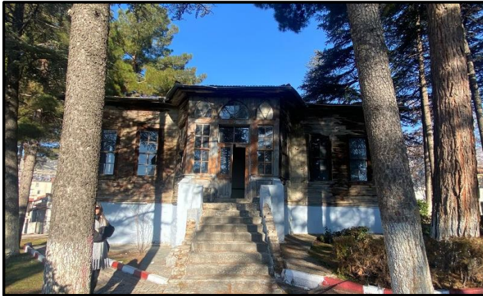
Şekil 165. Doğu cephesinin ahşaplarında meydana gelen renk değişimi
