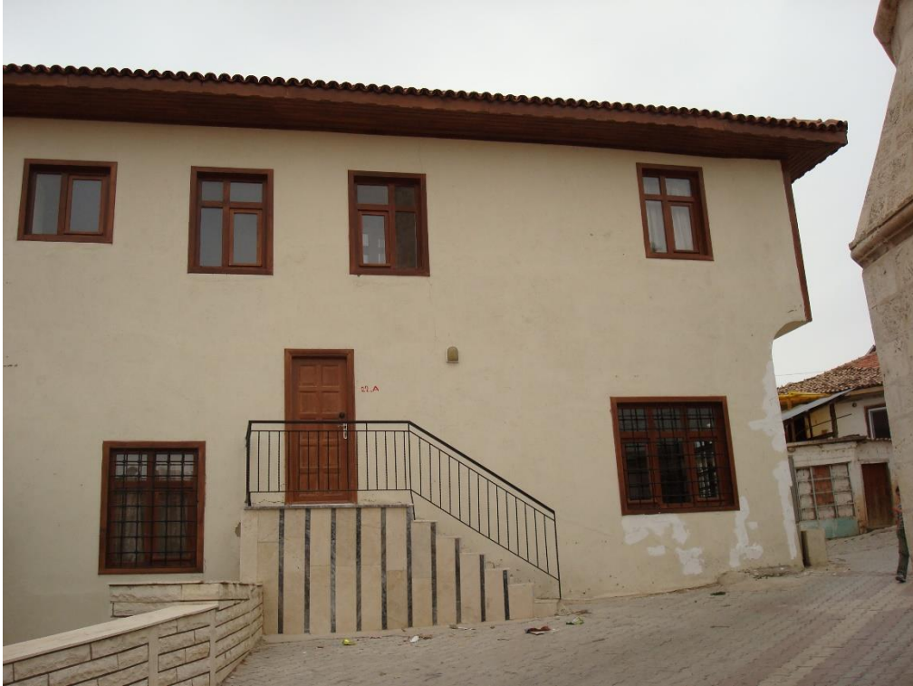
Şekil 120. Onarım sonrası doğu cephe, 2005
