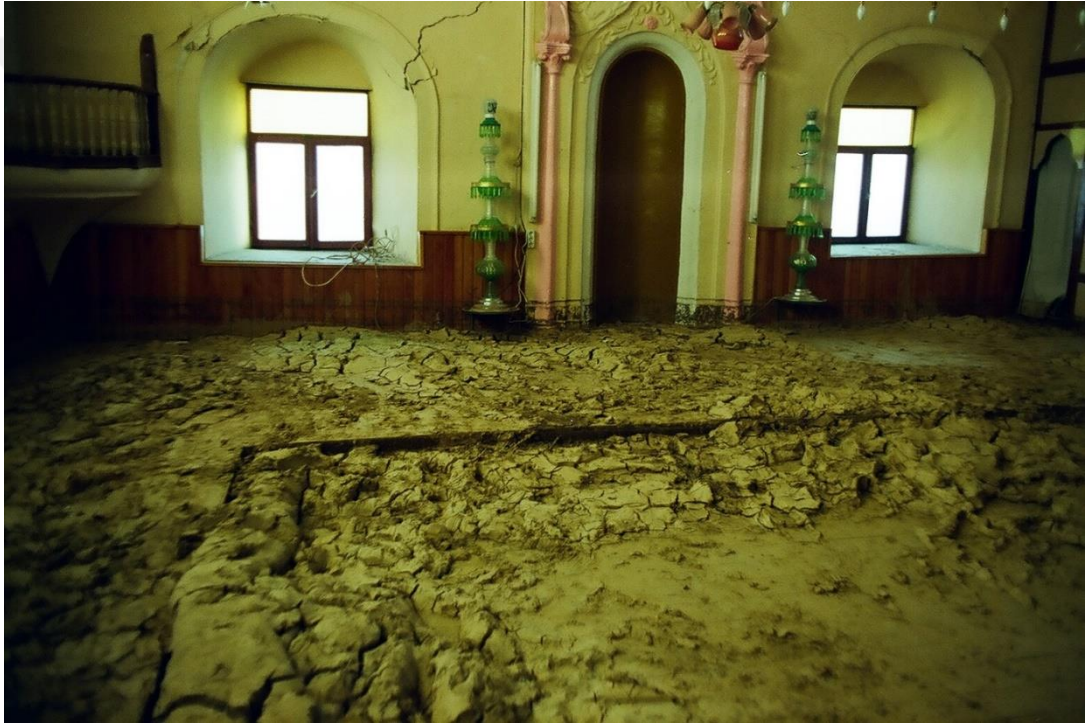
Şekil 116. Sel felaketinden sonra zeminde meydana gelen hasar, 2002
