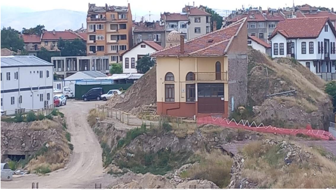
Şekil-9 Şükran Mahallesi Kentsel Dönüşüm Alanından Bir Görünüm (Havva Hepgüler 11.07.2023).
