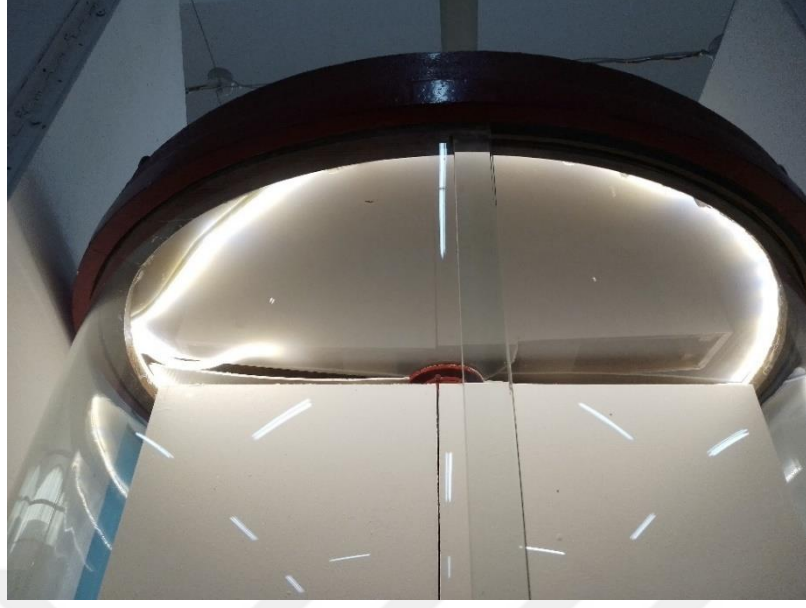
Resim 4.19. Cam vitrin ierisine zensizce yerleřtirilen sarı led aydınlatma (Bostancı,R.G., 2023).
