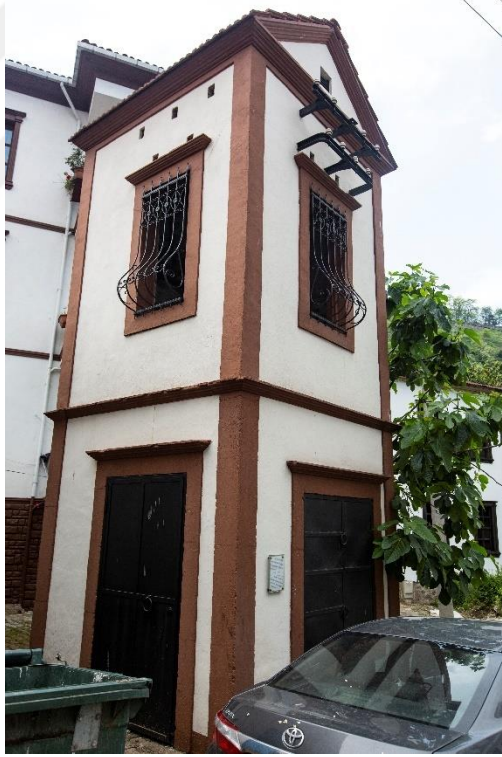
Şekil 4.10: Tarihi Trafo Yapısı
