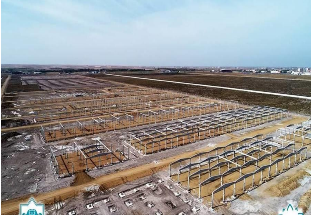
Resim 5.2: Yeni Küçük Sanayi Sitesi Projesi Uygulamasından Görüntü (2018 Ekim)
