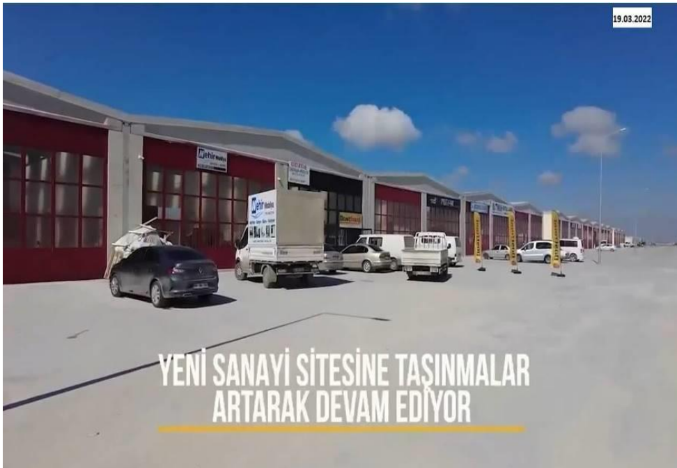
Resim 5.4: Yeni Küçük Sanayi Sitesi Projesi Uygulamasından Görüntü (2020 Nisan)
