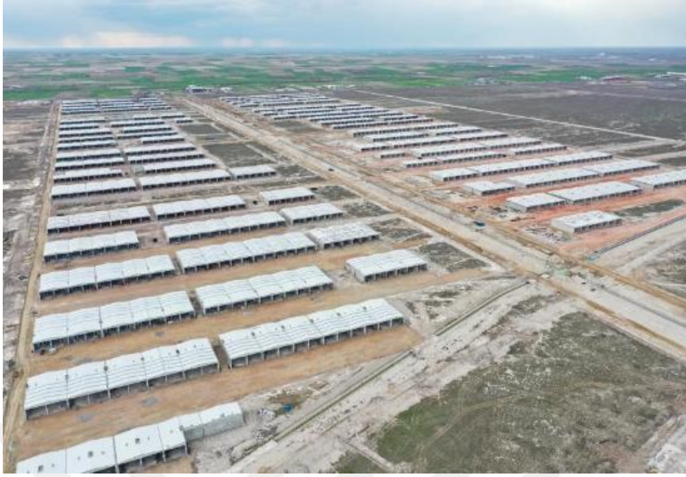
Resim 5.3: Yeni Küçük Sanayi Sitesi Projesi Uygulamasından Görüntü (2020 Nisan)
