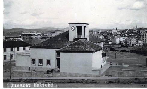
Cadde Cephesi (Alpagut, 2012)
