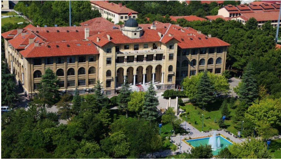
Fotoğraf 3.98. Gazi Üniversitesi Rektörlük Binası Görseli 565
