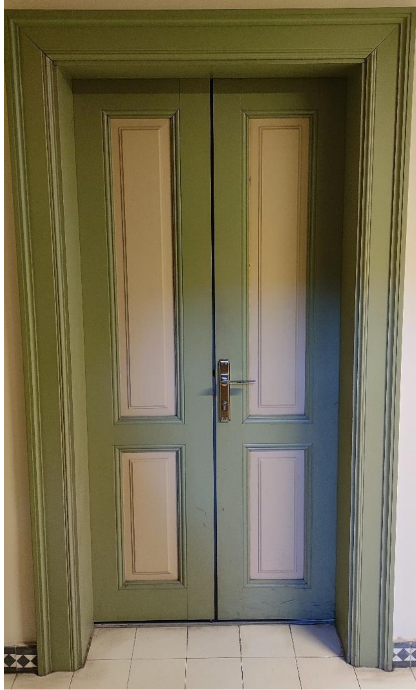
Görsel 62. Köşkün zemin katında bulunan kapının restorasyon sonrasına ait görseli (Fotoğraf: Sadık Çağrı Bildiş, 2022).
