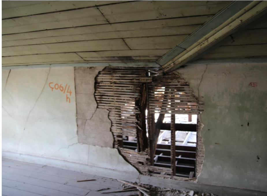
Görsel 98. Çatı katı duvarlarının yenileme çalışmasından önce çekilmiş görseli (Aralık 2013 Restorasyon Raporu).
