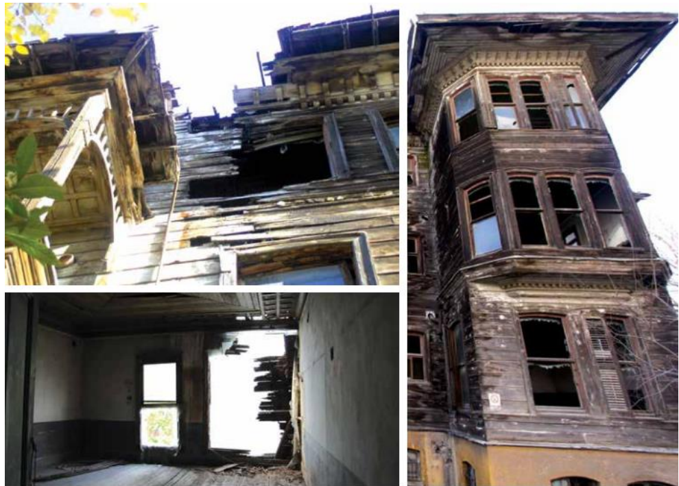
Görsel 38. Atıl kalan Ziyaeddin Efendi Köşkü deforme olmuş yüzeyleri (Anadol, 2014, s.75).
