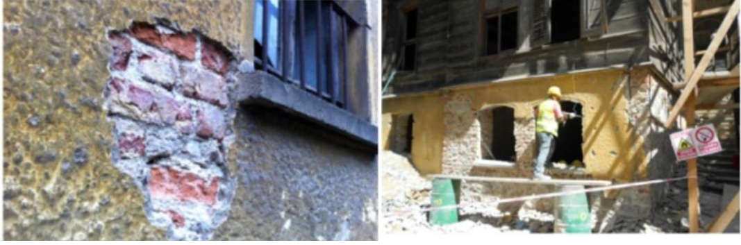
Görsel 87. Yenileme çalışması öncesi zemin kat duvar uygulamalarının görseli (Aralık 2013 Restorasyon Raporu).
