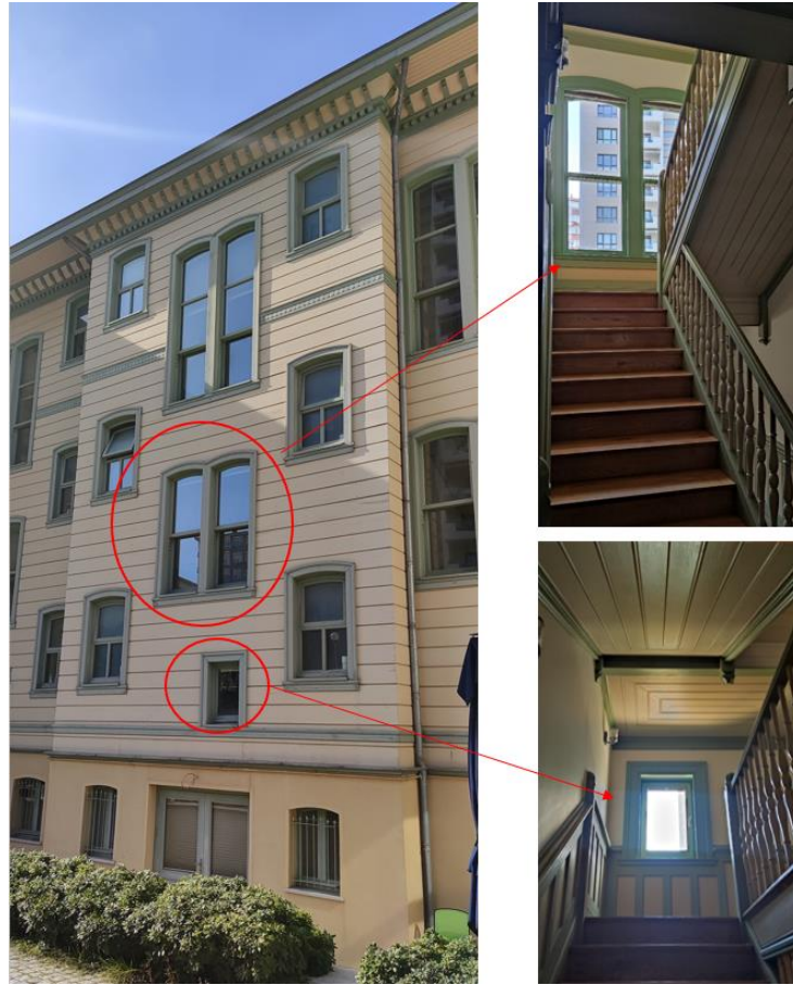
Görsel 72. M3 merdivenlerini aydınlatan pencereler ve iç görünümü (Fotoğraf: Sadık Çağrı Bildiş, 2022).
