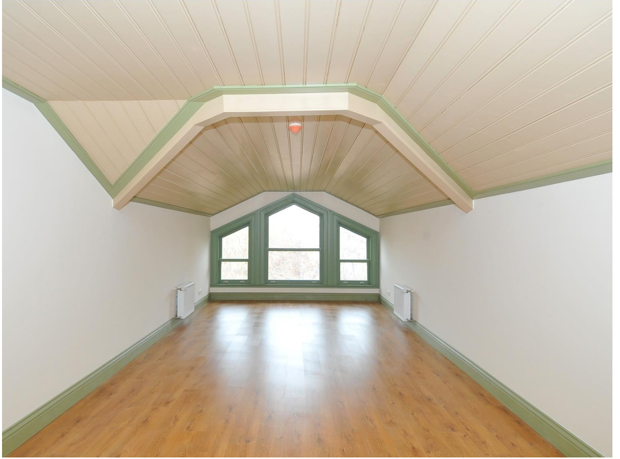
Görsel 99. Çatı katı duvarlarının yenileme çalışması sonrası görseli ((Aralık 2013 Restorasyon Raporu).
