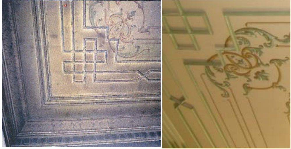
Görsel 113. Köşkte yer alan kalem işi bezemeli tavanların restorasyon öncesi ve sonrası görselleri (Yapı Merkezi Arşivi).
