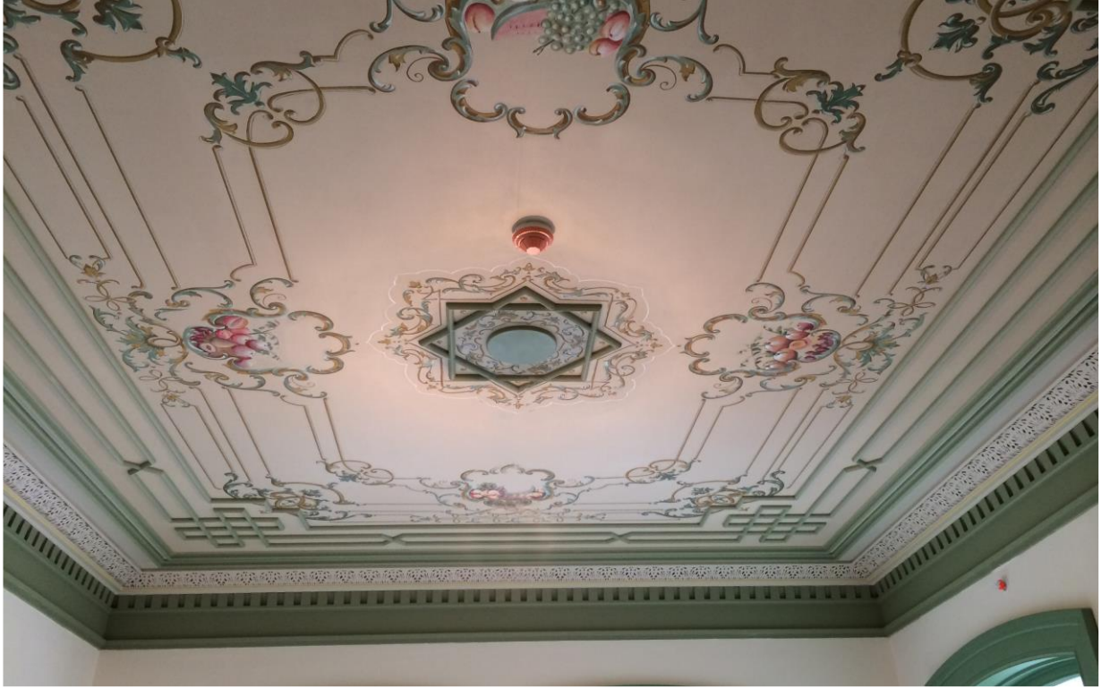
Görsel 110. Köşkün birinci kat Umut Sokak girişinde kalan arka odanın tavan işleminin görseli (Yapı Merkezi Arşivi).
