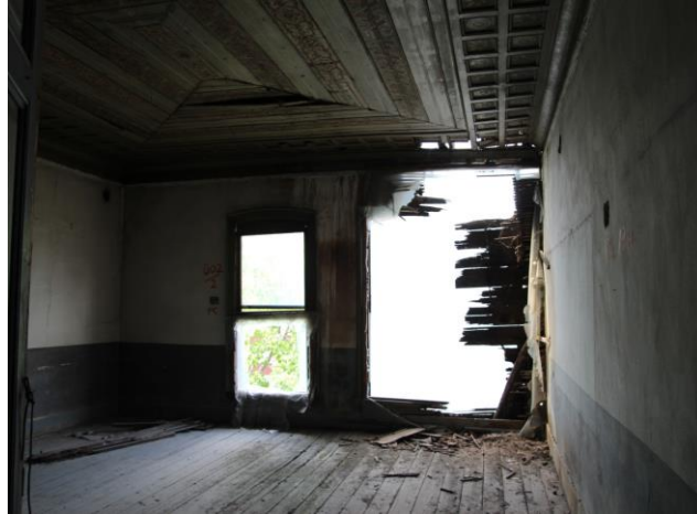
Görsel 96. Yenileme çalışmasına ait üçüncü kat sofanın Ata Sokak tarafında kalan oda görseli (Aralık 2013 Restorasyon Raporu).
