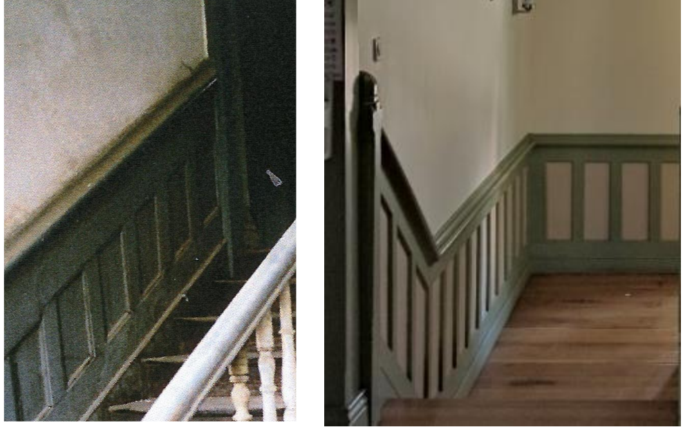
Görsel 77. Merdiven kovalarında kullanılan ahşap duvar kaplamalarının restorasyon öncesi sol görsel (Yapı Merkezi Arşivi) ve restorasyon sonrası sağ görseli (Fotoğraf: Sadık Çağrı Bildiş, 2022).
