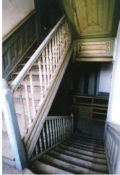
Grsel 75. M3 merdivenlerinin restorasyon ncesi grnm (Yapı Merkezi Arřivi).
