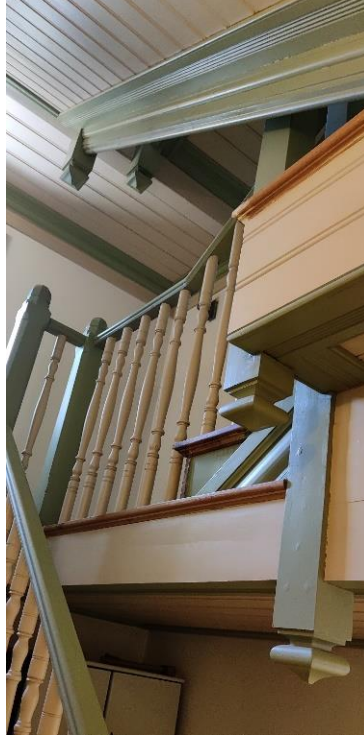
Görsel 73. M3 merdivenlerinin görünümü (Fotoğraf: Sadık Çağrı Bildiş, 2022).
