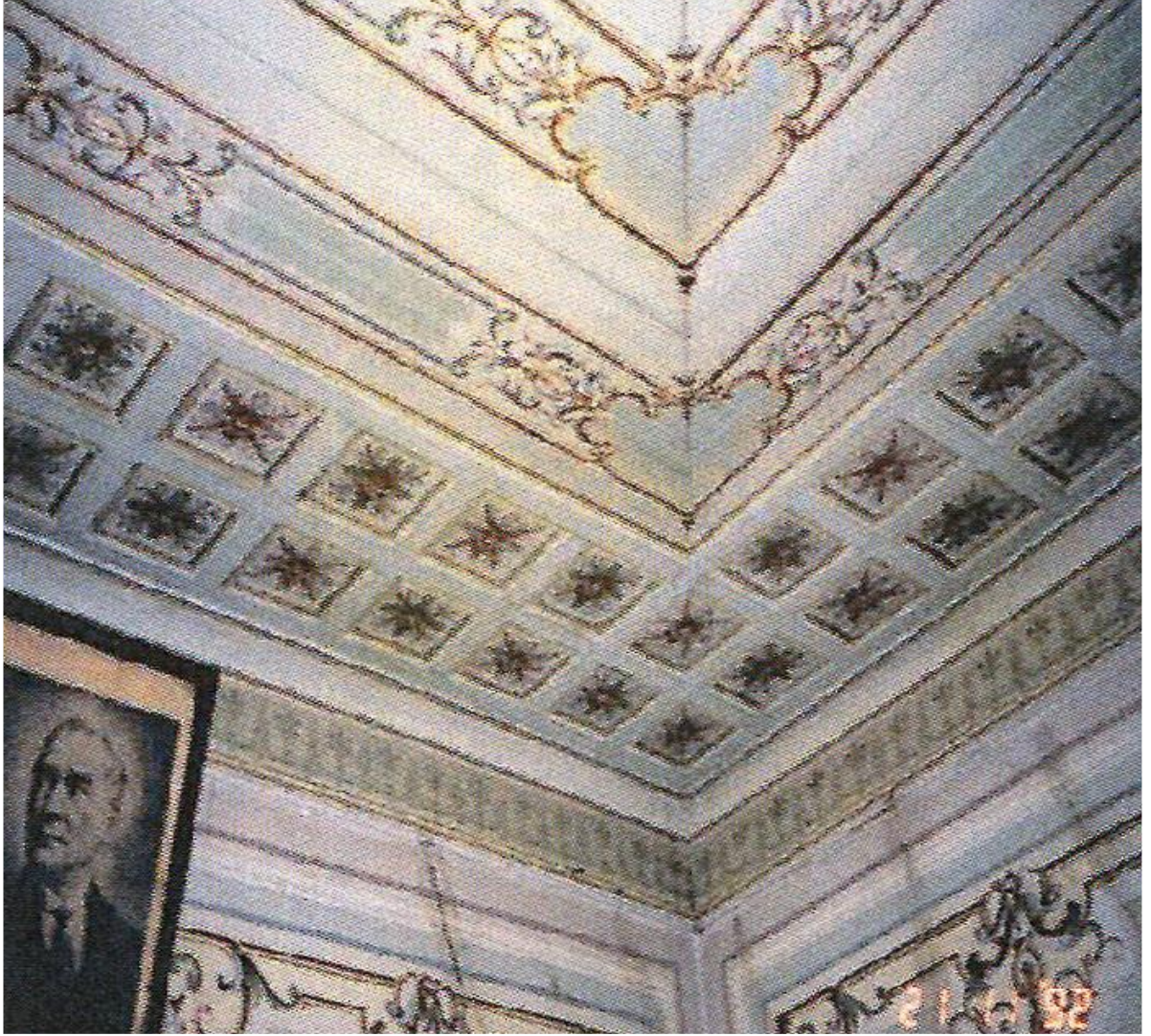
Görsel 129. Üçüncü kat Sofanın Umut Sokak (Sol) tarafında kalan odanın tavan işi işleminin restorasyon öncesine ait görseli (Yapı Merkezi Arşivi).
