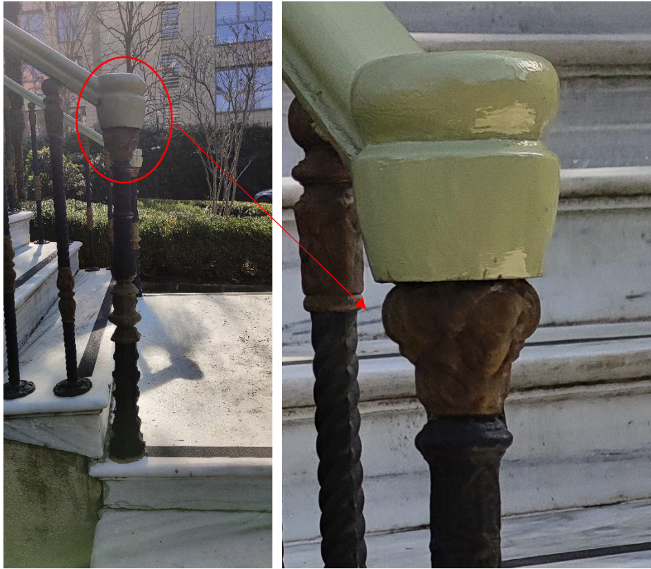
Görsel 66. M1 merdivenlerinde bulunan dökme demir babaların görseli ve başlıktaki surat figürü (Fotoğraf: Sadık Çağrı Bildiş, 2022).
