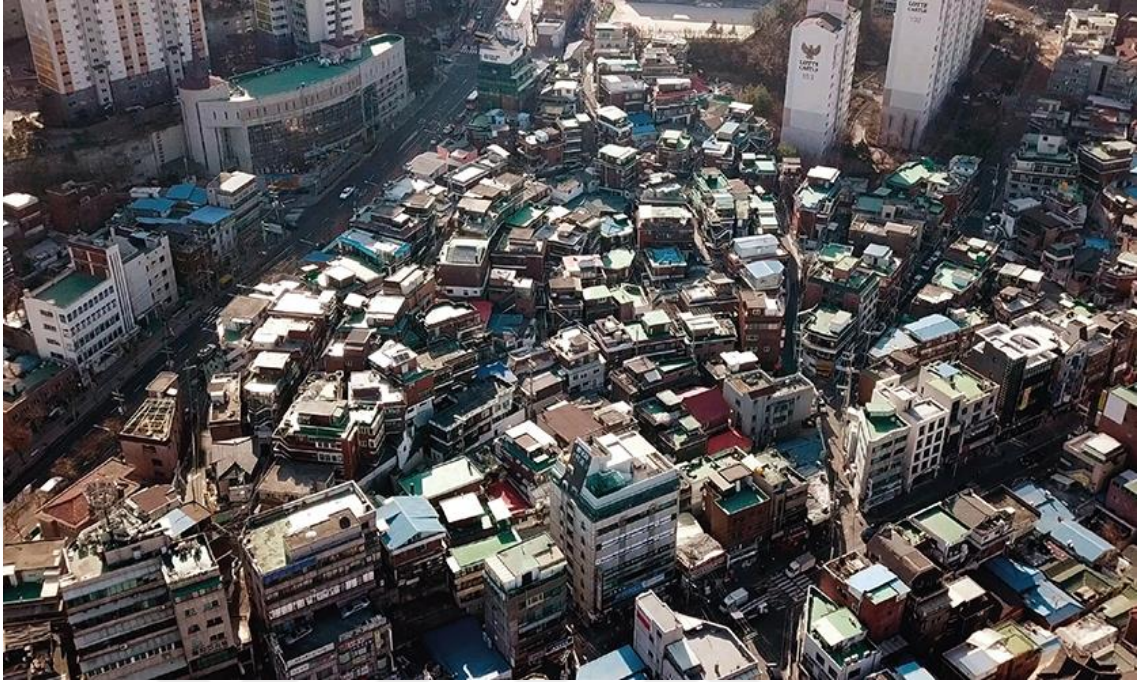
Resim 30: Seul Geumho Dong Mahallesi Hava Görüntüsü
