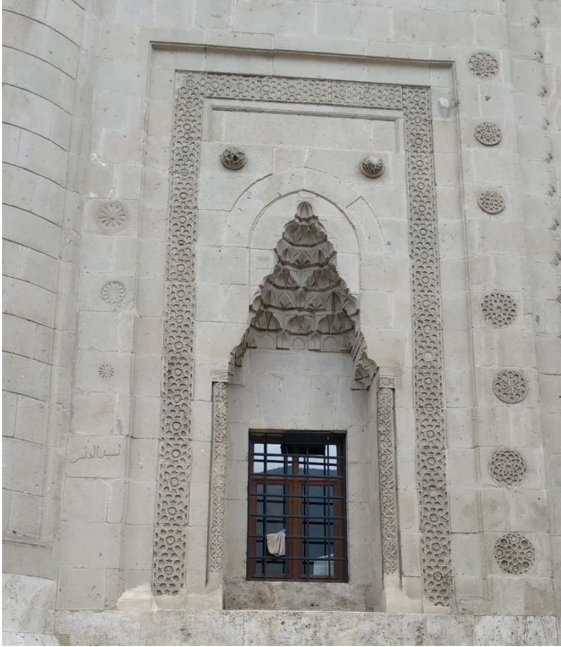
Foto. 50 Giriş Cephesi Doğu Pencere Detayı
