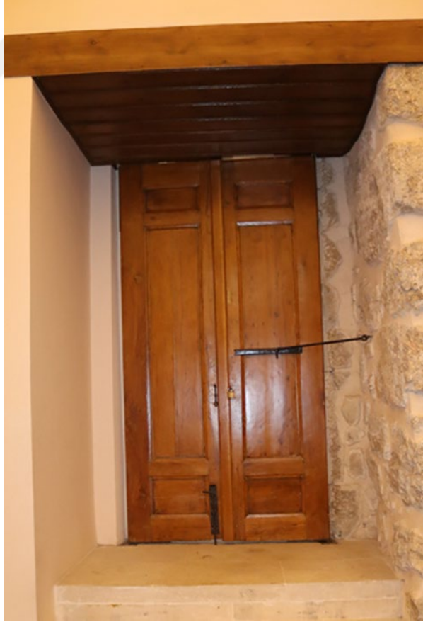
Foto. 36 Doğu Duvarda Bulunan Kapı
