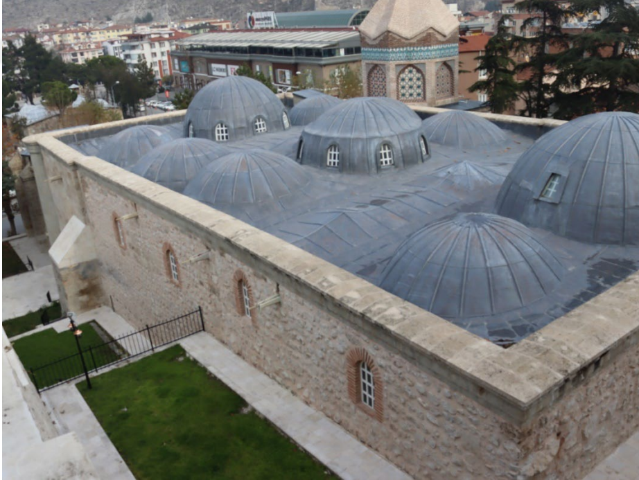
Foto. 18 Cami Batı Cephesi, Genel Görünüm
