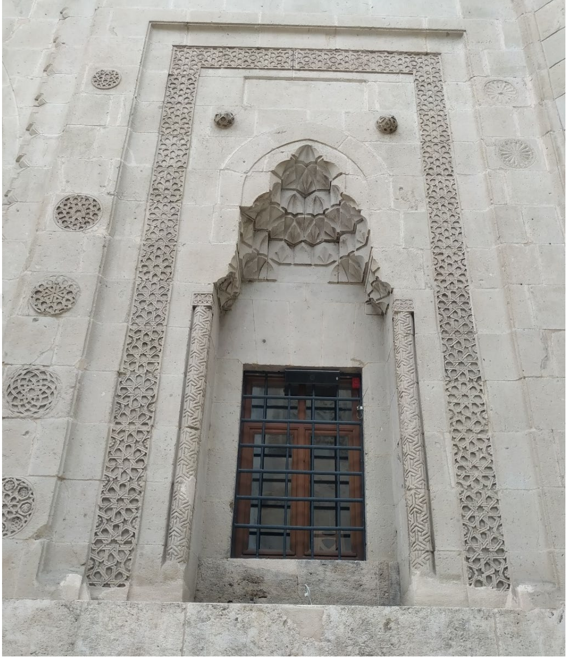
Foto. 51 Giriş Cephesi Batı Pencere Detayı
