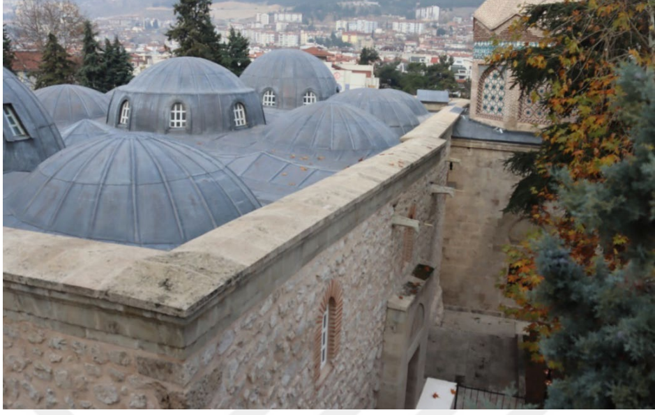
Foto. 14 Cami Güneydoğu Cephesi, Genel Görünüm
