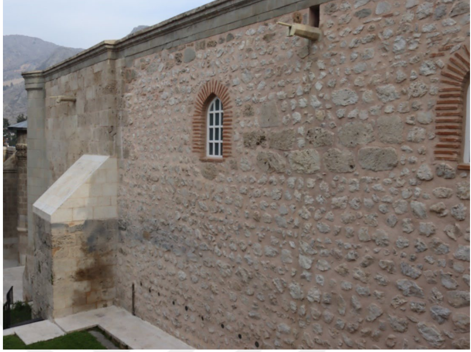
Foto. 21 Batı Cephesi Kuzeybatı Cephesinden, Genel Görünüm
