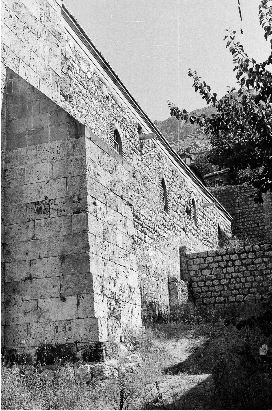
Foto. 76 Gökmedrese Cami Batı Duvar, Destek Paye(VGM Arşivi)
