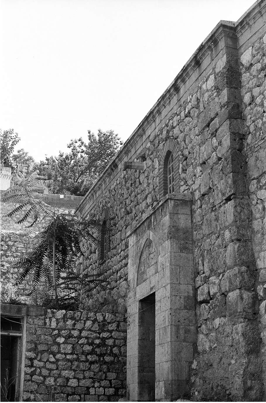
Foto. 77 Gökmedrese Cami Doğu Duvar, Doğu Duvar Giriş Kapı(VGM Arşivi)
