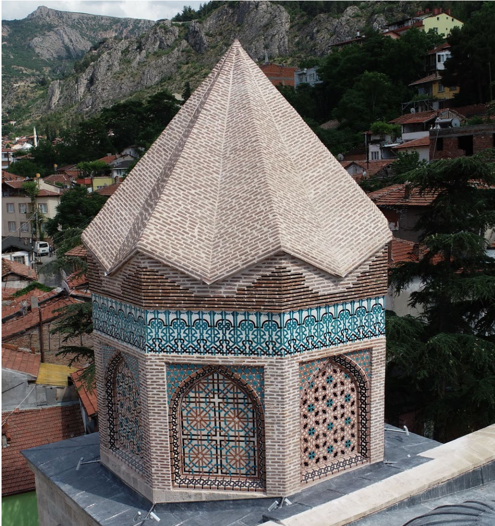
Foto. 66 Gökmedrese Cami Türbe Kasmağı ve Piramidal Kulağı
