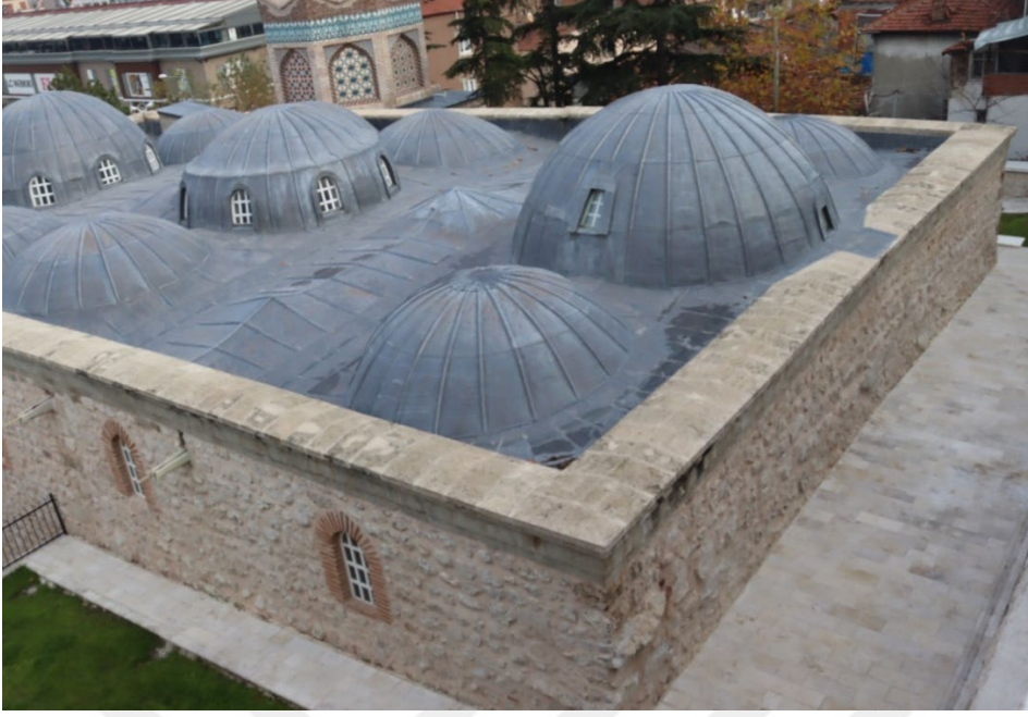
Foto. 23 Cami Güney Cephesi, Genel Görünüm
