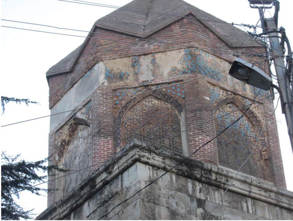
Foto. 7 Gökmedrese Cami Türbesi 2020 Yılına Ait Restorasyon Öncesi Durumu (VGM Arşivi)
