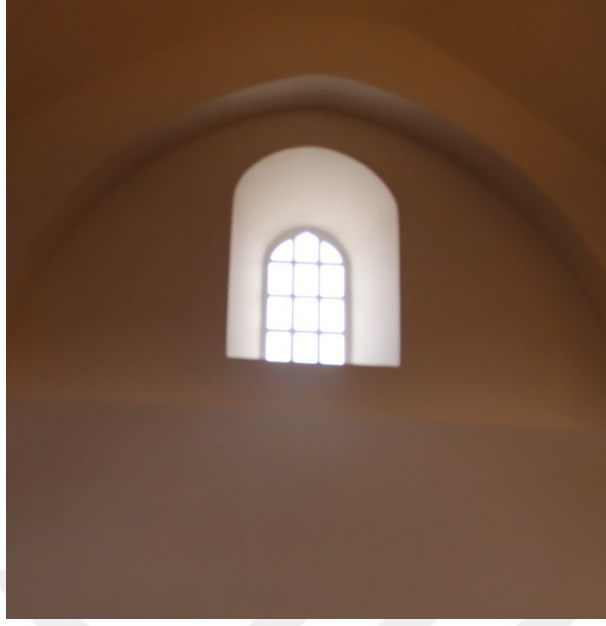
Foto. 35 Doğu Duvardaki Pencere Detayı
