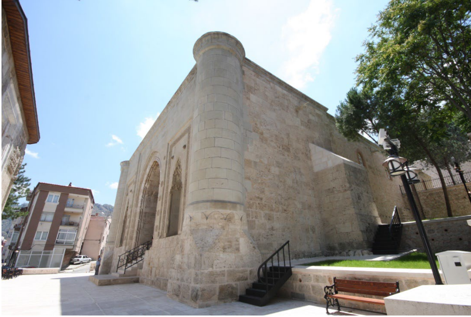
Foto. 24 Caminin Kuzeybatı Cephesi, Genel Görünüm (VGM Arşivi)
