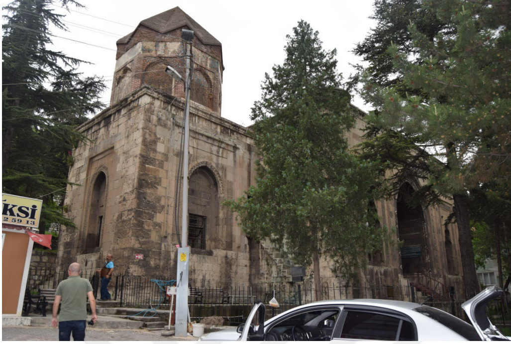
Foto. 6 Gökmedrese Cami 2020 Yılına Ait Restorasyon Öncesi Durumu Kuzeydoğudan Giriş Cepheye Bakış (VGM Arşivi)
