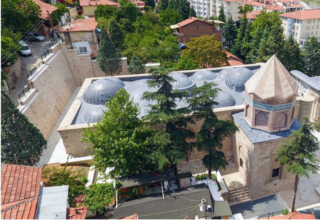
Foto. 13 Cami Doğu Cephesi, Genel Görünüm
