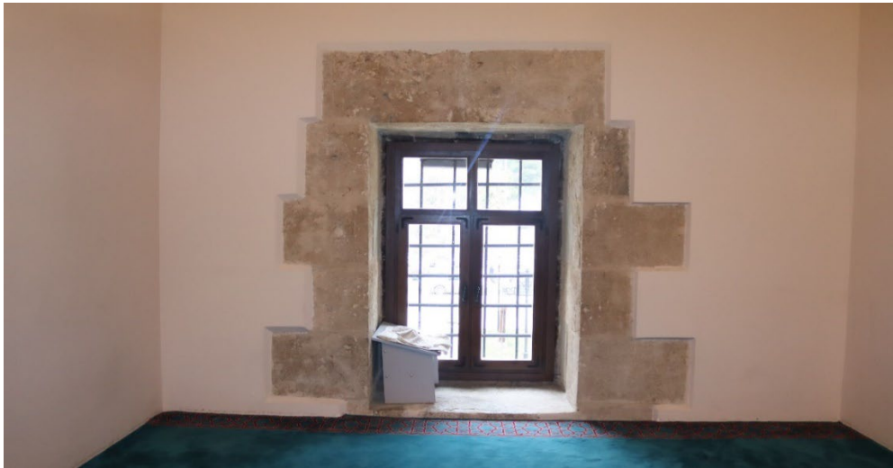
Foto. 28 Kuzey Cephedeki Pencere Detayı
