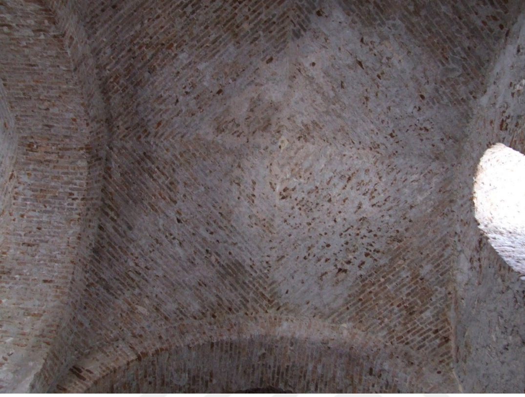
Foto. 44 Tonoz ve Kemer Detayı
