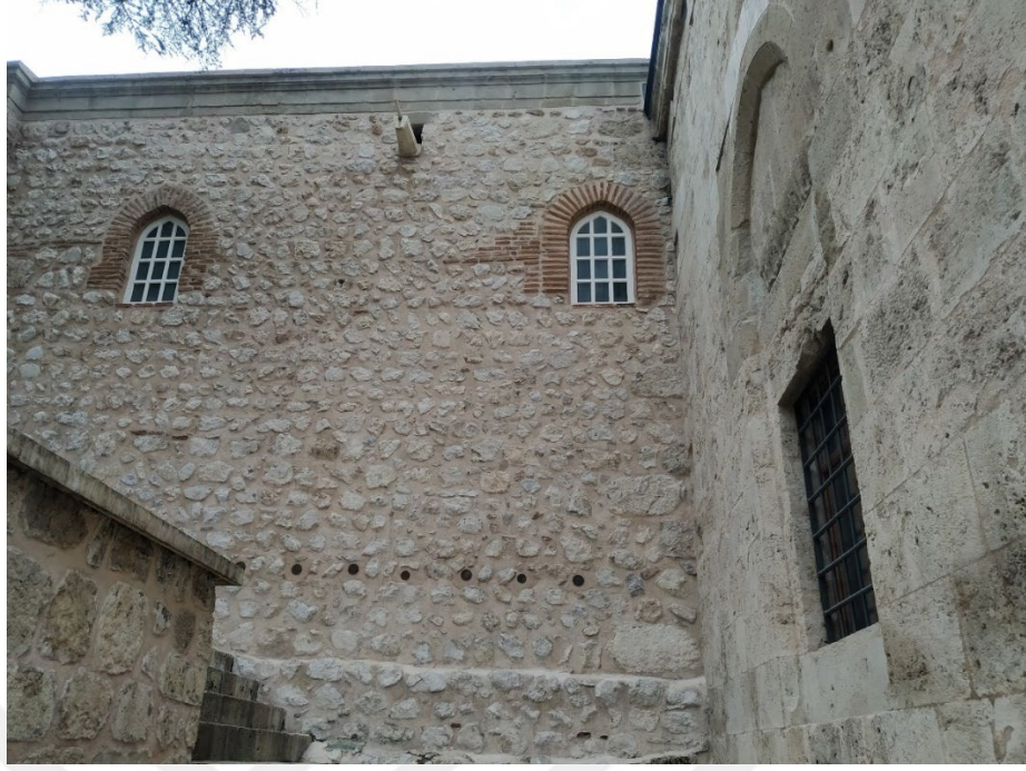
Foto. 17 Gökmedrese Cami Doğu Cephesindeki Çörten ve Pencereleler
