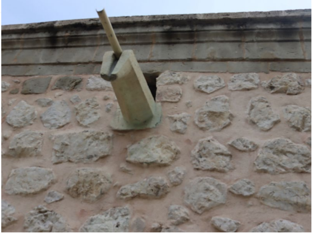
Foto. 22 Gökmedrese Camisi Çörten Detayı
