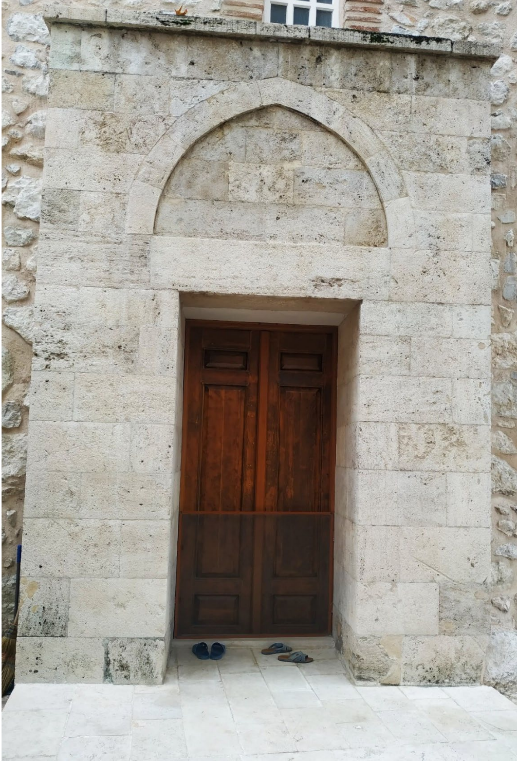
Foto. 16 Gökmedrese Camisi Doğu Cephesindeki Kapı
