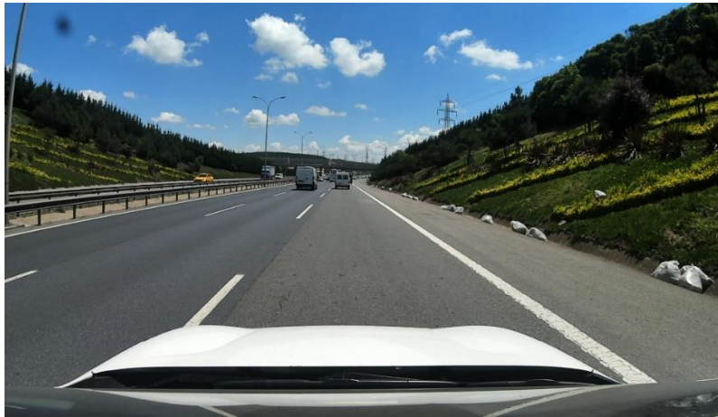
Şekil 2.1. Kuzey Marmara Otoyolu
