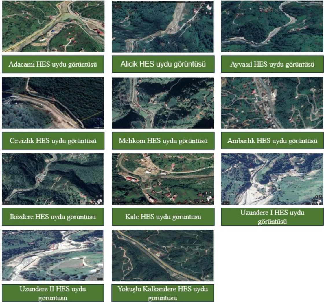
Şekil 2. Hidroelektrik santralleri uydu görüntüsü
