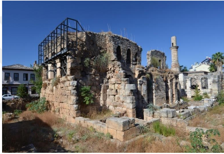
Şekil 28. Kesik Minare'nin Restorasyon Öncesi Güçlendirme Çalışması (2007)
