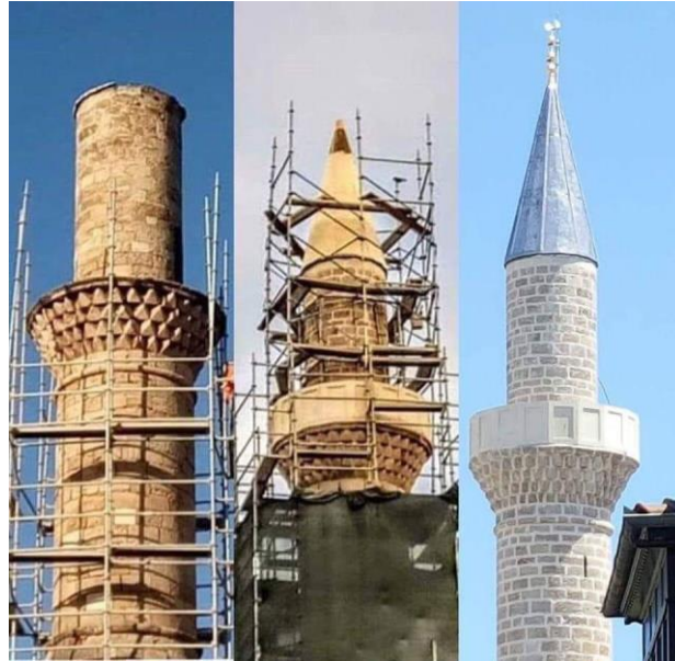
Şekil 29. Kesik Minare / Minarenin Restorasyonu
