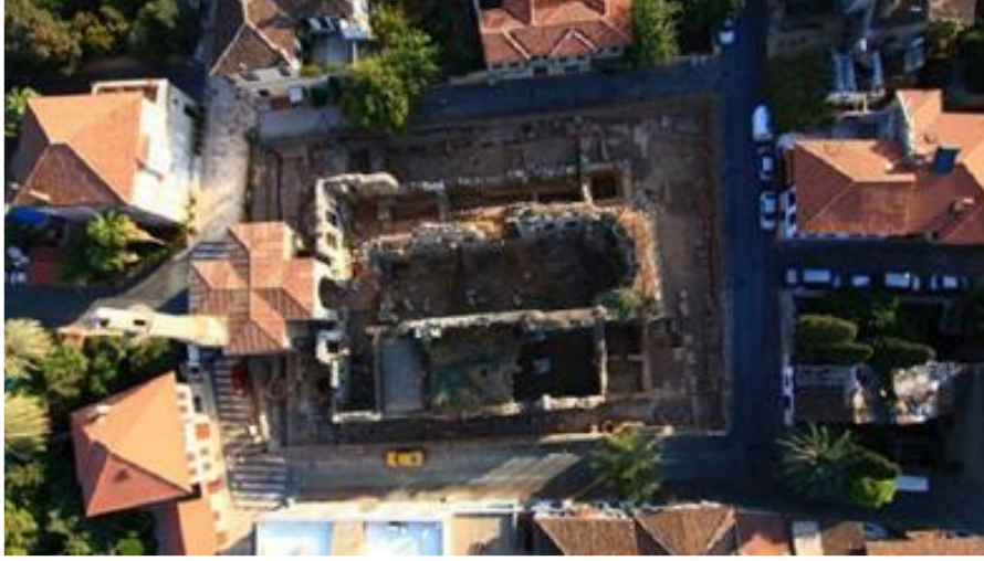
Şekil 27. Kesik Minare'nin Müdahale Öncesi Üstten Görünüşü
