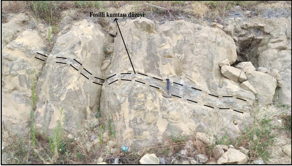
Şekil 3.17. Tepeköy kuzeyinde bulunan kumtaşı ve fosilli düzeyin genel görünümü. Koordinat: 35T, 0725141D, 04506966K
