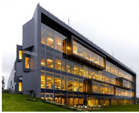
Şekil 117. Turkcell kampüsü binasının dış sığınak alanları
