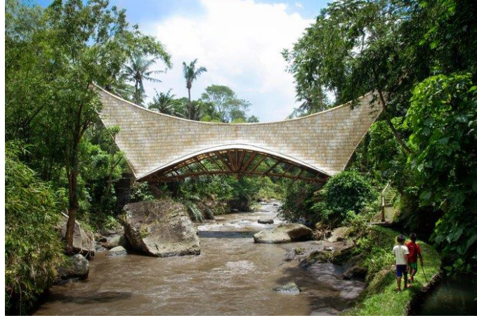
Şekil 24. Yeşil okulda suyun varlığı
