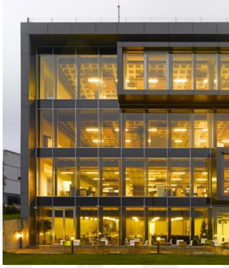
Şekil 108. Cephedeki açılan pencereler binanın doğal havalandırılmasını sağlar
