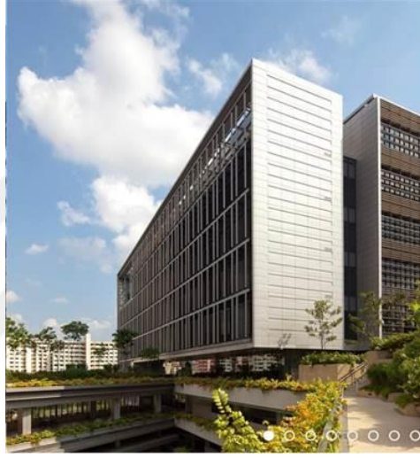
Şekil 7. Hastane binasının ön cephesinden bir görüntü
