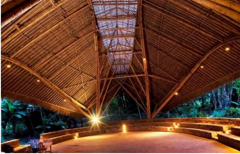
Şekil 23. Yeşil okulun içinden görünüm
