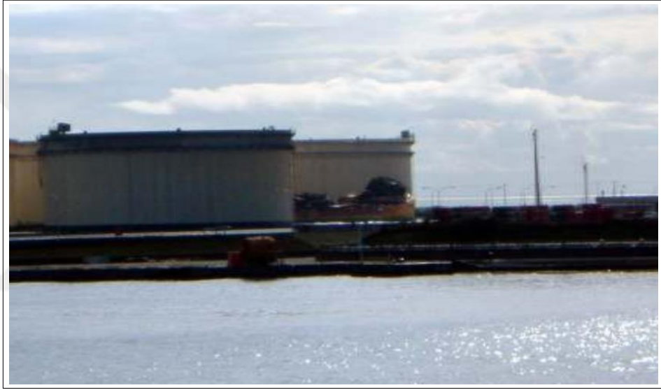
Şekil 2.16: Tohoku depreminin ardından tank hasarı.
