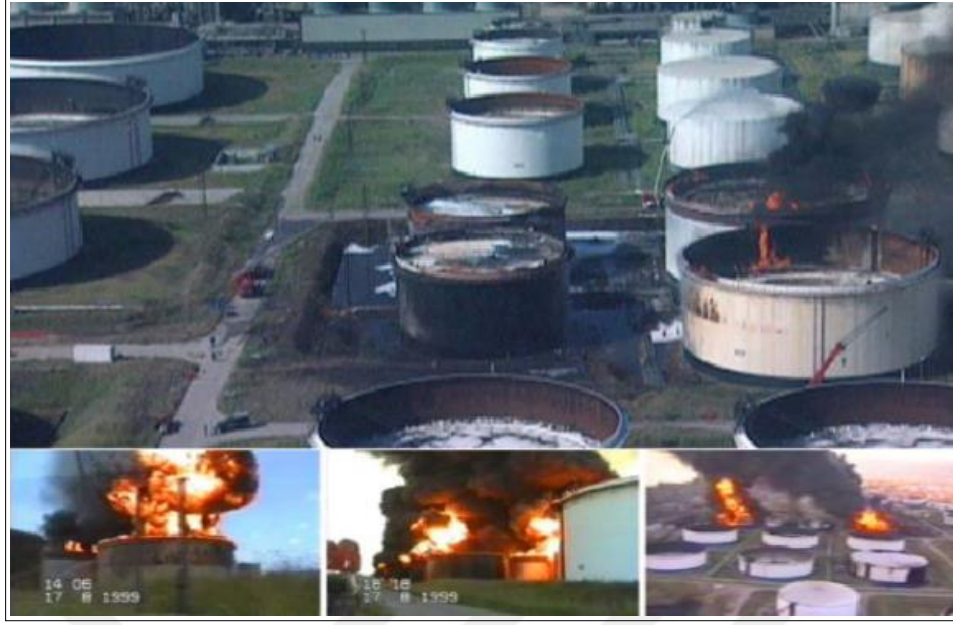
Şekil 2.5: Tüpraş rafinerisi hasar görmüş tanklar (17 Ağustos, 1999).
