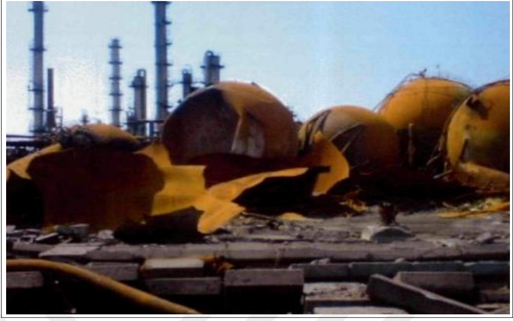
Şekil 2.14: Tohoku depreminden etkilenen lpg tank sahası.
