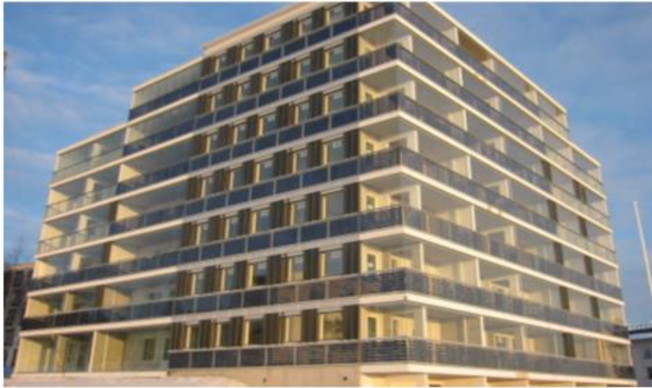
Şekil 3.4. Balkon korkuluklarında FV sistemin kurulumu (Ceylan, 2018)
