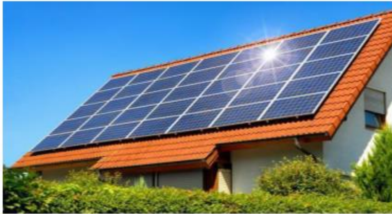
Şekil 3.1. Eğimli çatıya monte edilen FV sistemler (Yücel, 2016)
