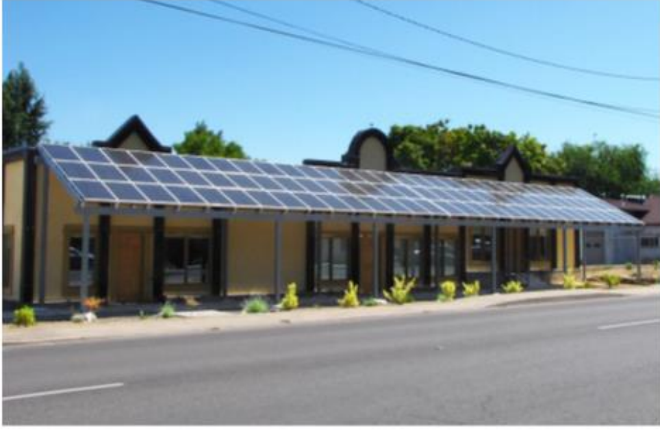
Şekil 3.5. Sundurma çatı üzerinde kurulan FV sistem
