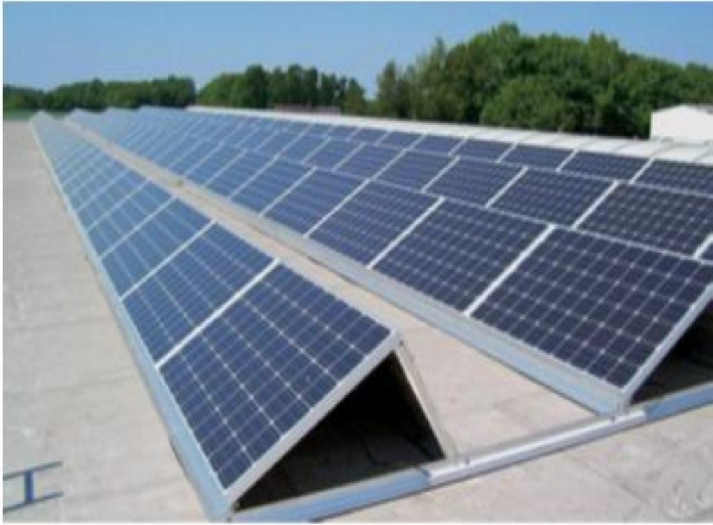
Şekil 3.2. Düz çatıya monte edilen FV sistemler (Şençiçek, 2017)
