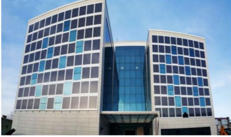
Şekil 3.3. Bina cephelerine monte edilen FV sistem (Atlım, 2019)
