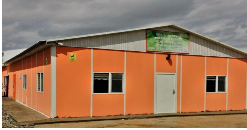
Şekil 7. Bingöl Tıbbi Atık Sterilizasyon Tesisi
