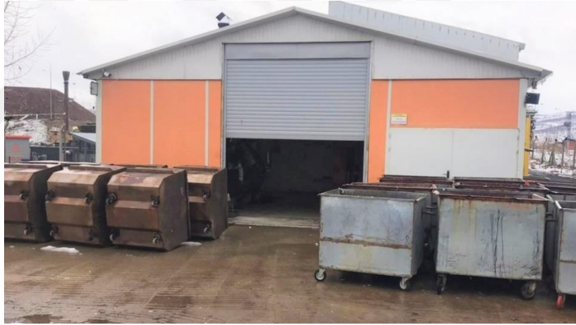
Şekil 8. Sterilizasyon Ünitesi Araç Giriş Kapısı ve Konteynerler
