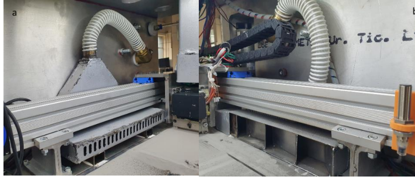
Şekil 5.47. Kabin içi gaz bağlantıları ve üfleç ızgaraları a) kabin sol kısmı üfleme b) kabin sağ kısmı çekme
