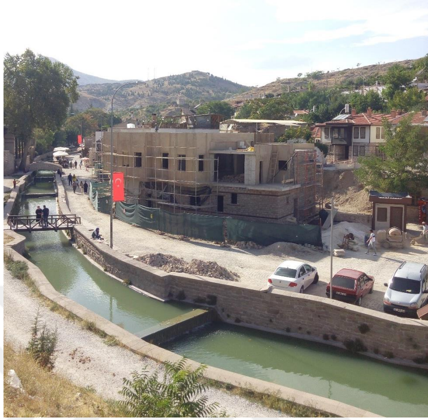
Fotoğraf 16. Silles Antik Kenti İçerisindeki İnşaat Faaliyetinin Görüntüsü (Yazar Tarafından 20/09/2020 Tarihinde Görüntülenmiştir)
