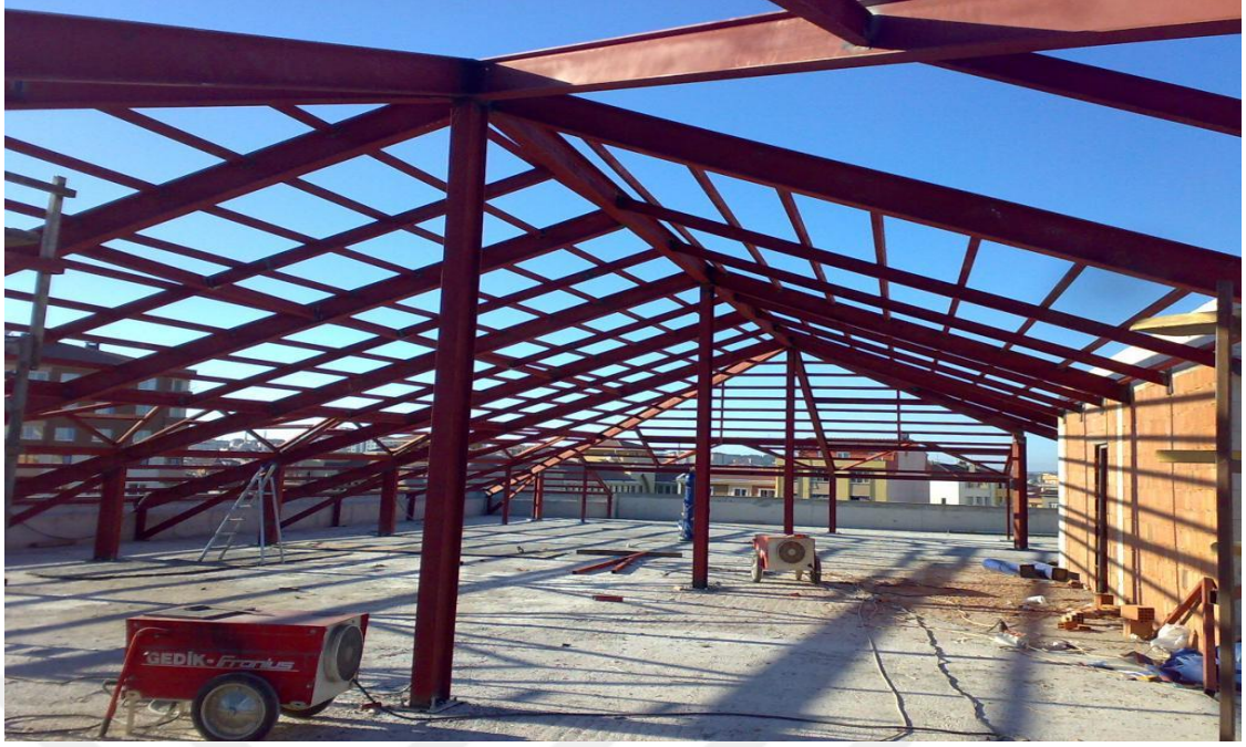
Şekil 2.115. Çelik Çatı Profili
