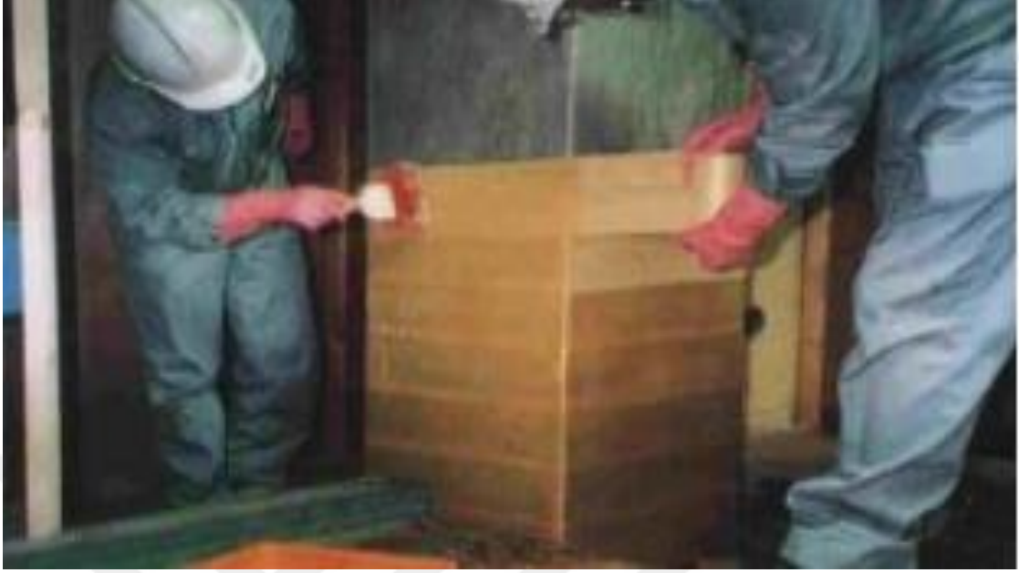
Şekil 2.60. Kolonun Aramid elyaf takviyeli mantolaması
