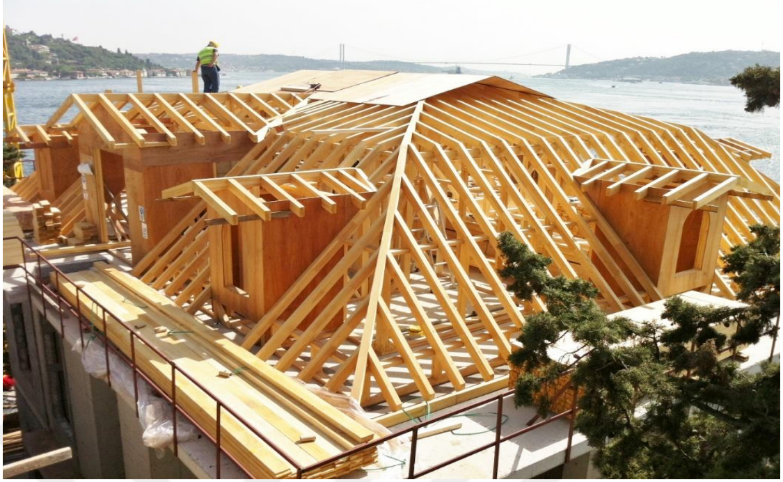
Şekil 2.114. Ahşap Çatı Profili
