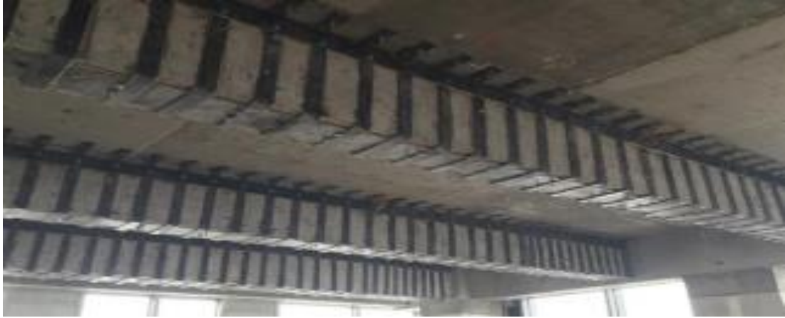
Şekil 2.61. RC Kiriş İçin Çelik Profil İskelet Mantolaması
