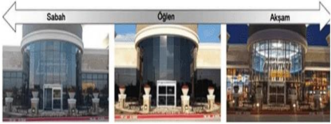
Şekil 2.143. Termokromik bir camın günün farklı saatlerinde görünümü
