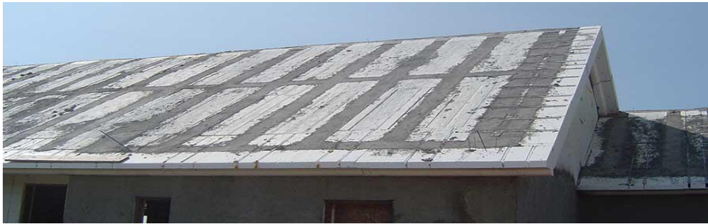
Şekil 2.112.. Betonarme Çatı Profili
