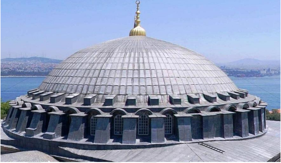
řekil 2.102. Kubbe Çatı
