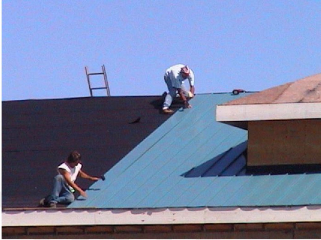
Şekil 2.116. Çatı Kaplamada Tabaka İşlemi
