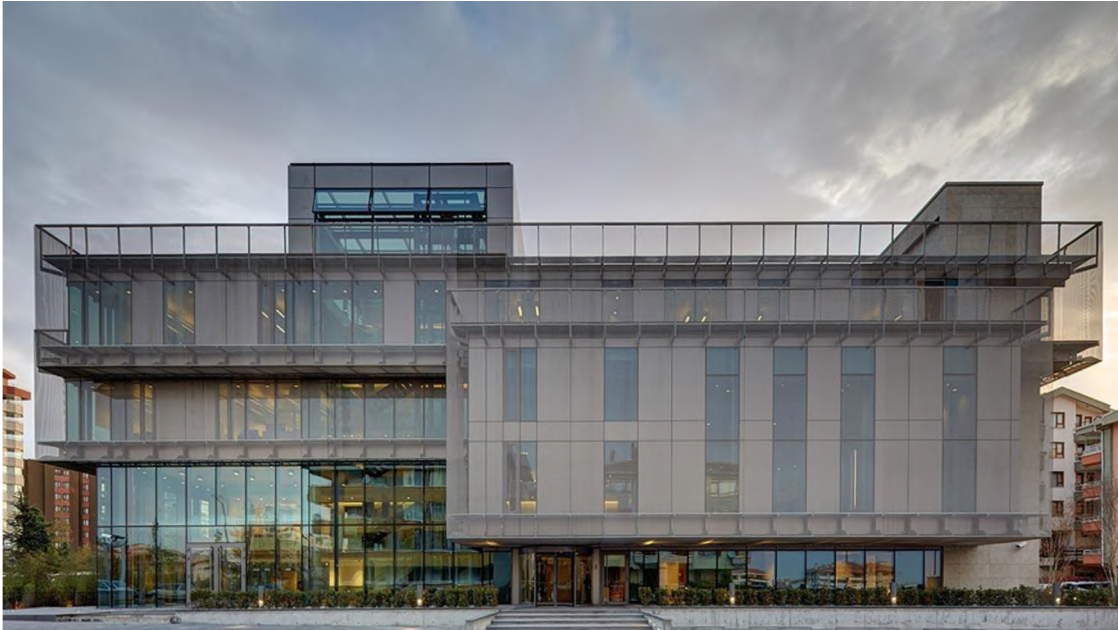
Şekil 5.36: Dış Cephe Görünümü, TMB Merkez Binası (Özkazanç, 2013)
