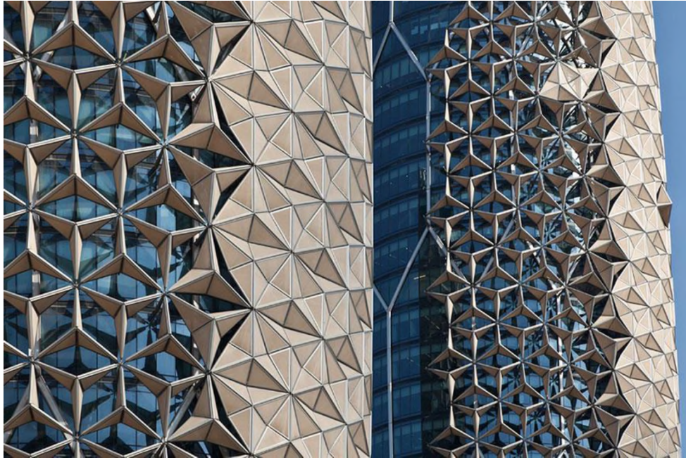
Şekil 4.19: Dinamik Kontrollü Cephe Örneği, Al Bahar Kuleleri (Demirel, 2016)
