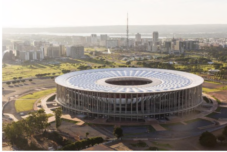
Şekil 4.25: Fotokatalitik Membran Örneği, Ulusal Mane Garrincha Stadyumu, Brezilya (gmp Architekten)
