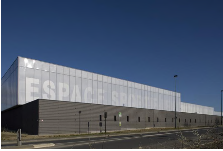
Şekil 5.9: Cephede Aerjel Dolgulu Panel Kullanımı, Souchais Spor Kompleksi (Chalmeau, 2022)
