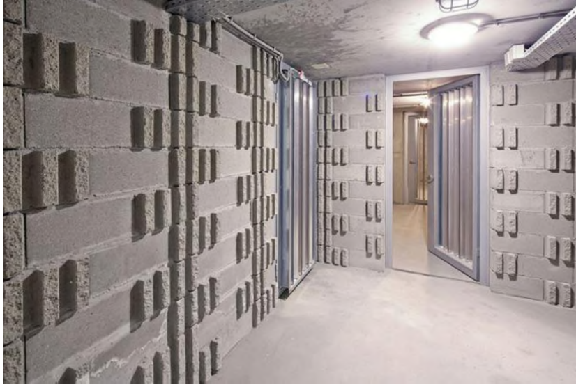
Şekil 5.38: Termal Labirent Sistemi Koridoru, TMB Merkez Binası (Özkazanç, 2013)
