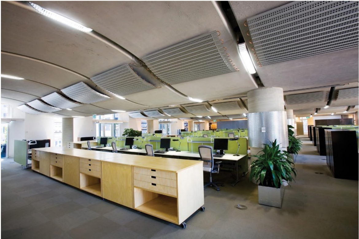
Şekil 5.19: Dalgalı Tavan ve Soğuk Kiriş İç Mekan Görüntüsü (Hannah, 2013)
