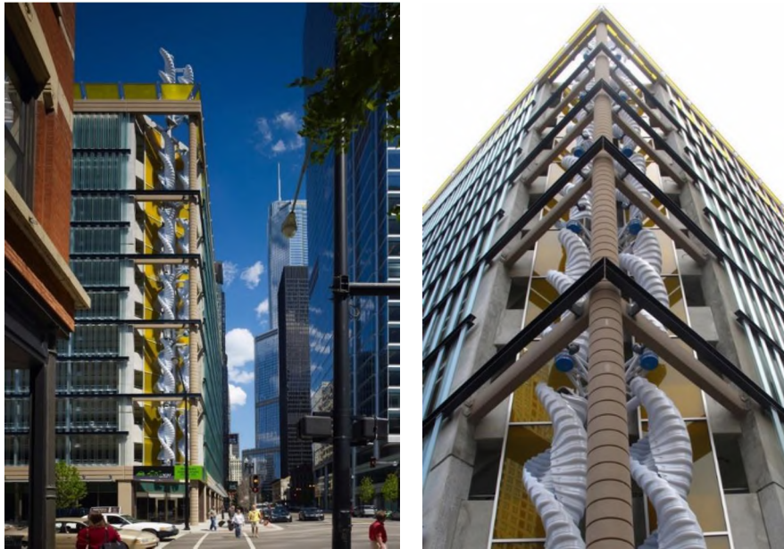
Şekil 4.18: Düşey Eksenli Rüzgar Türbin Örneği, Greenway Self-Park (Architizer) (Archdaily)
