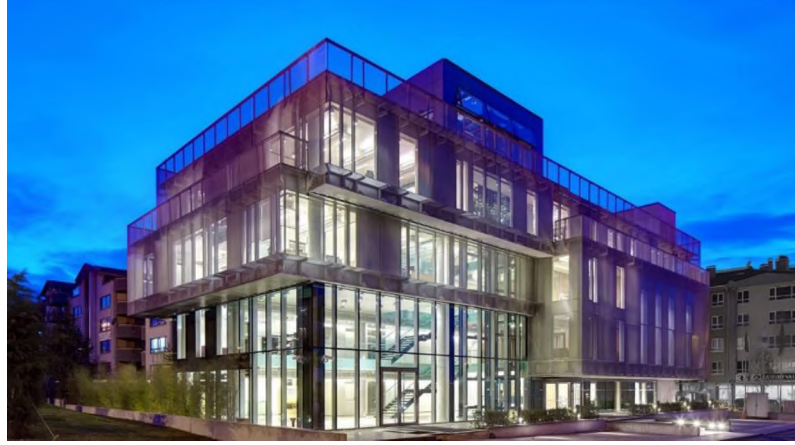
Şekil 5.37: Dış Cephe Görünümü, TMB Merkez Binası (Özkazanç, 2013)
