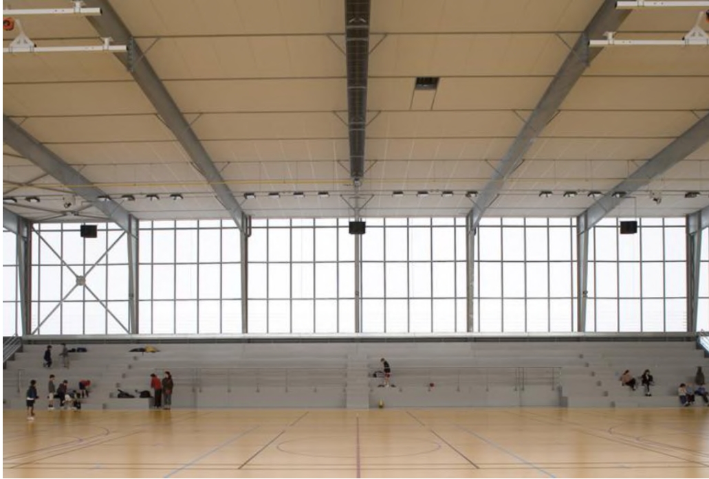
Şekil 5.8: Aerojel Dolgulu Panellerin İç Mekana Etkisi, Souchais Spor Kompleksi (Chalmeau, 2022)
