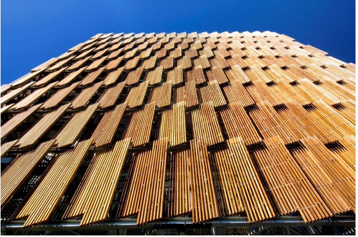
Şekil 5.20: Batı Cephesinde Bulunan Güneşe Göre Açılır-Kapanır Ahşap Panjurlar, Council House 2 (Snape, 2013)
