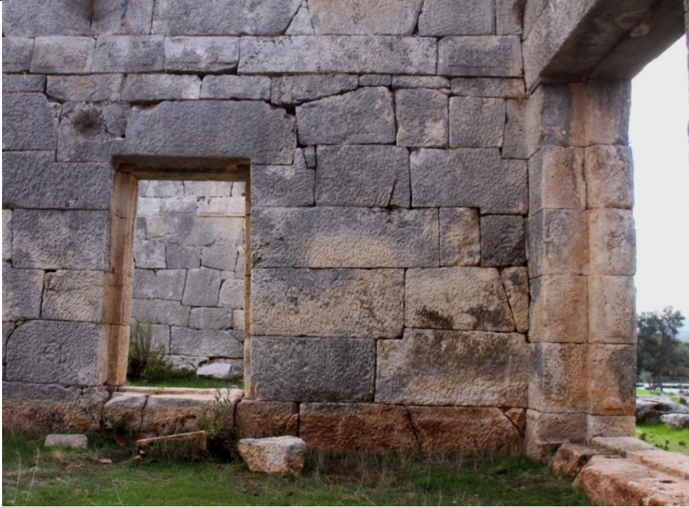
Resim 38. Horrea Hadriani, G1 nolu oda batı duvar kapı ve kapı eşik detayı, Myra ve Andriake Kazıları Arşivi, 2010.
