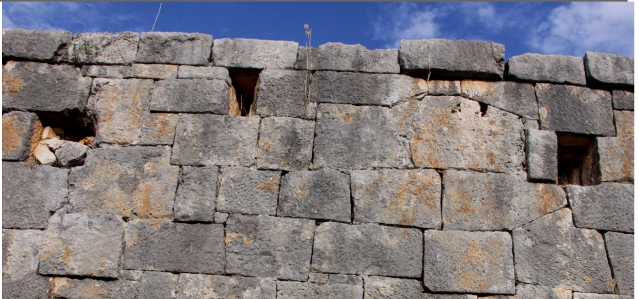
Resim 8b. Horrea Hadriani G1 nolu oda doğu 2b, Havalandırma Boşlukları, Myra ve Andriake Kazıları, 2010.
