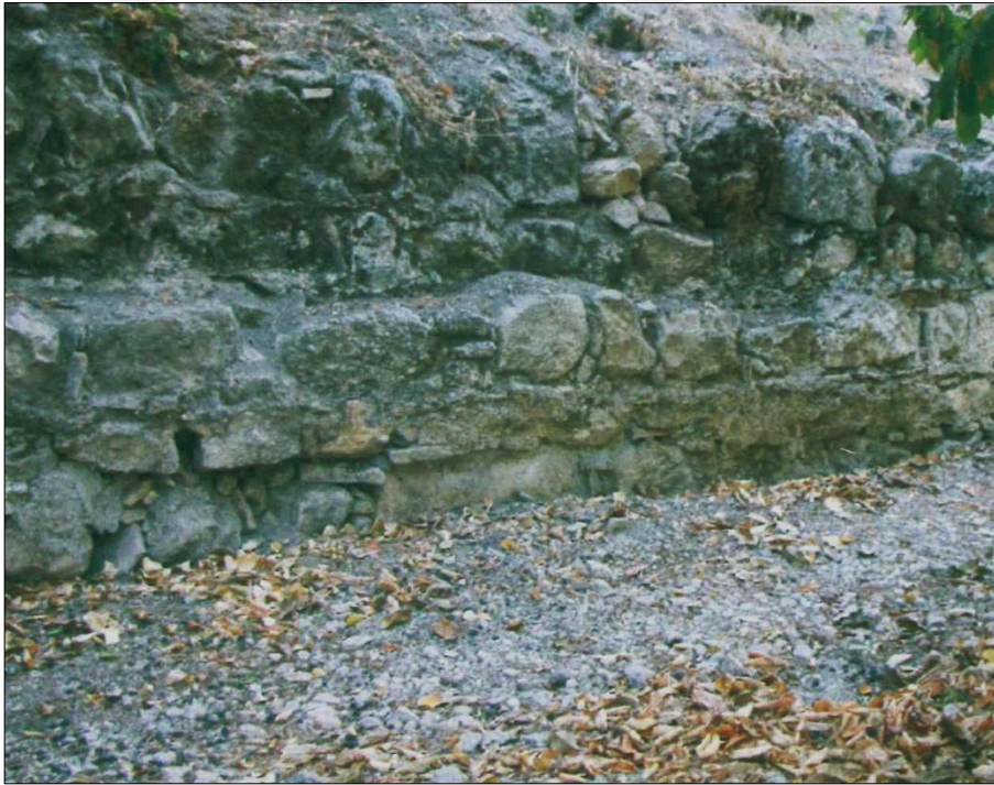
Res. 24. Sultan Yaylası, Teraslarda gözlemlenen On Üçüncü Yüzyıl Kireç Harçlı Duvar Kalıntısı. Kaynak: Tok, 2012
