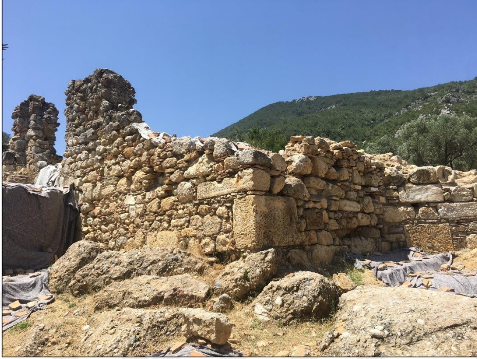
Res. 10. Başpınar Bizans Yapıları, Malzeme-Duvar Tekniği
