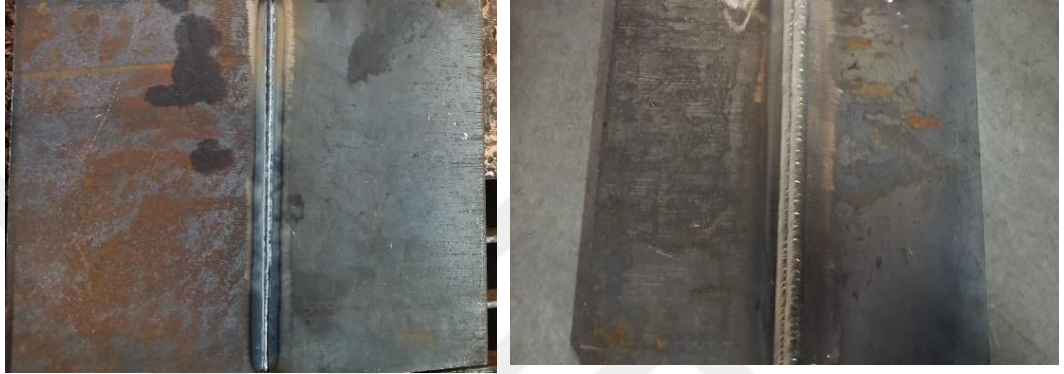
Şekil 9.21 Kök paso ve kapak paso.
