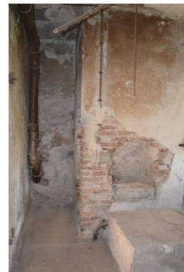
Görsel 128. ve 129. Bira Fabrikası Hamamı Bodrum Katı Su Tesisat Boruları (Kişisel arşiv, 2020).
