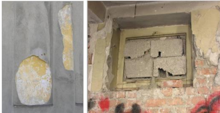
Görsel 120. ve 121. Bira Fabrikası Hamamı'nın Özgün Malzemeleri (Kul, 2012).
