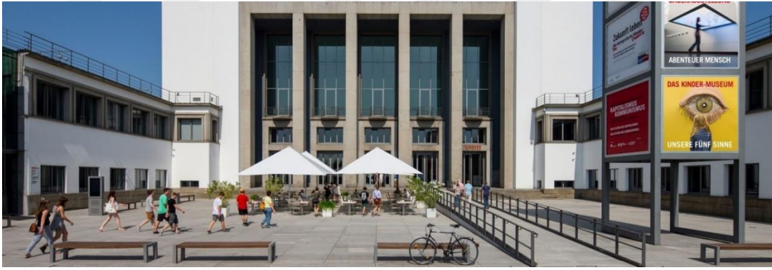
Görsel 52. 2006 Yılında Restorasyonu Tamamlanan Dresden,Hijyen Müzesinin Ana ve Ek Binalarının Cephe Görünümü. Erişim: 20.04.2021, https://www.dhmd.de/en/your-visit/ .
