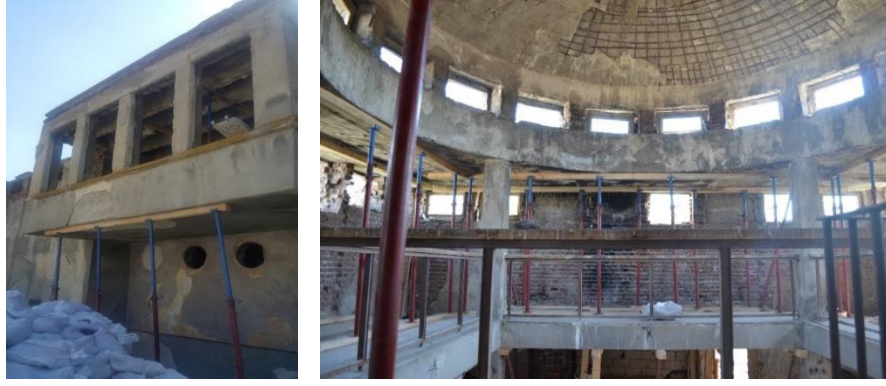
Görsel 118. ve 119. Güçlendirilmesi Yapılan Bira Fabrikası Hamamının İç ve Dış Cephelerden Görünümü (Kişisel arşiv, 2020).
