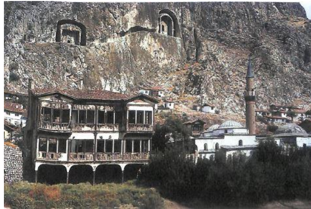
Görsel 26. Amasya - Hazeranlar Konağı'nın Onarım Öncesi Durumu (Ahunbay, 1996).
