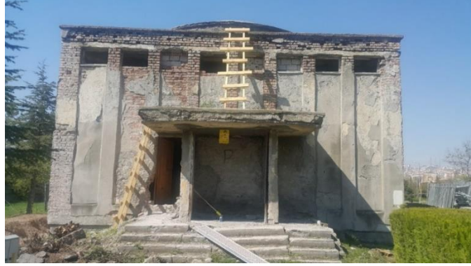
Görsel 137. Bira Fabrikası Hamamı, Güney Cephesi (Kişisel arşiv, 2020).
