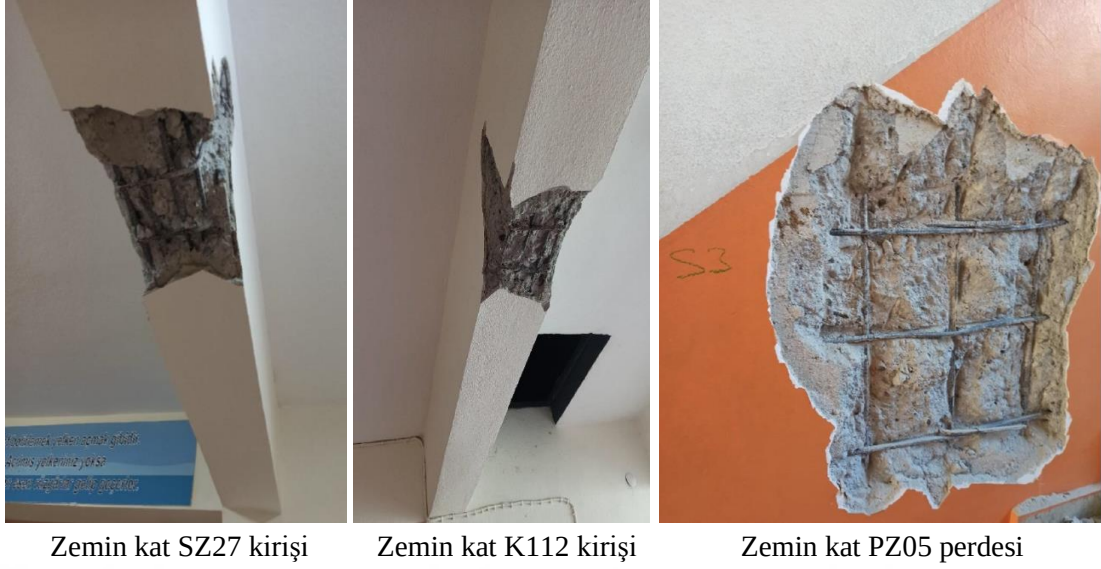
Şekil 3.17. Kalaycılar ilkokulunun bazı betonarme duvar ve kirişlerinde uygulanan sıyırma işleminden görünümeler.
