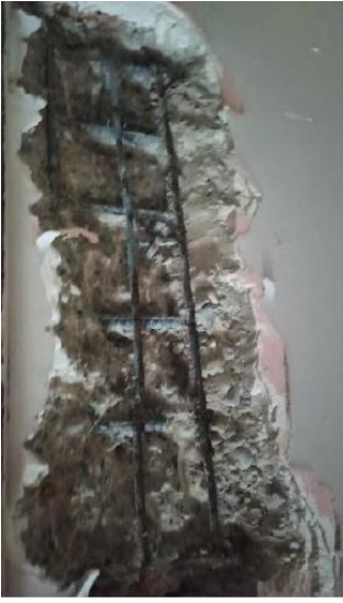
Zemin kat SZ14 kolonu
