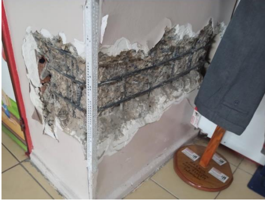
Zemin kat SZ19 kolonu
