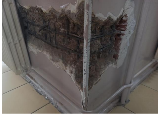
Zemin kat SZ28 kolonu
