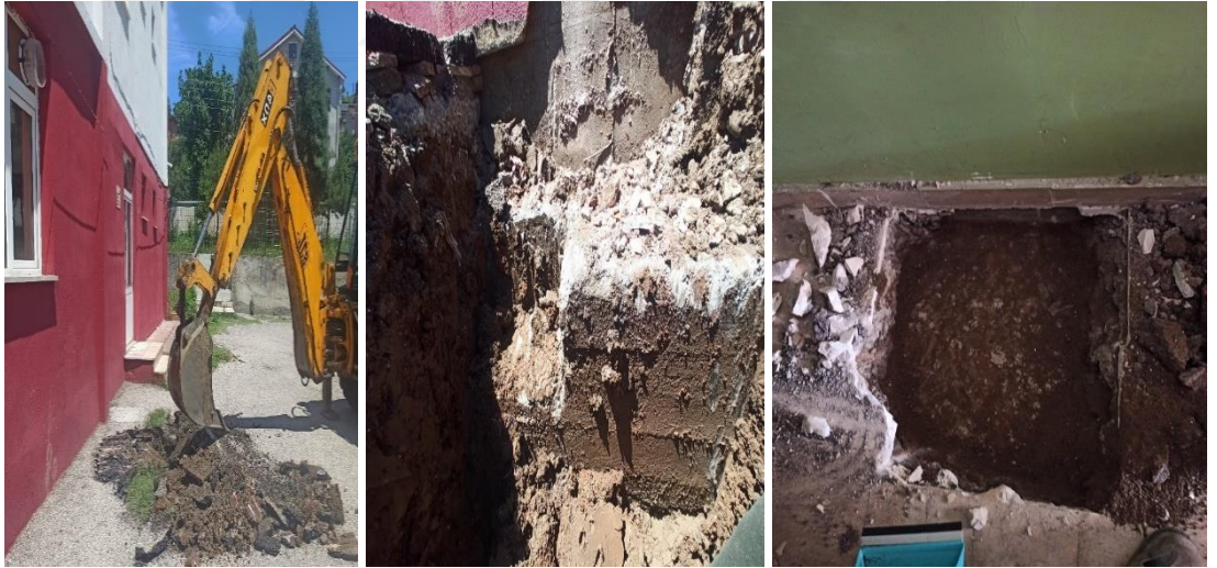
Şekil 3.14. Kalaycılar ilkokulunda temel muayene çukuru açılmasından görüntüler.
