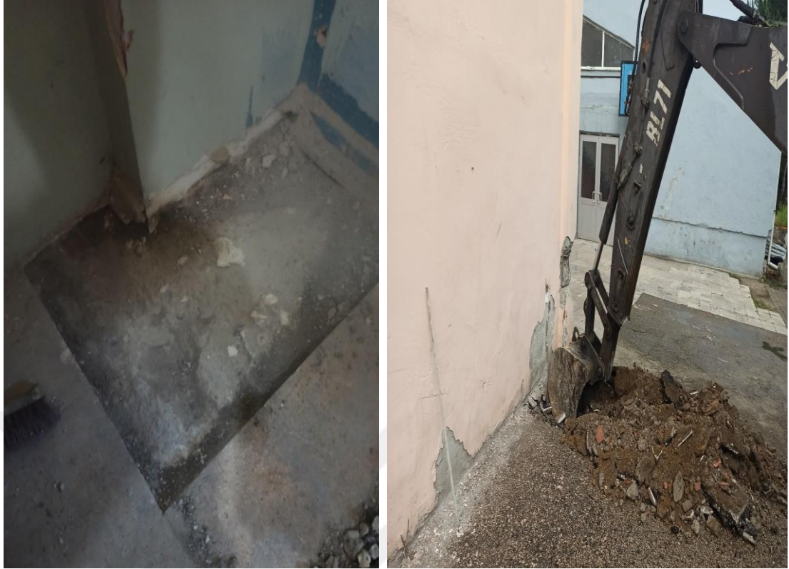
Şekil 3.5. Misakı Milli ilkokulunda temel muayene çukuru açılmasından görünümler.
