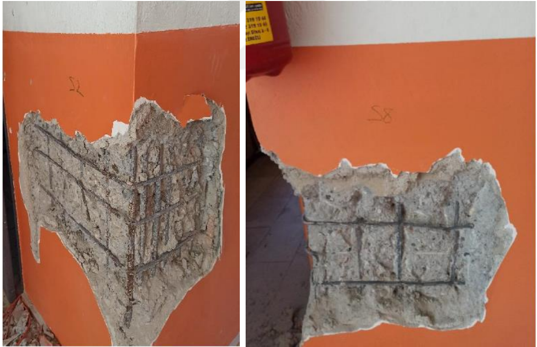
Zemin kat SZ13 kolonu
