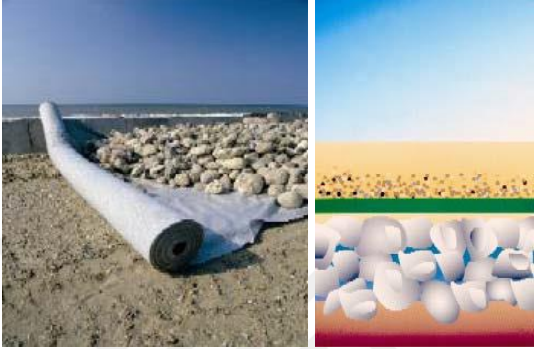
Şekil 10. Destek ve Ayırıcı Olarak Kullanılan Geotekstil (Töremiş, 2003)
