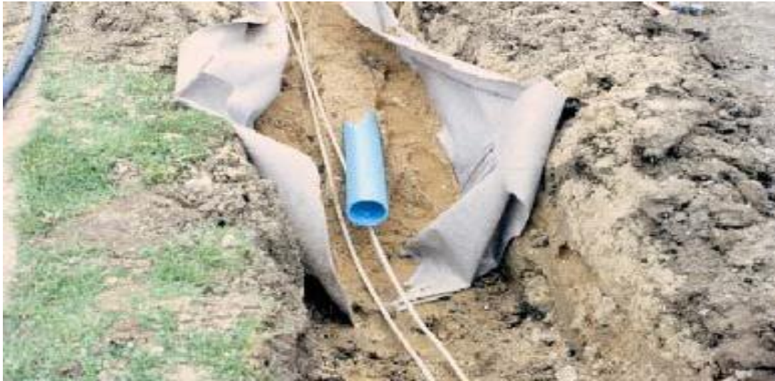
Şekil 11. Filtre amaçlı kullanılan geotekstil (Töremiş, 2003)
