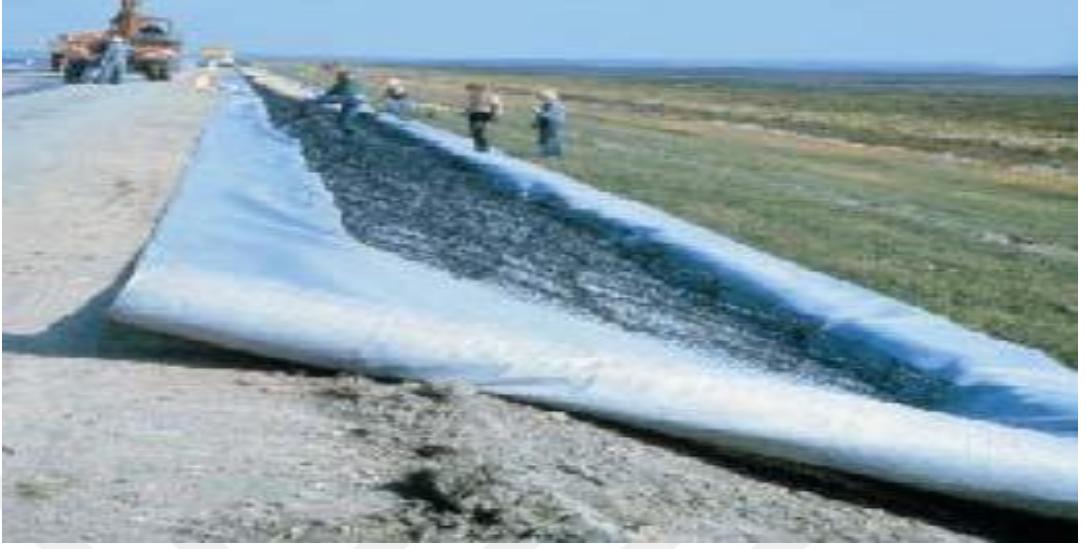
Şekil 12. Drenaj Amacı ile Kullanılan Geotekstil (Töremiş, 2003)
