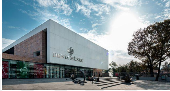
Şekil 3-2.İstanbul Deniz Müzesi, Giriş Cephesi (bkz.Url-24)
