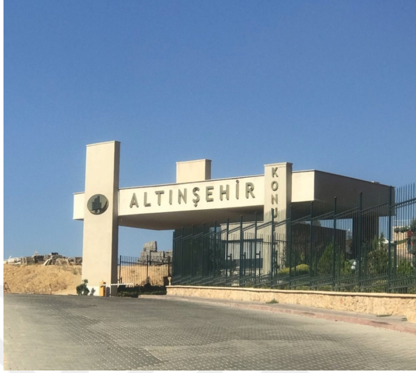
Şekil 3.3 Site girişi / güvenlik noktası
