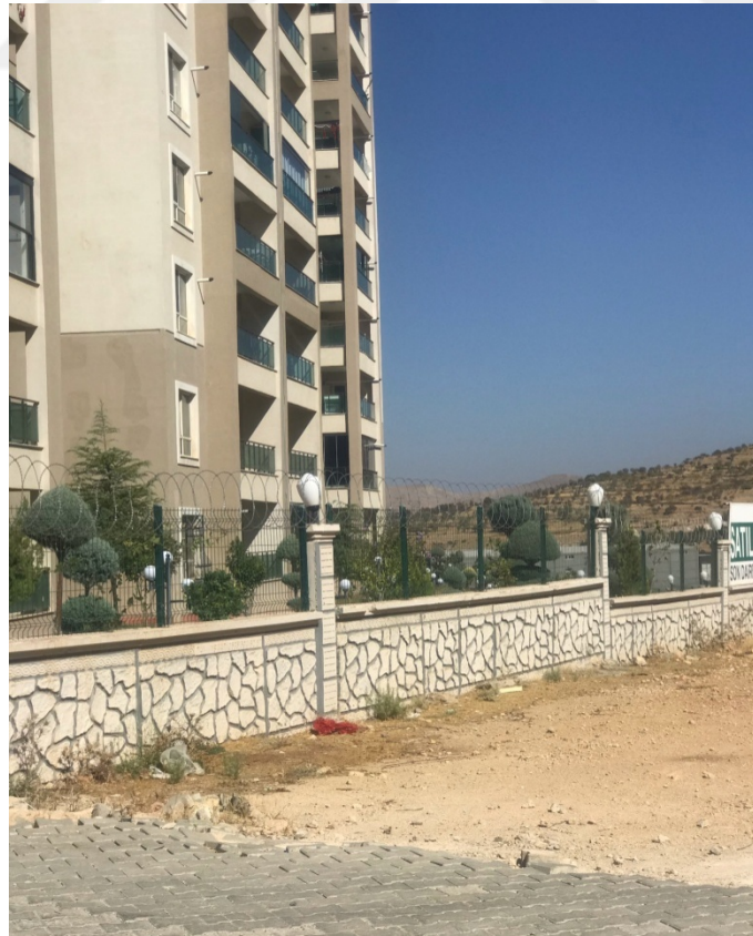
Şekil 3.14 Bahçe dış duvarı
